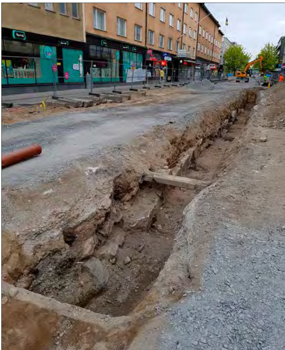
Figur 15. Schakt 1 med kyrkogårdsmuren och där bakom ses husgrunderna A6 och A7 från senare tid (se figur 8 och 10).
