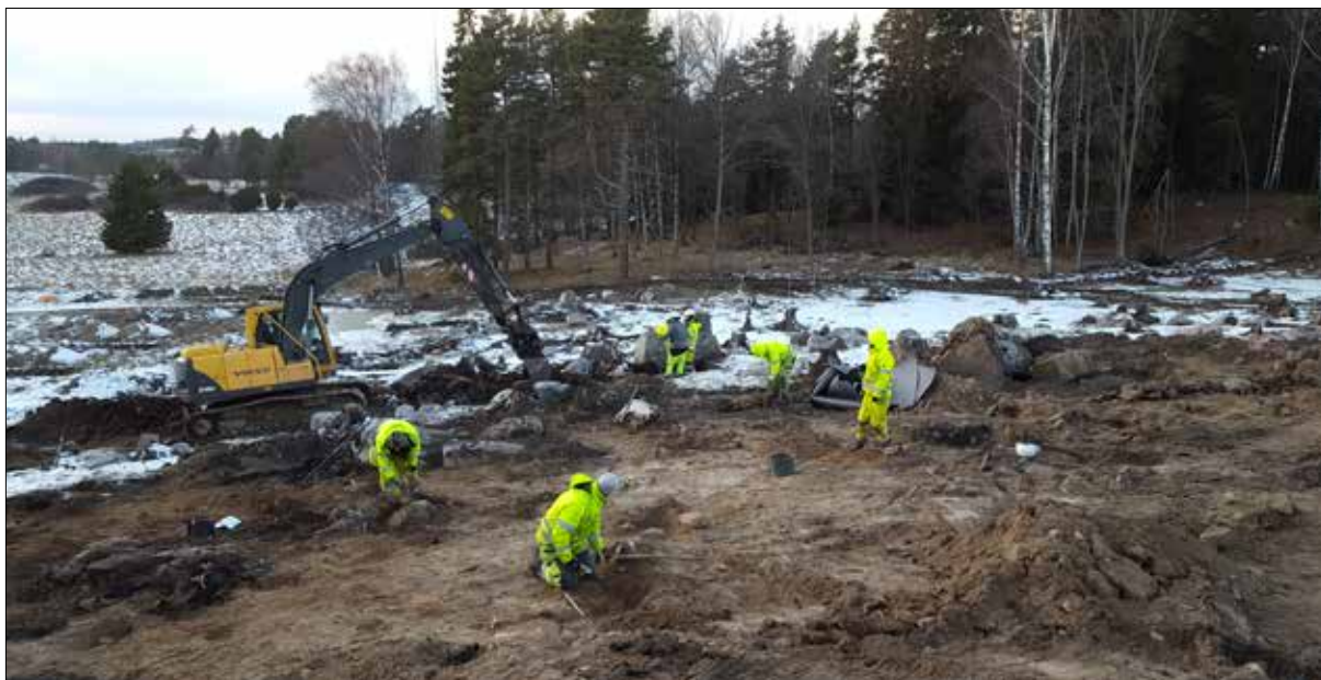
Figur 13. Djupschaktning vid övre terrassen, terrasseringslagret borttaget. Foto från nordöst av Ann Vinberg.
