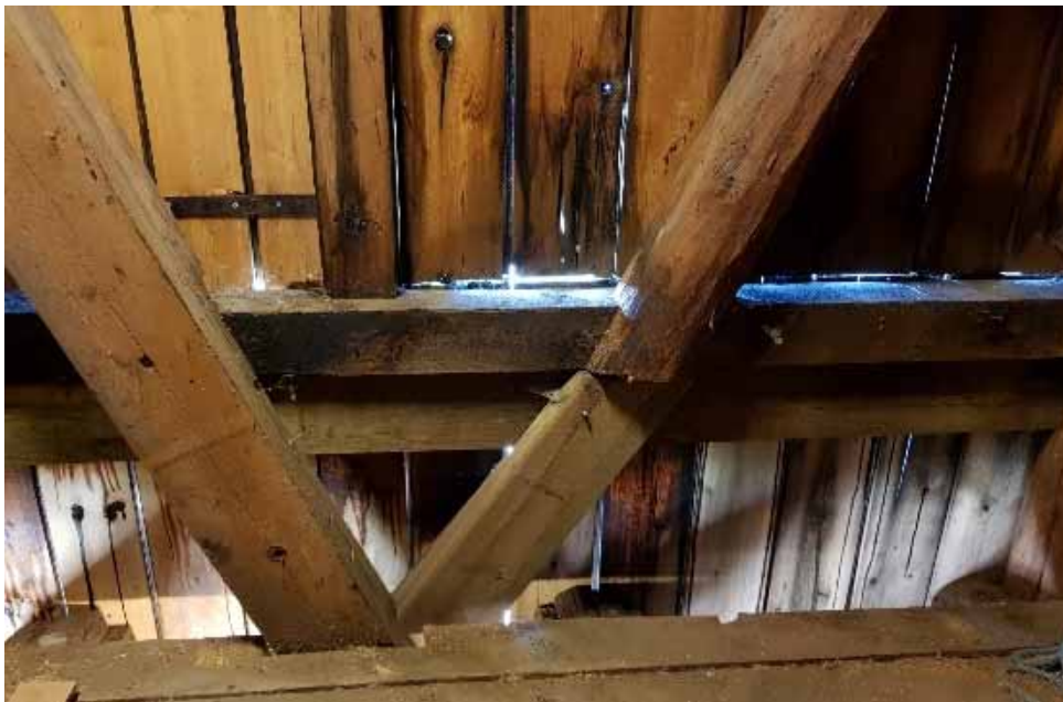
Figur 19. Södra sidans panel sedd från insidan. Problem med generalskarv på panel. Tidigare utförda åtgärder på konstruktionen med utbytt virke.
