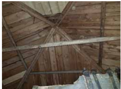
Figur 57. Bevarat undertak på östra takfallet. Enstaka ny undertaksbräda.
