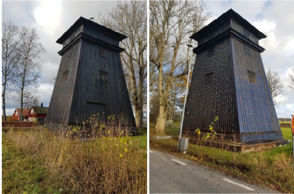
Figur 76. Östra och norra sidan efter åtgärder.
