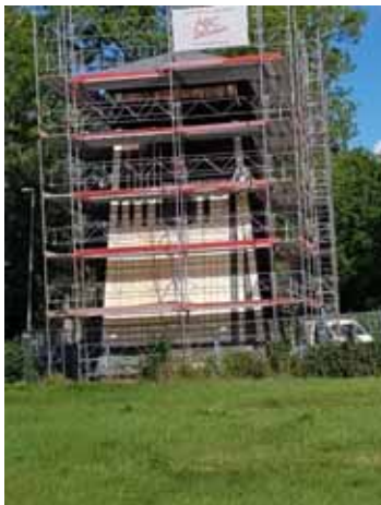
Figur 74. Utbytt panel södra fasaden.
