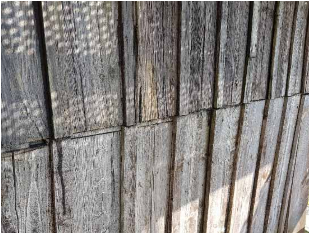
Figur 32. Södra fasadens generalskarv. Panelen över generalskarv ligger djupare in än den undre panelen. Glipan i skarven är "tätad" med små träklossar till vänster samt syntetisk mjukfog till höger.
