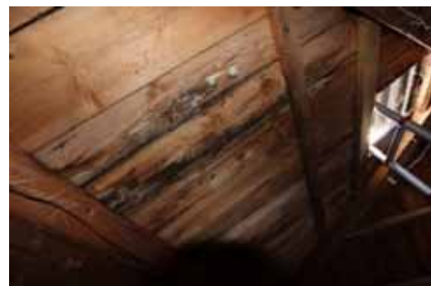
Figur 7. Omfattande rostangrepp och korrosion har lett till takläckage med skador i underliggande takpanel.
