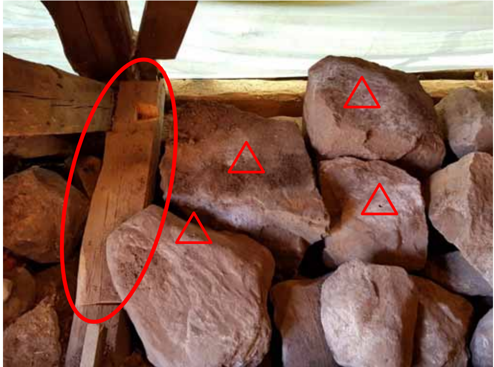
Figur 68. En av timmerlagningarna på klockstapelns södra sida inringad. Exempel på hål där man lyft upp stenarna är markerade med trianglar.
