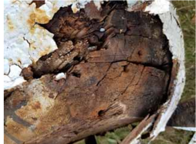
Figur 43. Ett järnsjutt går igenom konstruktionen och håller samman de olika delarna. Figur 44. Stommen av korslagda bräder uppvisar rötskador.
