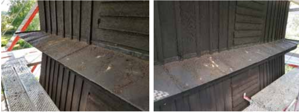
Figur 61. Gesimsen avtäckt med äldre plåt som senare tjärbehandlats lika befintligt utförande.
