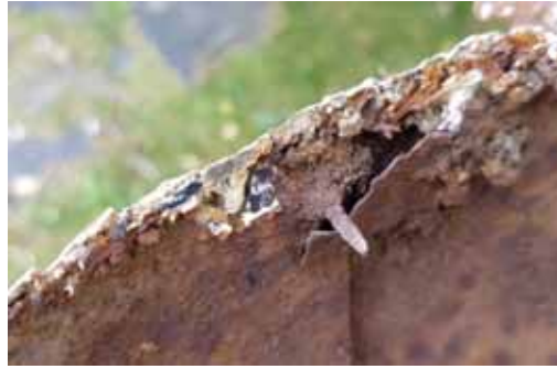
Figur 49. Lossnade plåtar sedda från baksidan. Plåtarna har legat omlott och varit fästa vid underlaget med spik.
