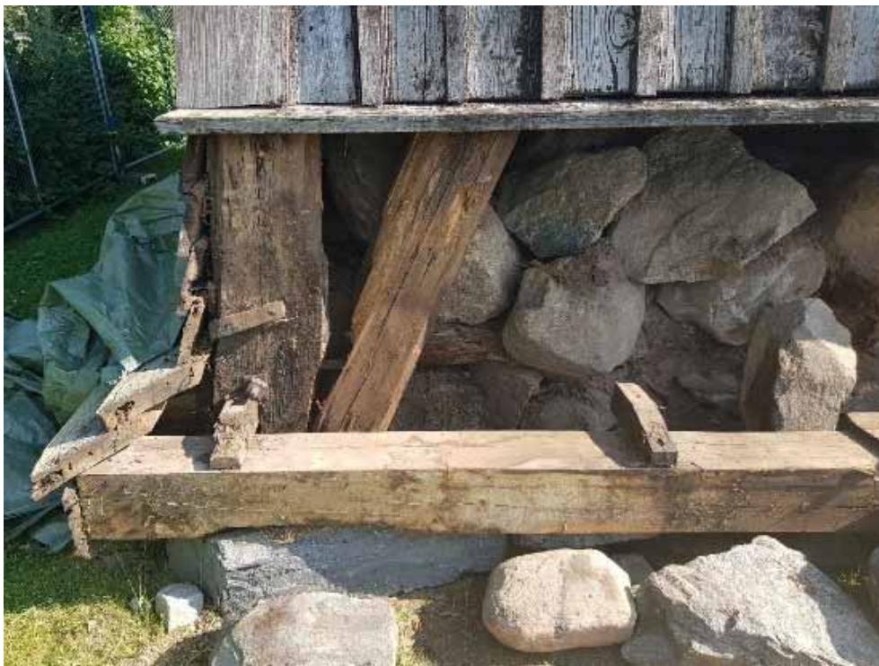
Figur 27. Sydvästra hörnet sett från söder.
