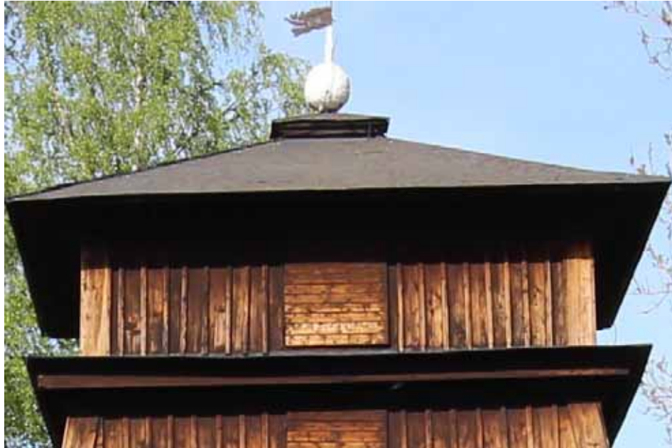
Figur 6. Pyramidtak samt undre plättäckt gesims före åtgärder.
