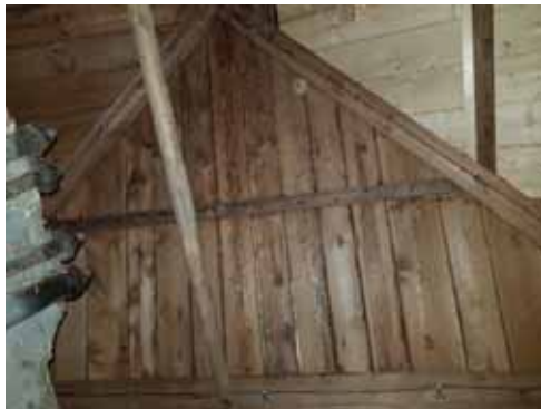
Figur 59. Västra takfallet bevarat undertak.
