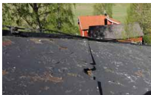
Figur 7. Omfattande rostangrepp och korrosion har lett till takläckage med skador i underliggande takpanel.
