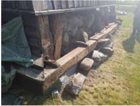
Figur 30. Södra fasaden sedd mot öster.
