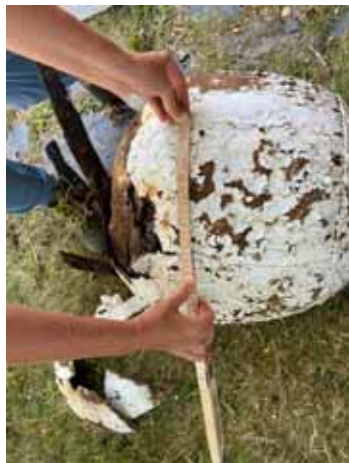
Figur 47. Plåtarna på mitten är cirka 20 cm breda. Övre och nedre varvet är något mindre. Figur 48. Korslagt smide för infästning i takkonstruktionen med fyrkantiga hål för smidd spik.
