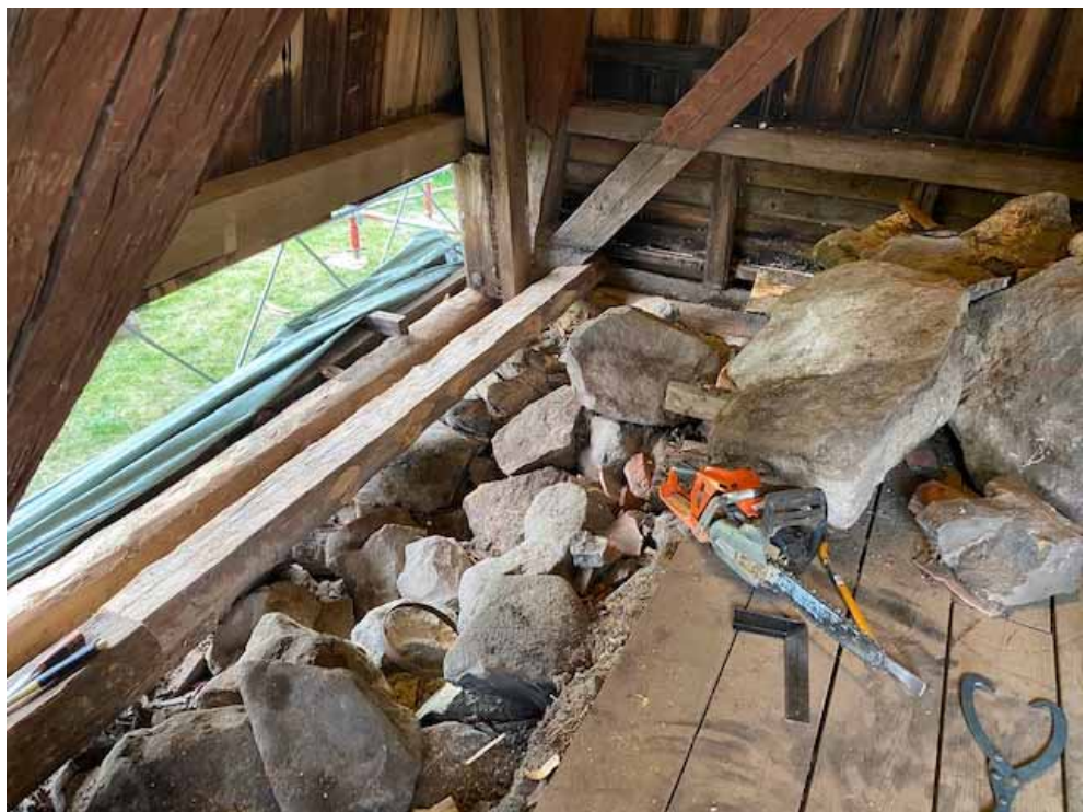
Figur 65. Utbytta syllar på södra sidan, sett mot sydväst. Foto: Lars Pernhall.
