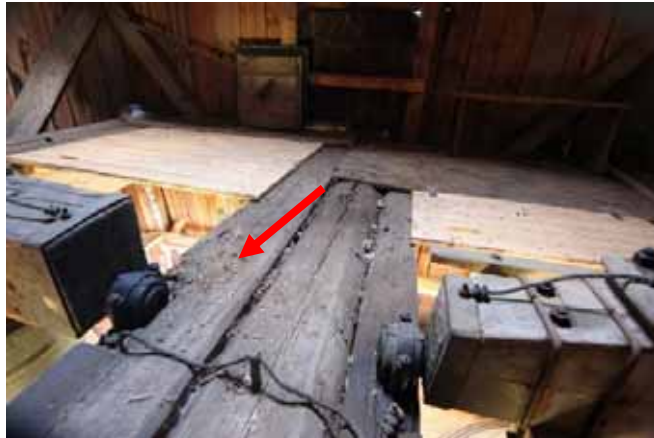
Figur 17. Syllstock i söder är kraftigt fuktskadad och uttjänt. På bilden syns hur hela knivbladet går in i virket.
