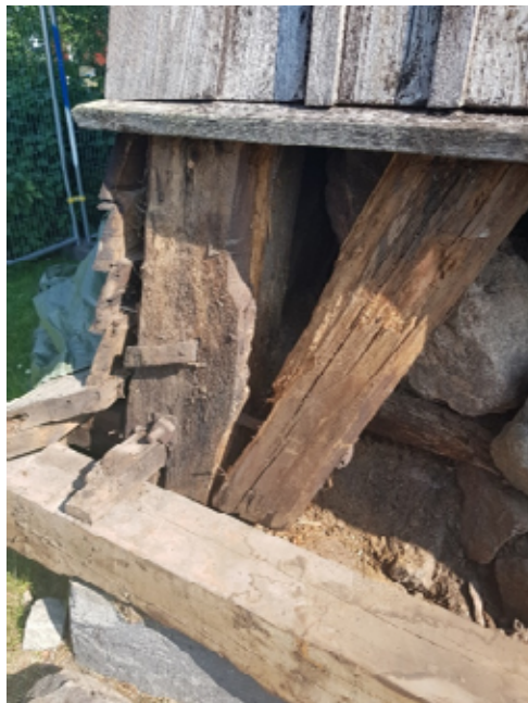
Figur 24. Sydvästra hörnet. Rötskadat timmer i stommen. Den högra snedsträvan är helt rötskadad och sedan tidigare avsågad och utbytt invändigt.
