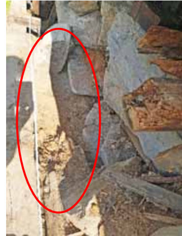
Figur 22. Yttre syllen är i det närmaste helt borta på södra fasadens västra del. Östra delen är bättre och skarvas med en blixtskarv. Inre syllvarvet anas inne i stenpackningen markerad med den blå ringen.
