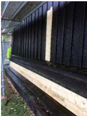
Figur 72. Utbytt panel västra sidan.
