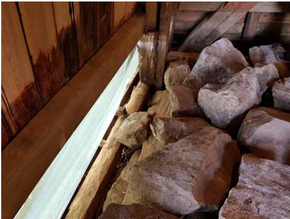
Figur 67. Utbytta syllar södra sidan, västra delen. Sten tillbakalagd. Foto: Lars Pernhall.
