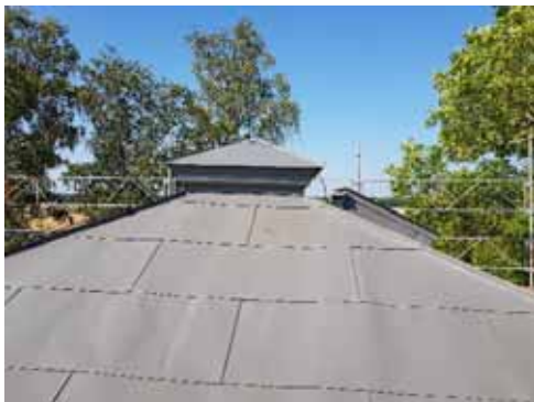
Figur 53. Östra takfallet efter omläggning.
