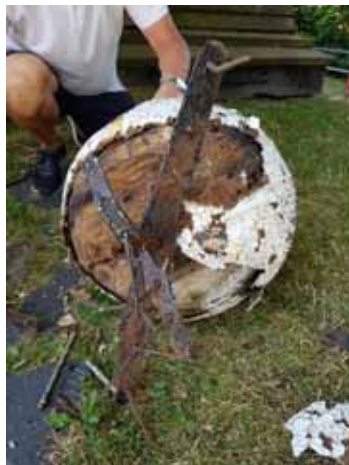
Figur 45. Korslagt smide som har fäst konstruktionen genom takplåten med spikar. Figur 46. Detalj av den svarvade toppens dekor.
