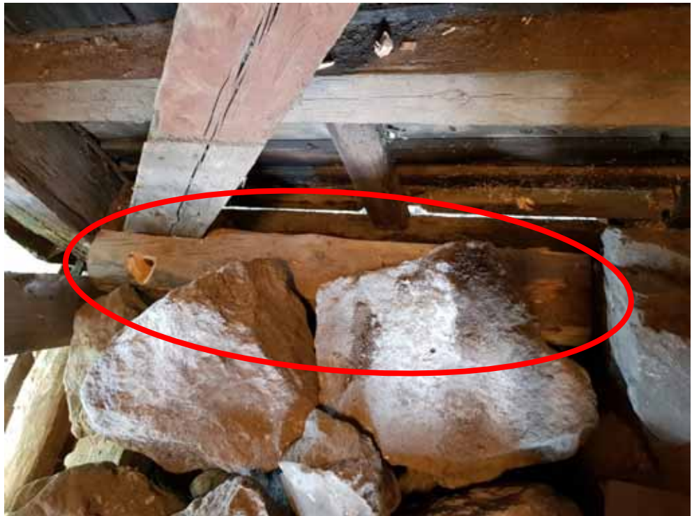
Figur 69. Timmerlagning västra sidan. Observera att man kopierat de spår som funnits i det äldre virket som bytts ut.
