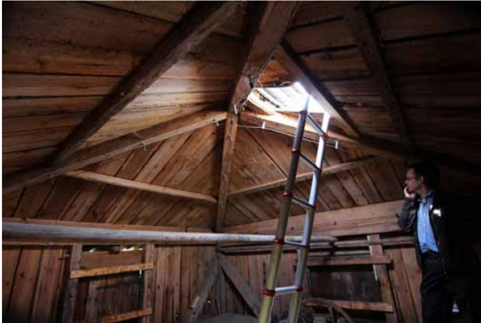
Figur 9. Undertaket före åtgärder.
