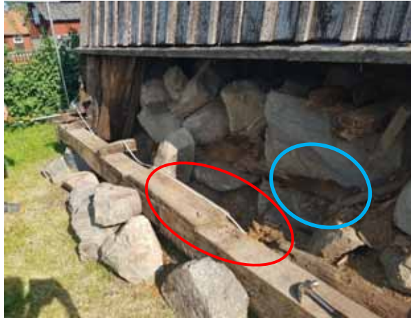
Figur 22. Yttre syllen är i det närmaste helt borta på södra fasadens västra del. Östra delen är bättre och skarvas med en blixtskarv. Inre syllvarvet anas inne i stenpackningen markerad med den blå ringen.
