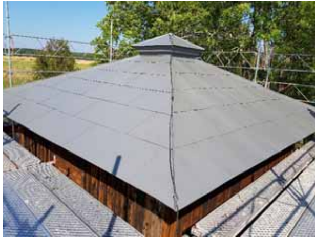
Figur 55. Taket sett från sydöst efter omläggning.
