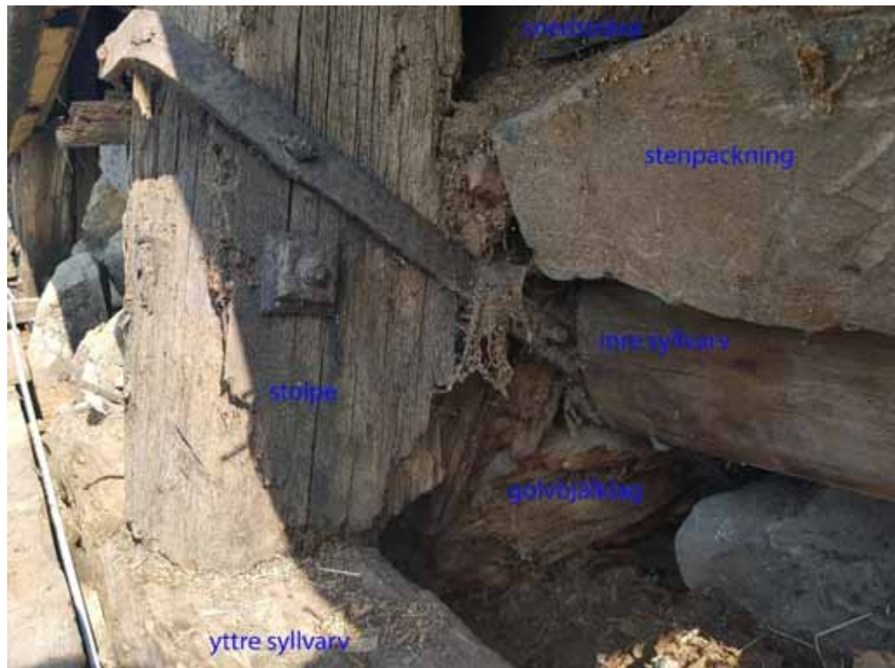
Figur 28. Knutpunkt på strax öster om mitten av södra fasaden. Skarv mellan stående stolpe, syll och golvbjälklag. Sammanbunden med järn.
