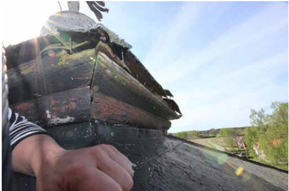
Figur 16. Profilerat listverk. Man anar en möjlig äldre rödbrun färgsättning. Svårt dock att se om det kan vara det underliggande träets naturliga färg.
