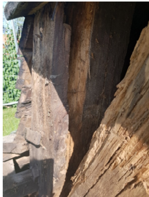
Figur 24. Sydvästra hörnet. Rötskadat timmer i stommen. Den högra snedsträvan är helt rötskadad och sedan tidigare avsågad och utbytt invändigt.
