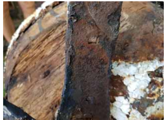
Figur 47. Plåtarna på mitten är cirka 20 cm breda. Övre och nedre varvet är något mindre. Figur 48. Korslagt smide för infästning i takkonstruktionen med fyrkantiga hål för smidd spik.
