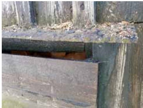
Figur 37. Droppbleck över lucka, äldre järnplåt. Norra sidan
