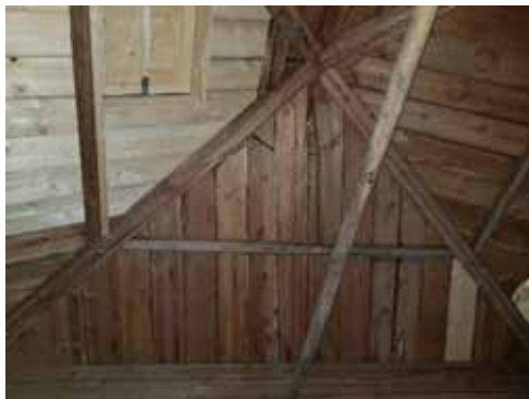
Figur 57. Bevarat undertak på östra takfallet. Enstaka ny undertaksbräda.
