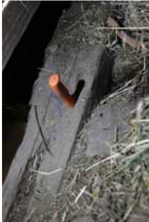
Figur 17. Syllstock i söder är kraftigt fuktskadad och uttjänt. På bilden syns hur hela knivbladet går in i virket.
