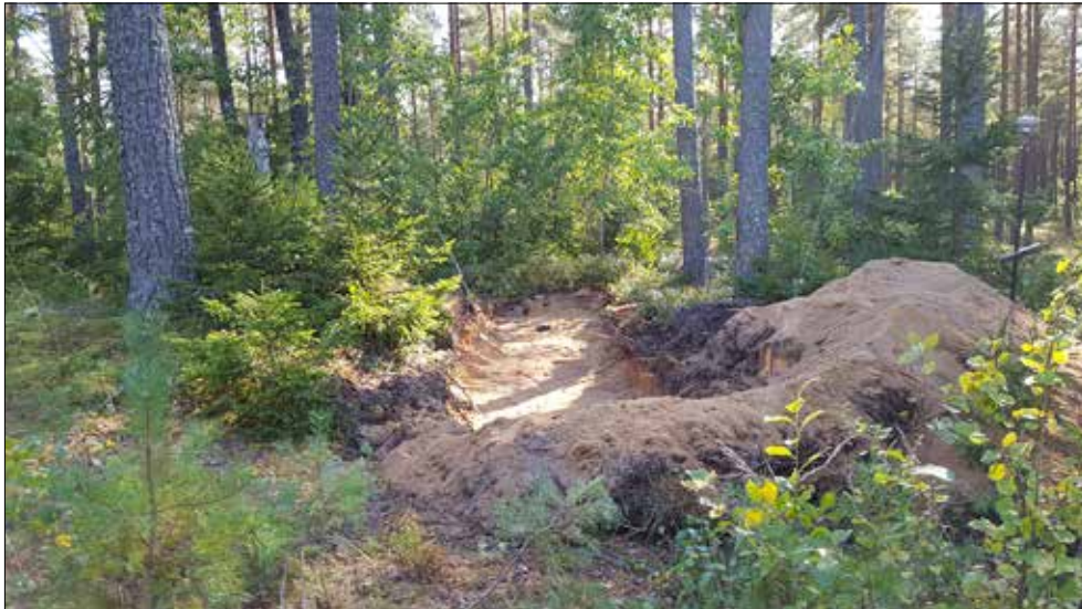
Figur 11. Schakt 327. Foto från norr.
