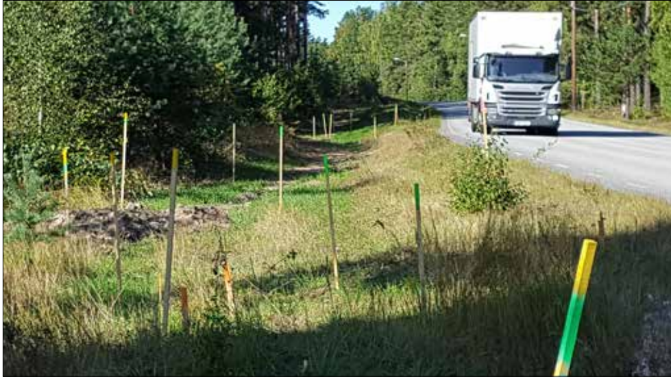
Figur 10. Ett flertal ledningar är nedgrävda längs väg 900.
