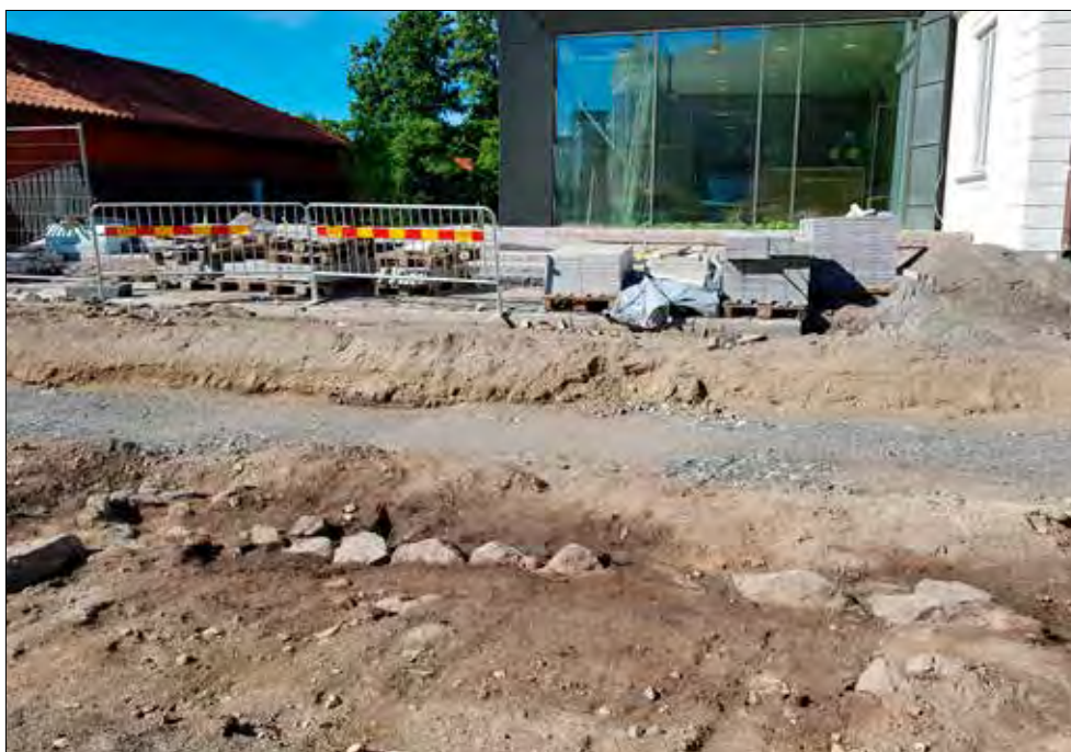
Figur 80. Syllstensraden A53 och A58 framkom åtta meter öster om den nuvarande tomtrönsen i kvarteret Hagbard. Glashuset i bakgrunden är nya Stiftskansliet som är beläget i kvarteret Hagbard där medeltida stenhus tidigare har undersökts (figur 111, Ros 2019). Fotograferat av Jonas Ros från nordöst.
