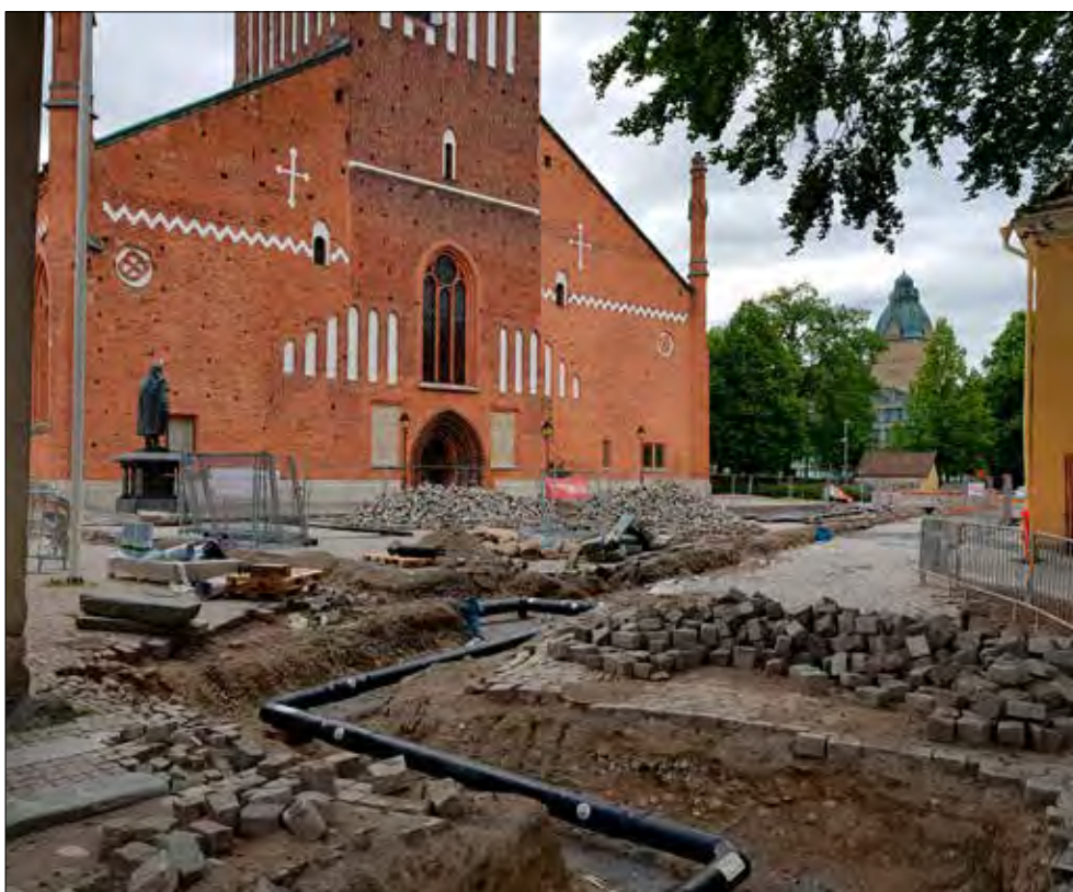
Figur 48. Översikt som visar delar av schakt 1a, i förgrunden ses delar av schakt 3 och till väster delar av schakt 2. En fjärrvärmeledning är nedlagd och storgatstenarna ligger i bögar. Fotograferat från nordväst av Jonas Ros.
