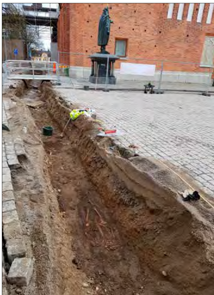
Figur 45. Översikt över schakt 2 med skelett A7. Fotograferat från väster av Jonas Ros.
