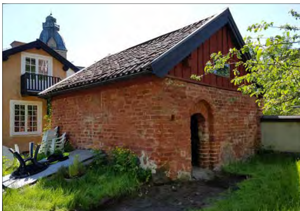
Figur 44. Källarens/tegelhusets norra vägg och schakt 12. Till vänster ses trappan och där ovanför ser man att teglet har olika karakter, delar av väggen rasade sannolikt vid 1714 års brand och har därefter byggts om. Foto från nordöst.
