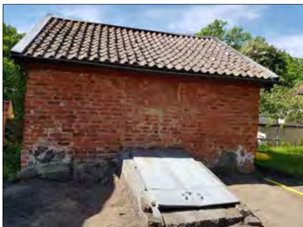
Figur 41. Delar av schakt 11 och den östra väggen i källaren/tegelhuset. Huset har en källarvåning. Delar av tegelväggen har sannolikt rasat i samband med branden 1714 och därefter har den reparerats i omgångar. Foto från öster.
