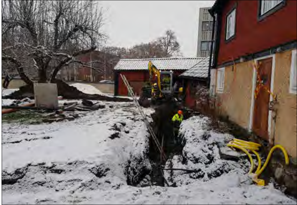
Figur 22. Schakt 5:s östra del. Foto från väster.
