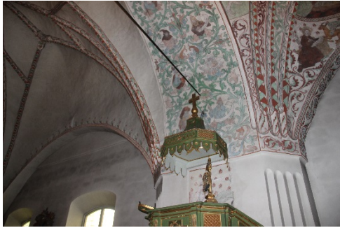
Figur 10. Dragstaget före montering av spotlights.
