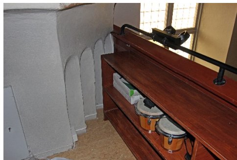
Figur 16. Spotlights monterade på läktarbarriärens metallrücke, södra sidan.
