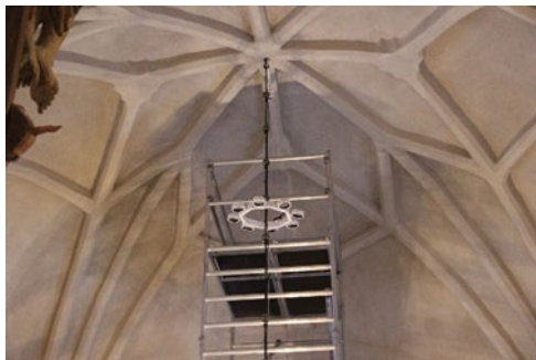
Figur 27. Montering av Ljuskrans i pendel i långhuset.
