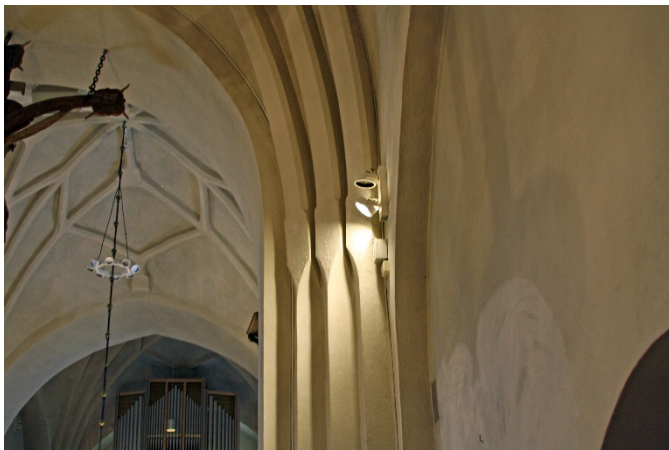
Figur 35. Spotlights placerade på pelare i koret.
