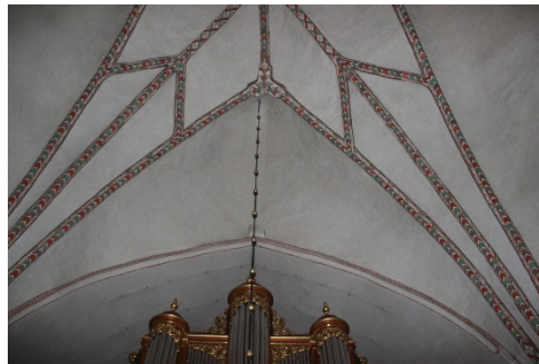
Figur 6. Pendeln i västra delen av långhuset före åtgärder. Hålet måste förstöras för att kunna dra ny kabel.
