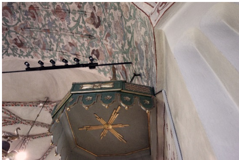
Figur 12. Nya spotlights monterade i dragstaget.
