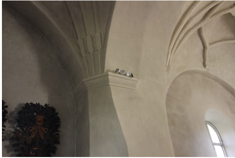
Figur 31. Placering av spotlight på pelare.
