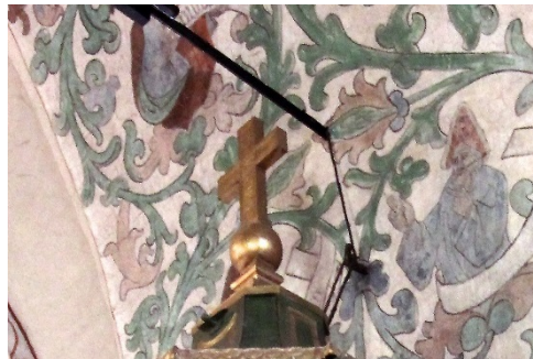
Figur 13. Kabeldragningen från dragstaget har gjorts via predikstolens ljudtak.
