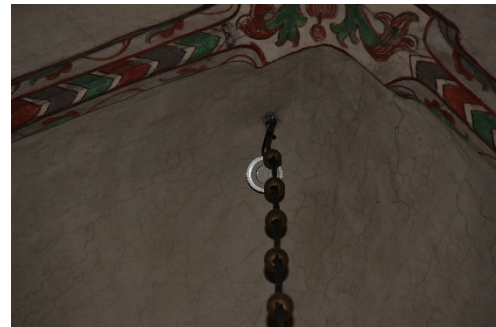
Figur 6. Pendeln i västra delen av långhuset före åtgärder. Hålet måste förstöras för att kunna dra ny kabel.
