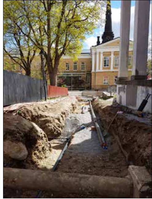
Figur 27. Rudbeckianska skolans gamla huvudbyggnad sedd från Blåsbogatan med Domkyrkans spira i bakgrunden. Kolonnerna till höger i bild är från Gamla gymnastikbyggnaden. Fotograferat av Oskar Spjuth från norr.
