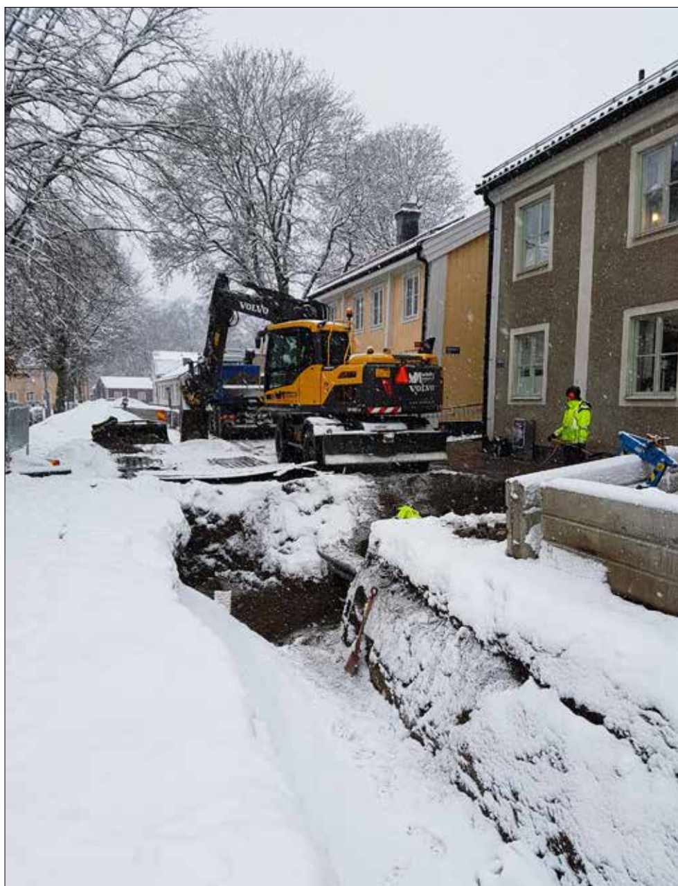
Figur 5. Schaktning i Skolgatan för ny VA (schakt 1). Fotografiet taget från öster av Jonas Ros.
