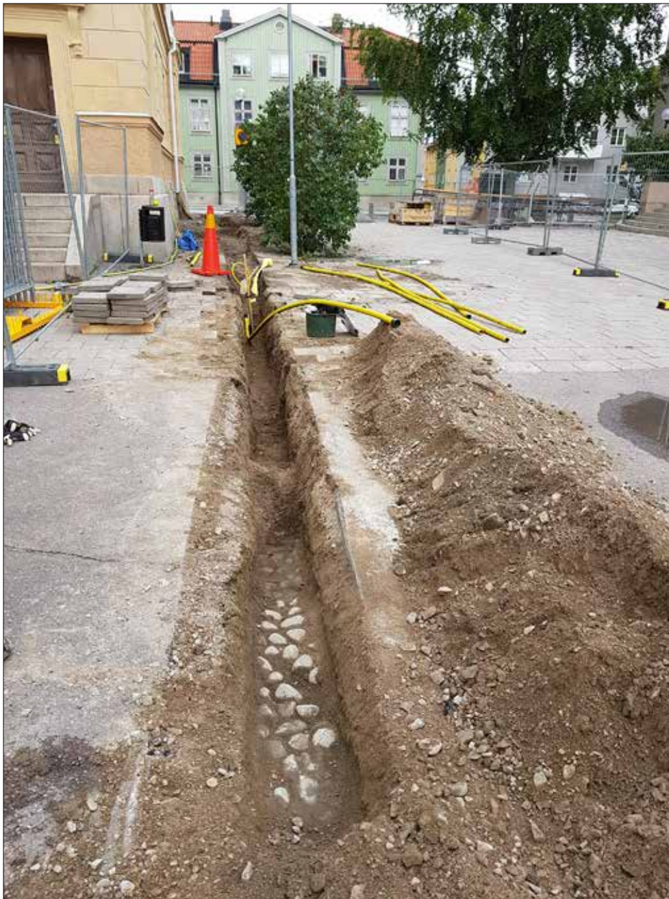
Figur 102. Norra delen av delområde F sett från söder. I schaktet syns stenlagd yta A234 och bortanför schaktet vid Skolgatan. Fotograferat av Jonas Ros.
