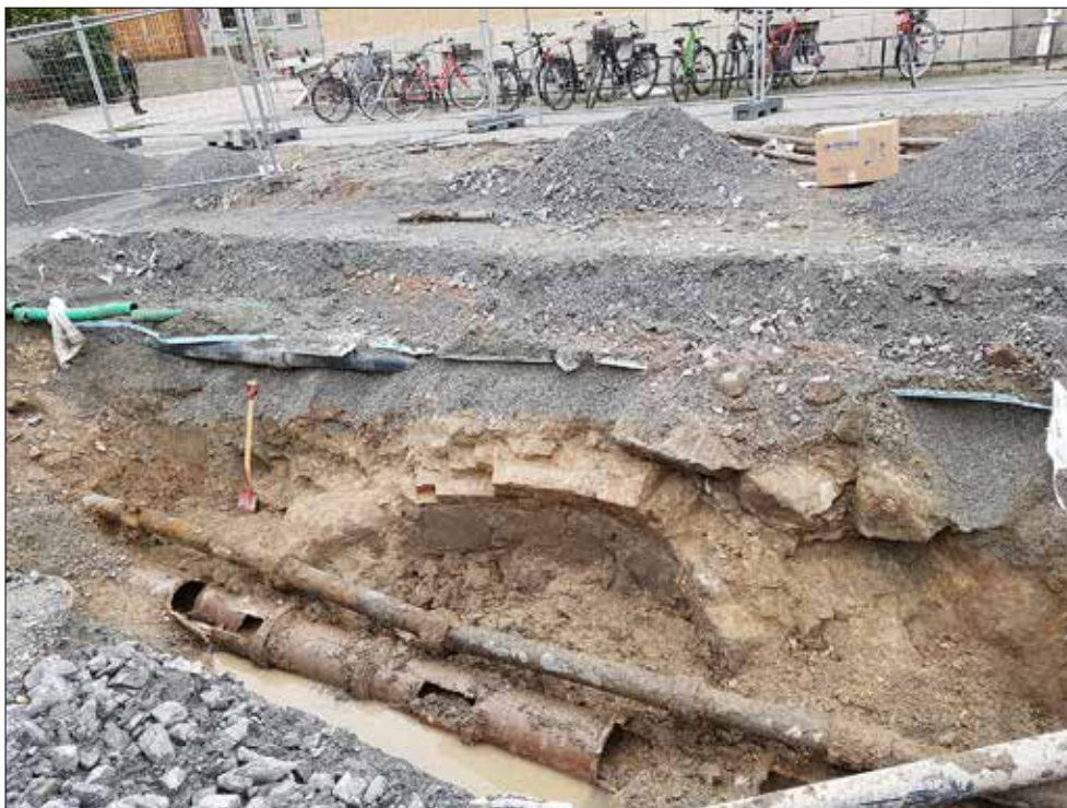
Figur 80. Källarmur A217 sedd från nordväst. Muren har utgjort den södra källarväggen i hus 7. Muren framkom vid reparation av en VA-ledning som gått genom källaren. Foto: Jonas Ros.
