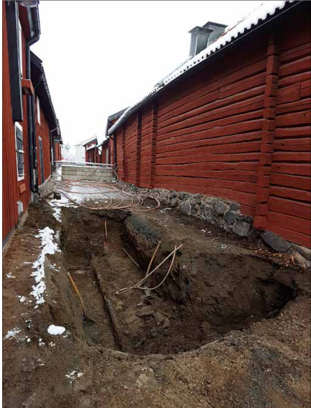
Figur 61. Norra delen av schakt 1 och 2 i Rektorsgatan. Sektion 136 uppfördes där den utfällda tumstocken ligger centralt i bild mellan en kabelskyffel och en spade. Träbussen på båda sidor är typiska för gränderna norr om Skolgatan. Fotograferat av Jonas Ros från söder.
