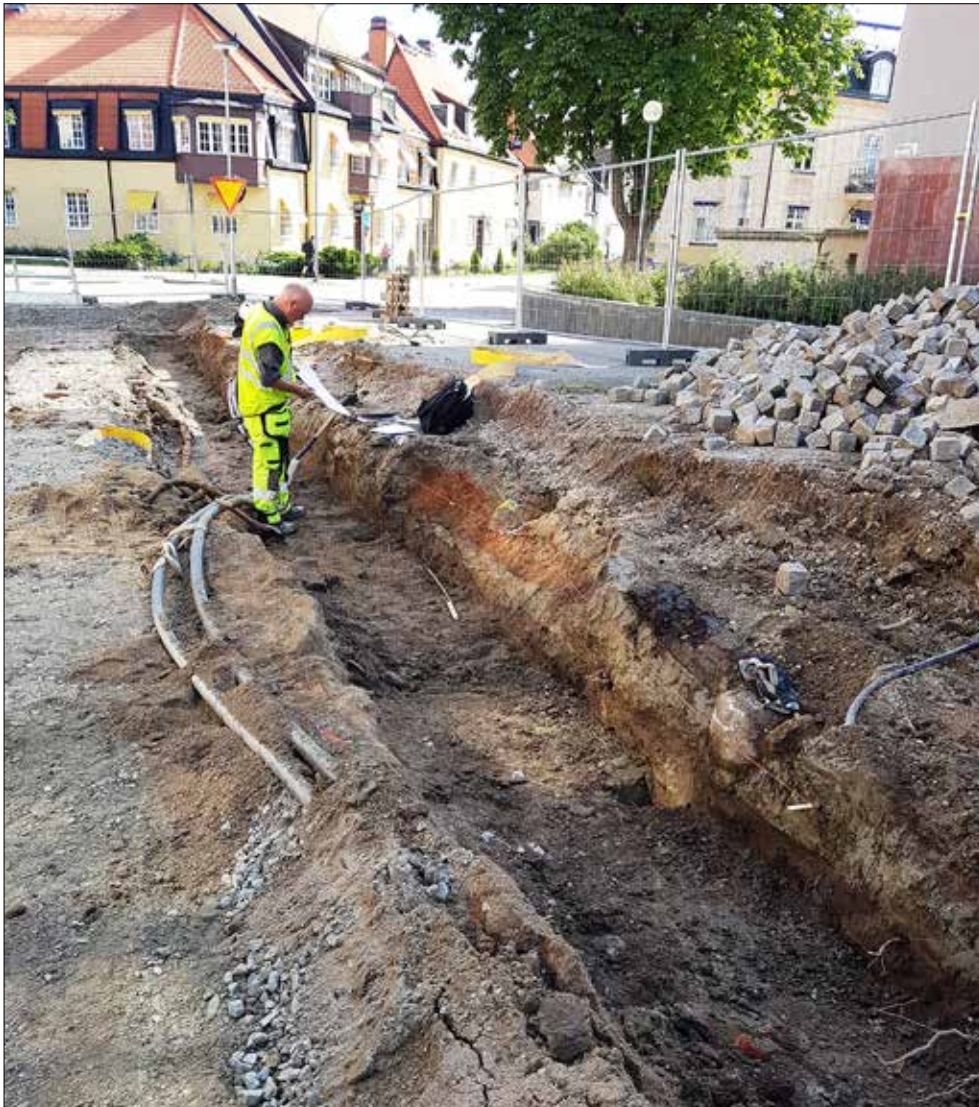
Figur 83 Jonas Ros dokumenterar de medeltida bebyggelselämningarna som framkom nästan direkt under asfalten i södra delen av schakt 3. Närmast i bild syns syllstenen A239 och strax vänster om den härd A239. Vy från väster. Fotograferat av Oskar Spjuth.
