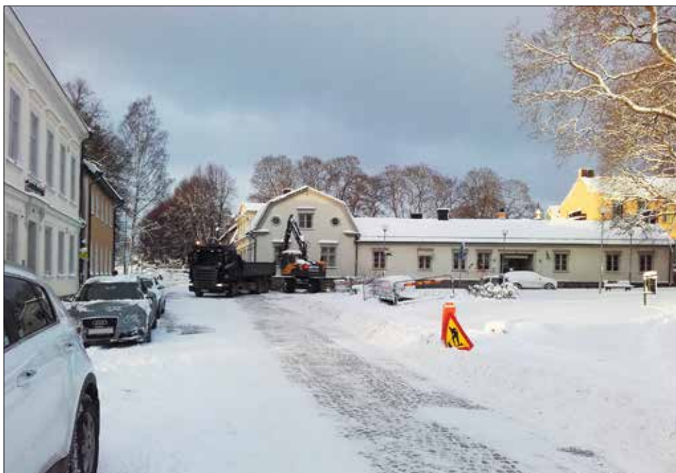
Figur 10. Vy över korsningen Skolgatan–Västra Kyrkogatan från söder. Västra Kyrkogatan är mycket gammal och under skiktet av gatsten fanns flera äldre kullerstensnivåer bevarade. Fotograferat av Oskar Spjuth.
