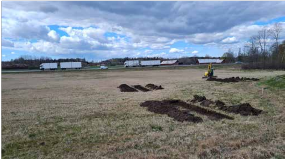
Figur 10. Sökschakt grävs inom delområde C, med riksväg 51 i fonden. Foto från öster.
