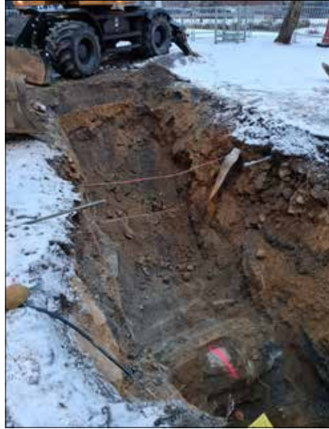
Figur 8. Schaktet från öster.
