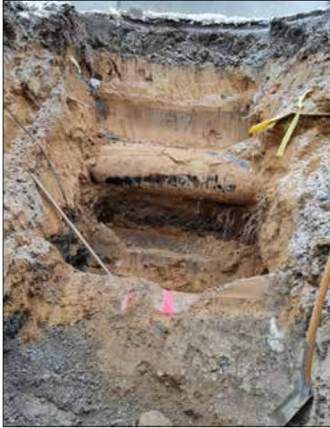
Figur 7. Nordöstra delen av schaktet från sydväst.
