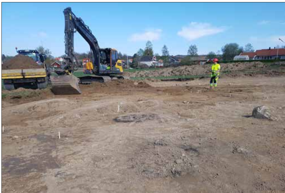
Figur 2. Ytan banas av med grävmaskin och alla anläggningar som syns mot den naturliga undergrunden markeras med små tröpinnar. Foto från sydväst.
