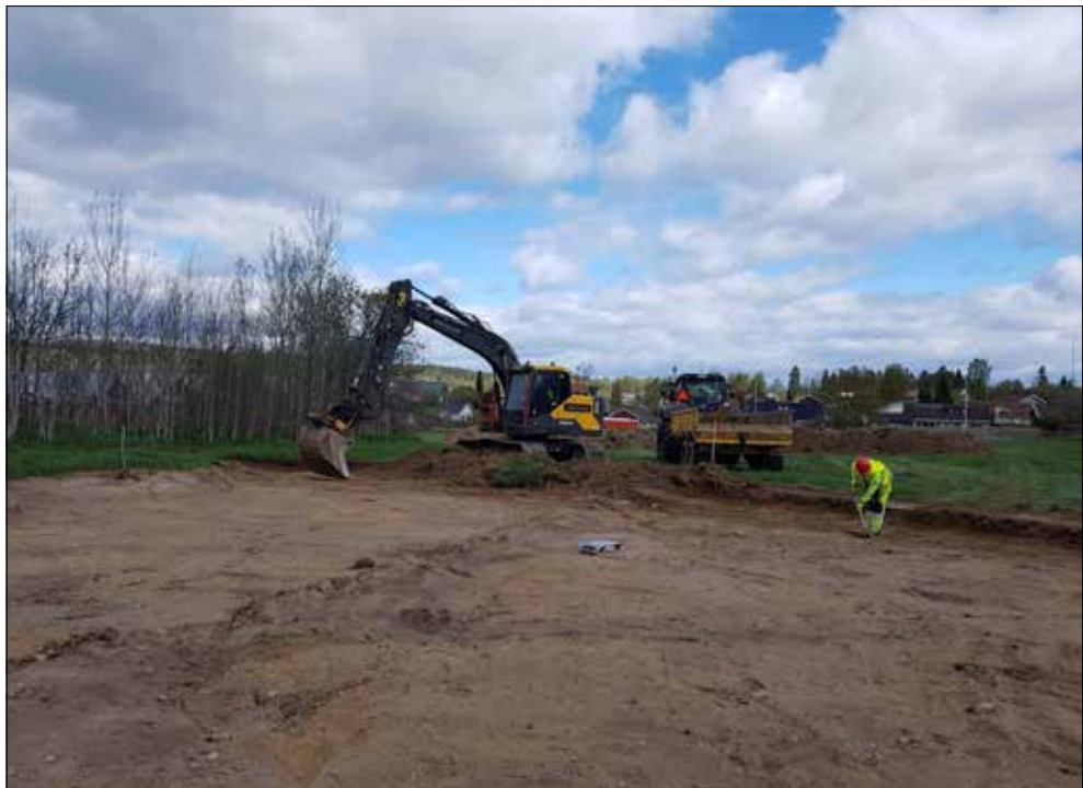
Figur 9. Schaktning pågår i östra delen av undersökningsområdet. Foto från söder.
