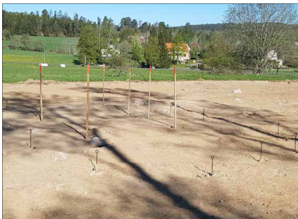
Figur 18. Hus 1 från sydöst. De höga träpinnarna markerar takbärande stolpar, de mindre öglorna väggstolpar.
