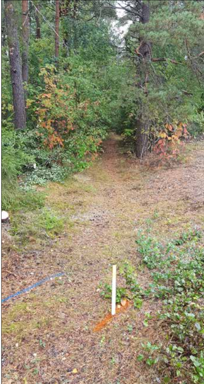
Figur 12. Vy av L1944:1170 (färdväg) mot nordväst. Blå markering för nytt schakt och orange för befintlig kabel.
