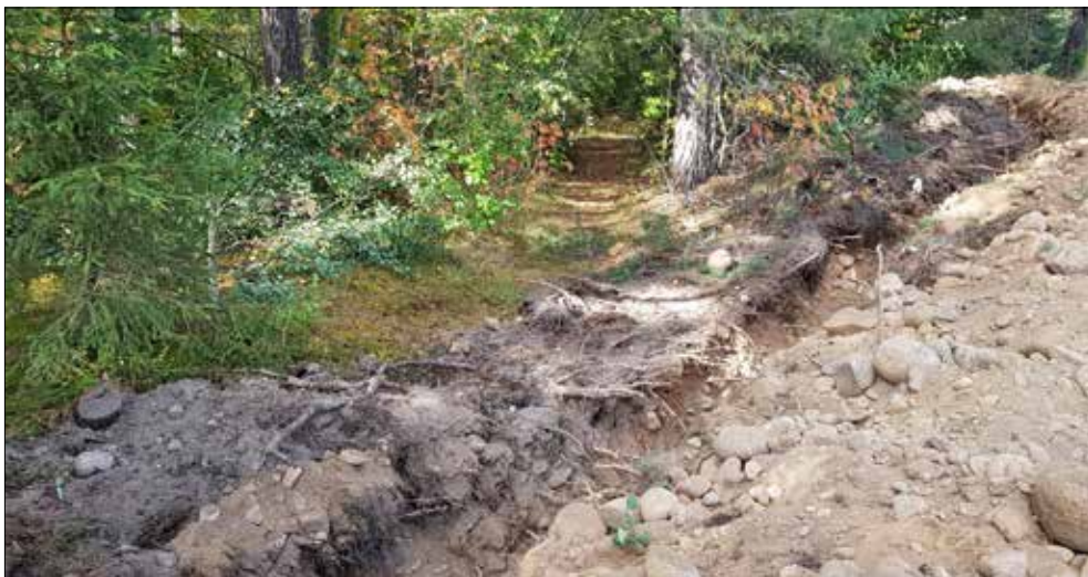
Figur 13. Schakt OS226 där den korsar L1944:1170 (färdväg).
