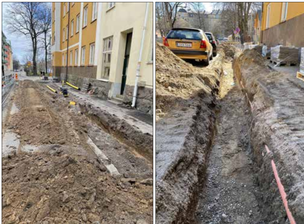
Figur 2. Schakten i Nygatan samt Butgatan, vyer från väster respektive norr.
