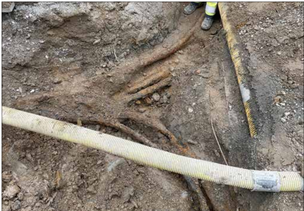
Figur 9. I schakt 2 påträffades endast ledningar. Foto från söder.
