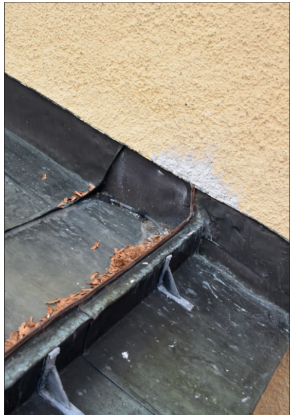
Figur 21. Slutbesiktning den 21 oktober 2021. Putsen har blivit lite skadad i samband med åtgärder.
