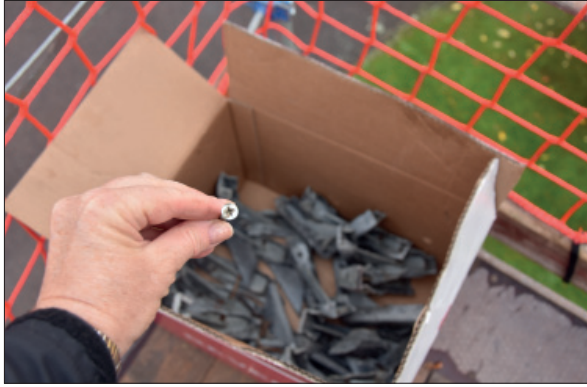
Figur 10. Ståndrännan på den norra sidan stöddes av konsoler. Dessa var fastskruvade med moderna skruvar.
