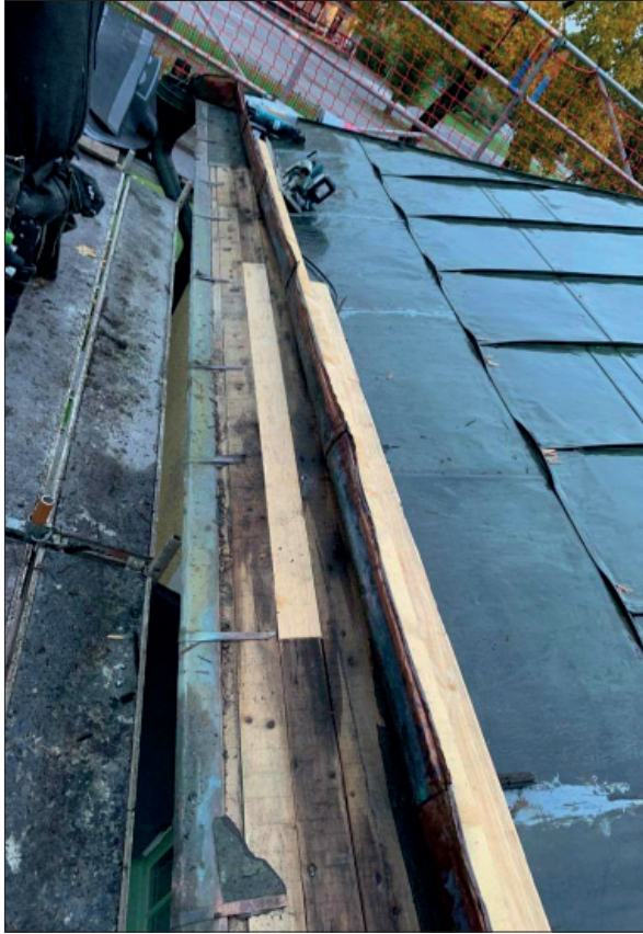
Figur 18. Rötskadade brädor byts ut. Foto Johan Andersson.
