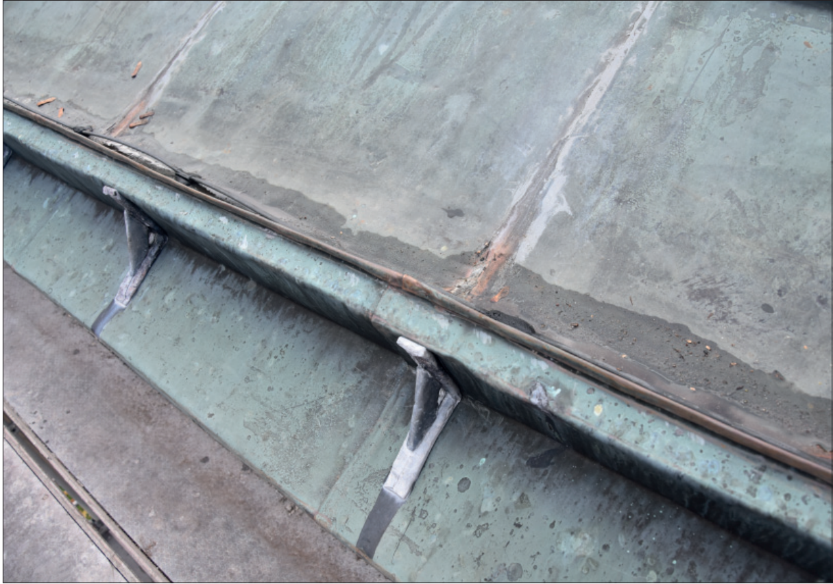
Figur 24. Detalj av lödlagning och konsoler åter på plats. En konsol har bytts ut och sex nya kopparspikar har tillkommit vid renovering.
