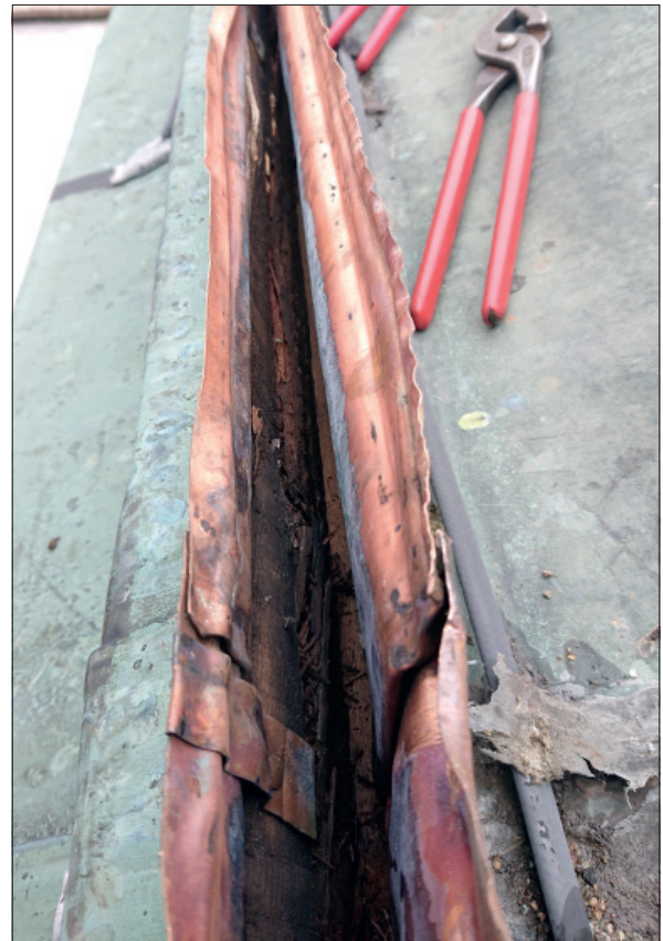
Figur 17. Arbete med upptagning pågår. Foto Johan Andersson.
