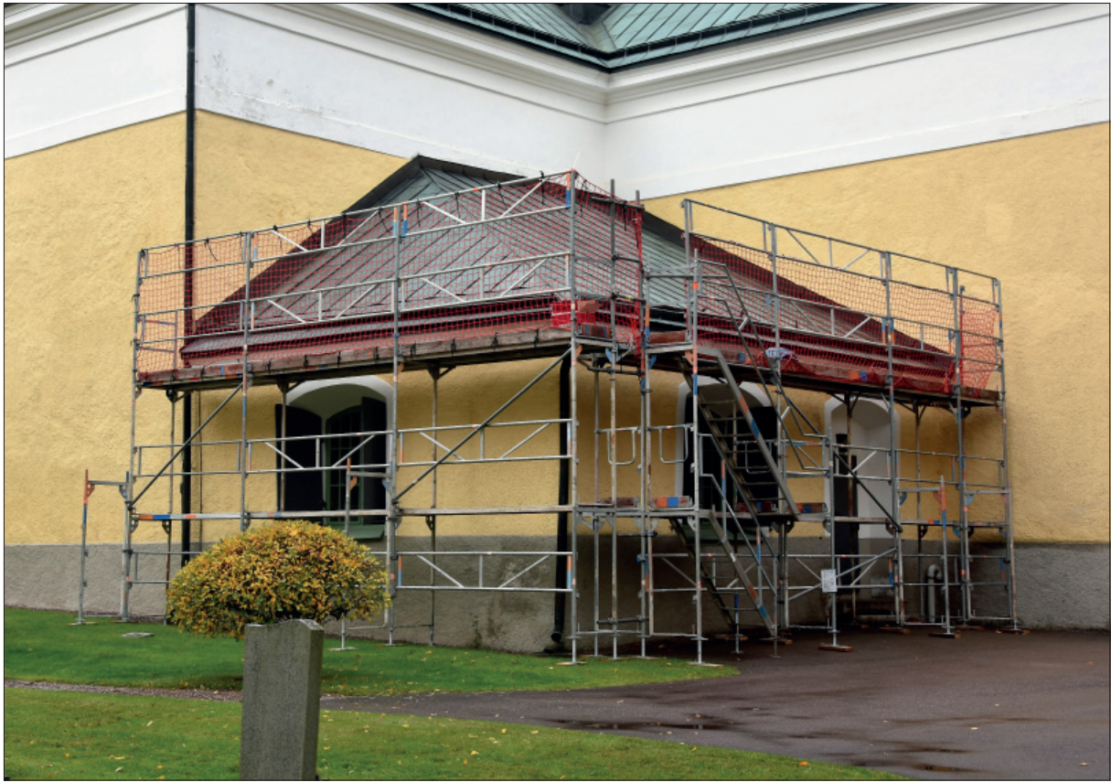
Figur 8. Byggmöte den 1 oktober 2021. Ställningen är på plats och Johan har påbörjat arbetet.
