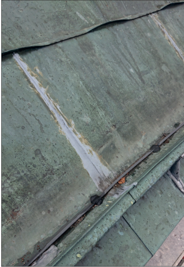
Figur 14. Tidigare lagning.
