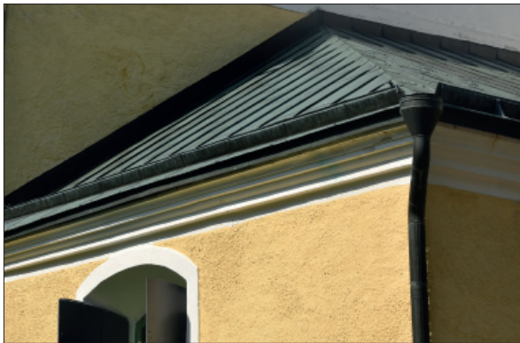
Figur 4. Takfot och fotränna, östra sidan.
