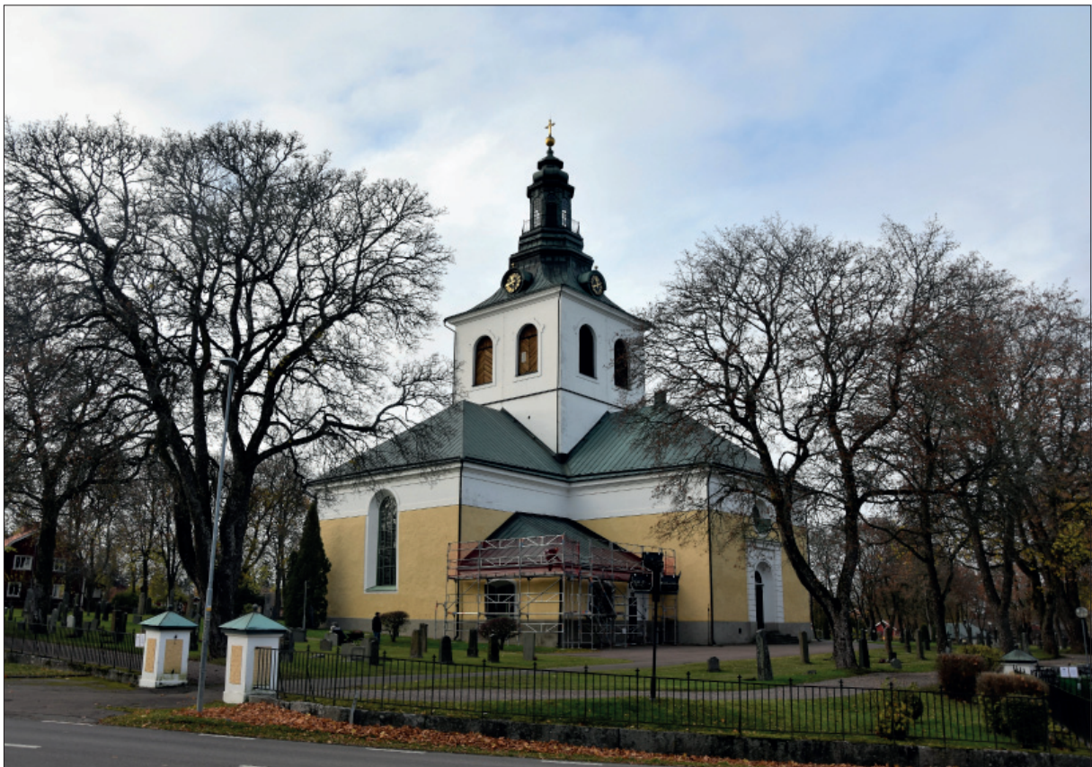
Figur 25. Slutbesiktning av sakristians tak. Byggställning fortfarande kvar.
