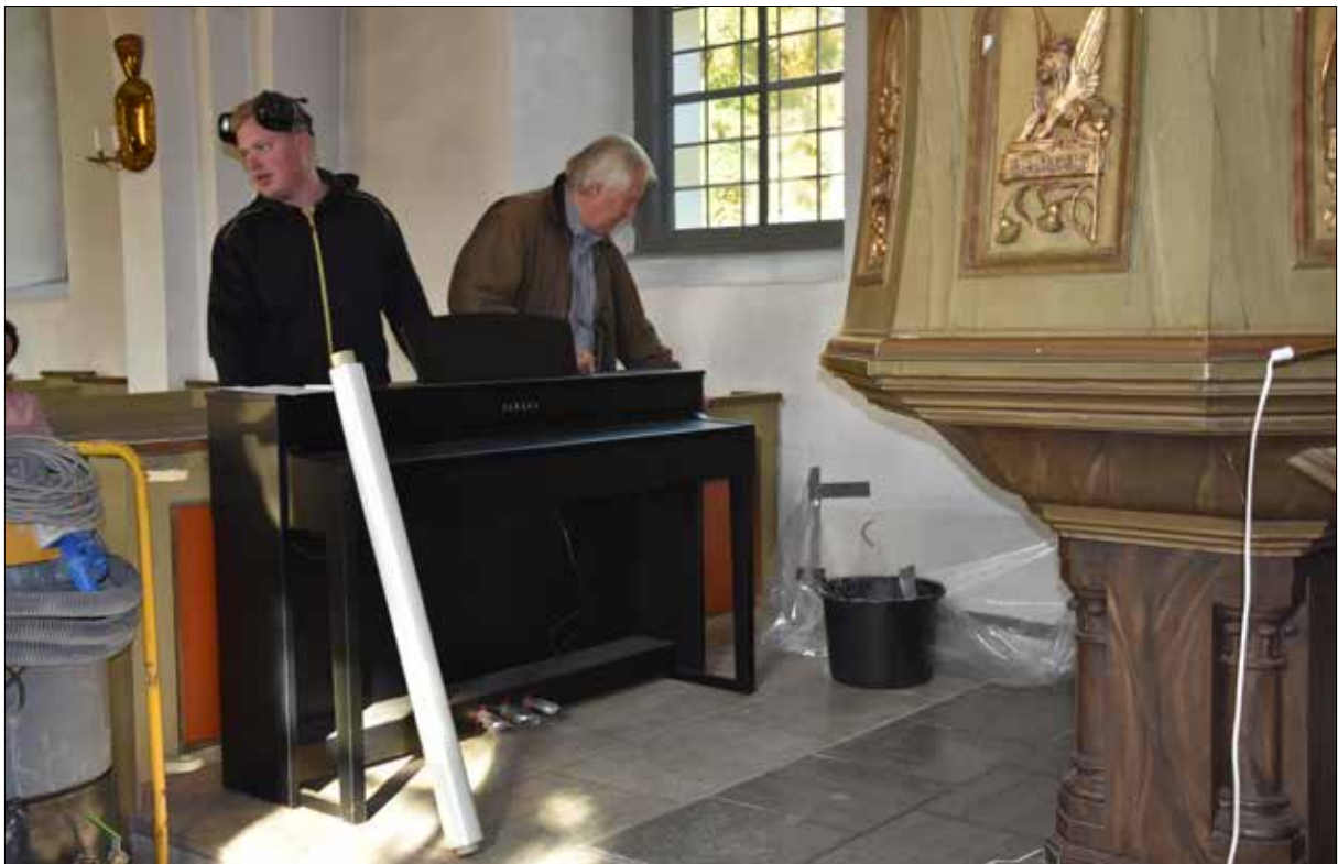
Figur 7. Henrik och Sven-Erik väntar med spänning på att borren ska ta sig igenom muren.
