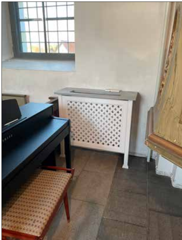
Figur 24–25. Luftvärmepumpen med placering nära predikstolen.
