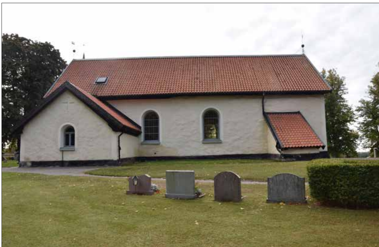
Figur 10. Håltagning klar, kyrkan sedd från norr.
