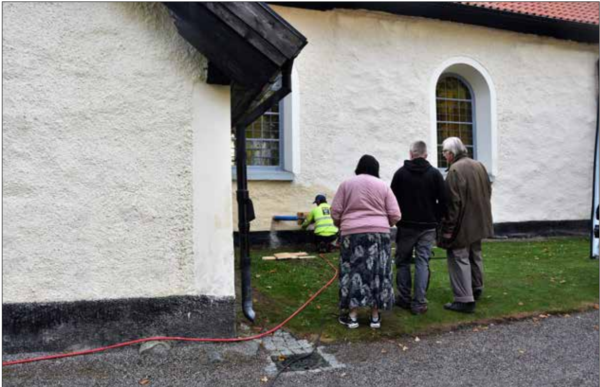
Figur 6. Borrningen har påbörjats på norra sidan.
