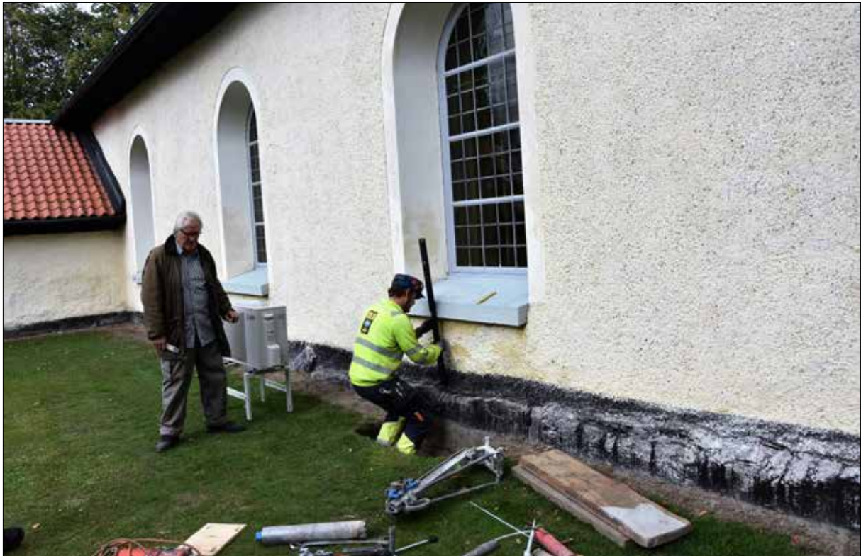
Figur 12. Förberedelse för håltagning på södra sidan.
