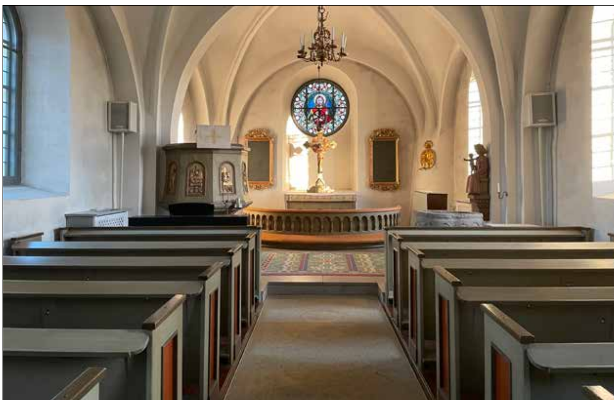
Figur 22. Utsikt mot koret, slutbesiktning november 2021. Luftvärmepumparna är på plats och inklädda med träpanel. Dessa är målade med vit och grå linoljefärg.
