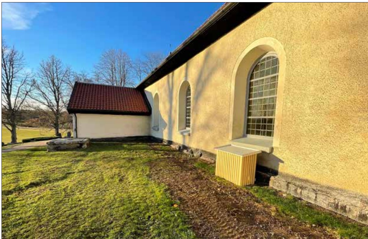
Figur 21. Södra fasaden, slutbesiktning november 2021.
