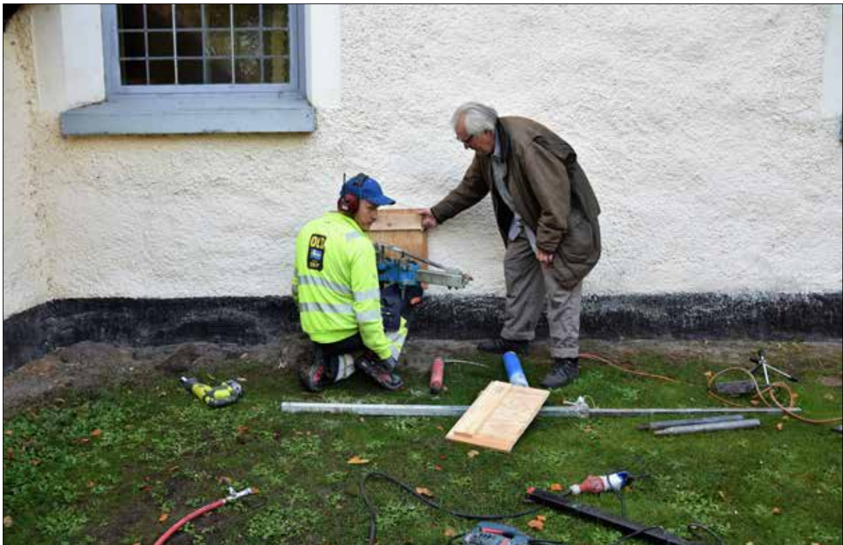
Figur 5. Arbetet är påbörjat. Sven-Erik deltar i arbetet och kollar att det blir rätt.
