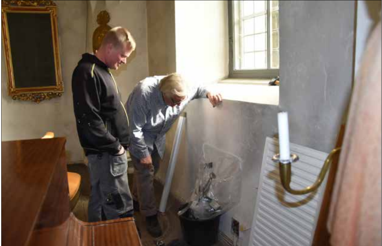
Figur 14. Henrik och Sven-Erik väntar på att borren ska ta sig igenom murverket.
