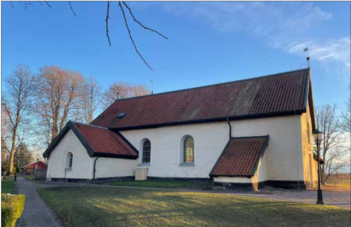
Figur 17. Norra fasaden, slutbesiktning november 2021. Inklädnad i trä med plåttak.
