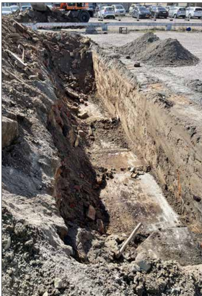
Figur 17. Betongkällaren i schakt 13. Foto från norr.
