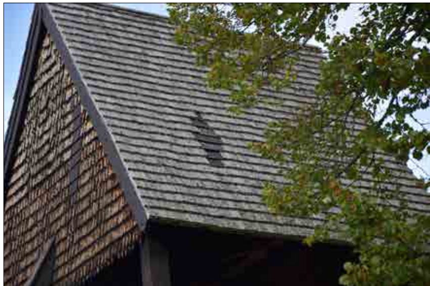
Figur 3.6. Tillfällig intäckning efter demontering av spån på fasad och taksfall. Foto Jennie Björklund.
