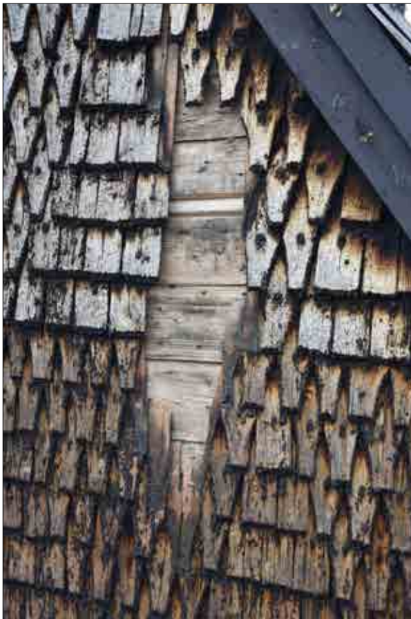
Figur 3.12. Yta där spån demonterats. Foto Jennie Björklund.
