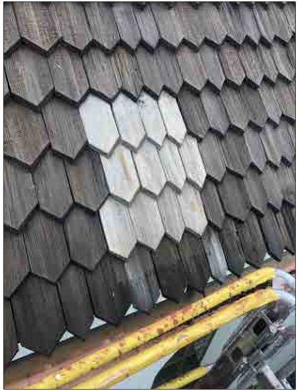
Figur 3.127. Återmonterade spån på södra långbustaket. Foto Daniel Eriksson.
