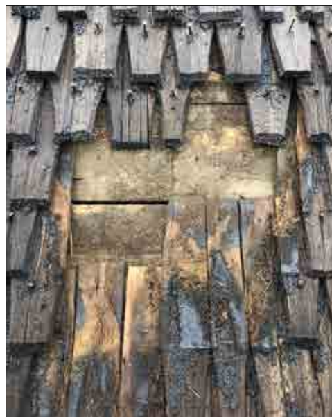
Figur 3.99. Yta med demonterade spån som visar undertaket. Foto Daniel Eriksson.
