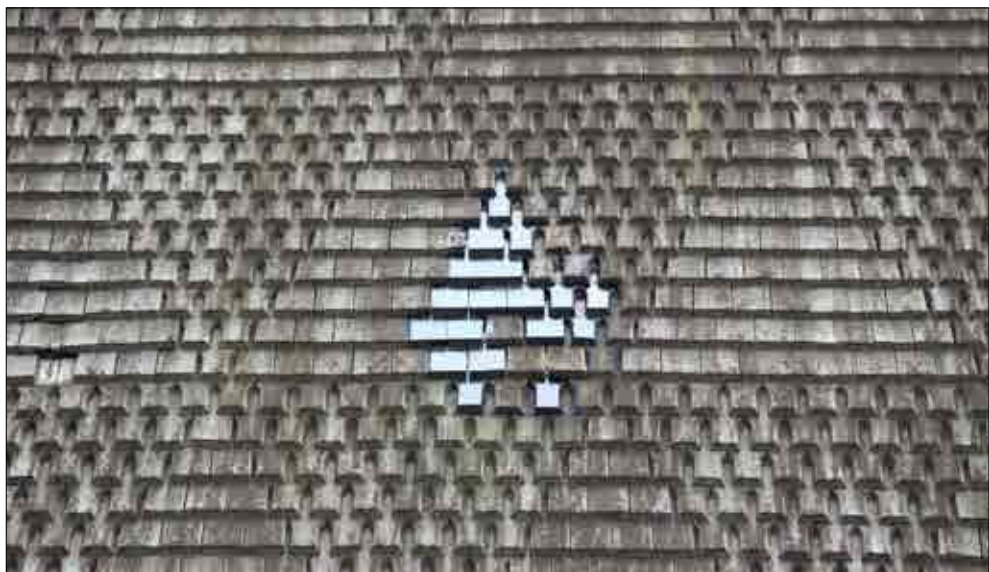
Figur 3.269. Återmonterade gamla och nya spån på norra långhustaket. Foto Lisa Skanser.
