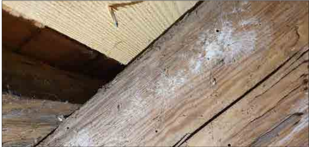
Figur 3.19. Foto taget inifrån vinden. Här upptäcktes rötskador och mögelsporer. Foto Lisa Skanser.
