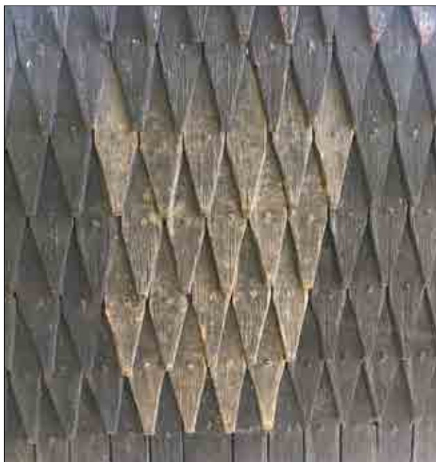
Figur 3.280. Återmonterade spån på norra gavelfasaden. Foto Lisa Skanser.
