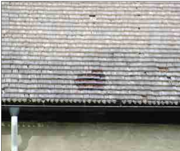
Figur 3.222. Den undersökta ytan på södra takfallet efter att nya spån monterats och tjärats. Foto Jennie Björklund.
