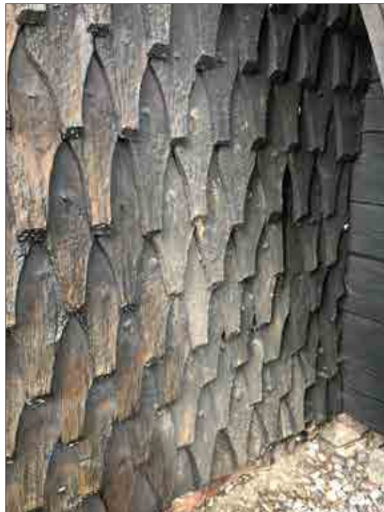
Figur 3.258. Återmonterade spån på tornets sydfasad. Foto Daniel Eriksson.
