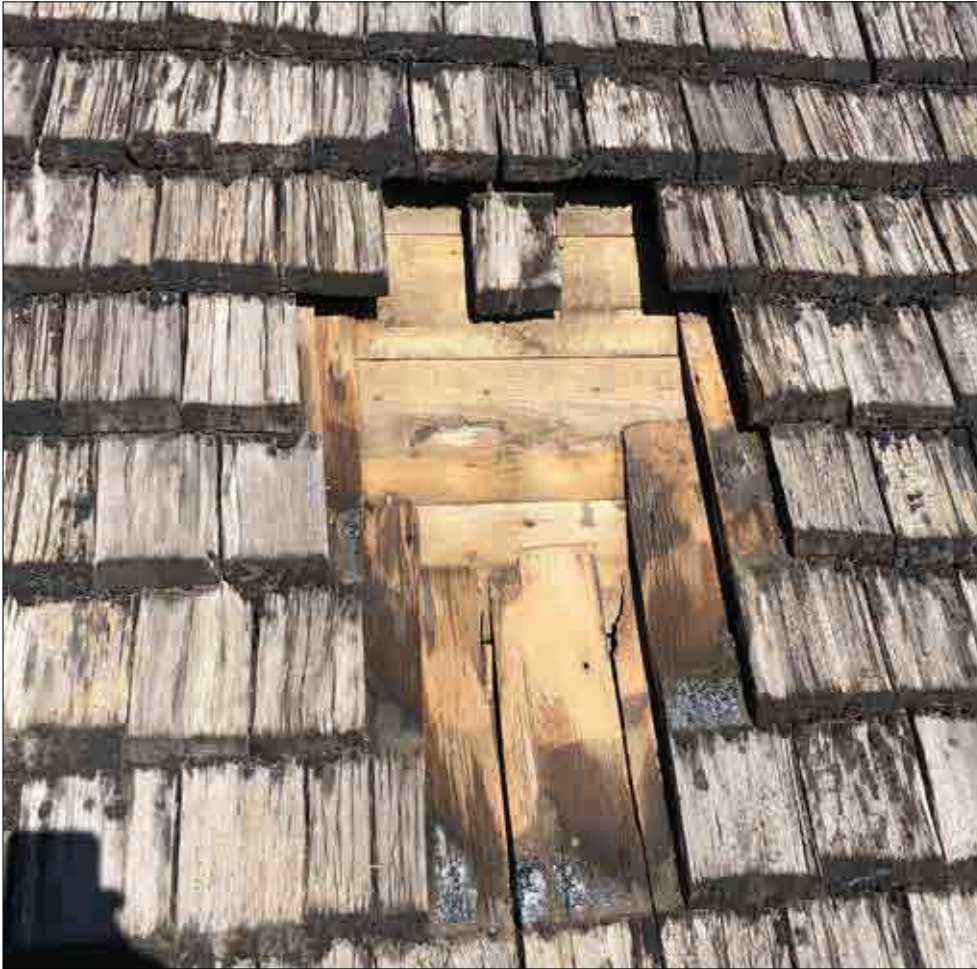
Figur 3.88. Yta på södra takfallet efter demontering av spån. Undertaket är synligt, råspont med första generationen spån. Foto Lisa Skanser.
