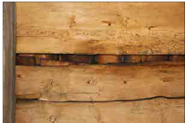
Figur 3.97. Undertak med en generation spån. Foto Lisa Skanser.
