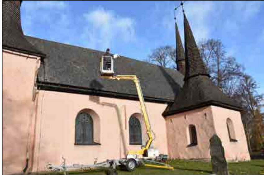
Figur 3.145. Bengt Bygdén demonterar spån med hjälp av skylift. Foto Jennie Björklund.
