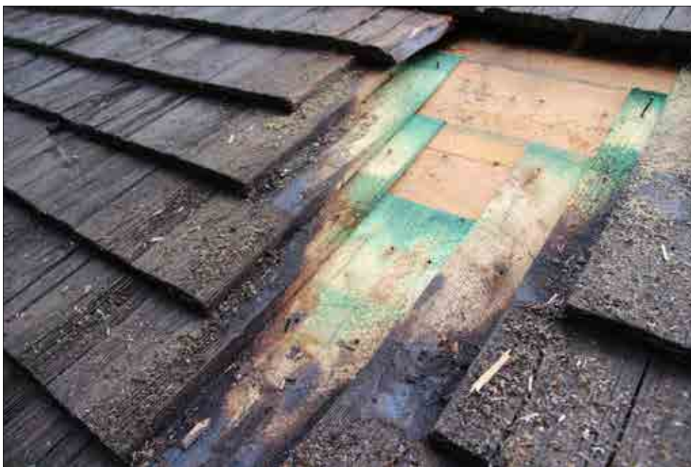
Figur 3.42. Yta med demonterade spån. Foto Lisa Skanser.
