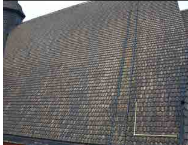
Figur 3.65. Långbusets södra takfall inför uppmätning av spån. Foto Jennie Björklund.
