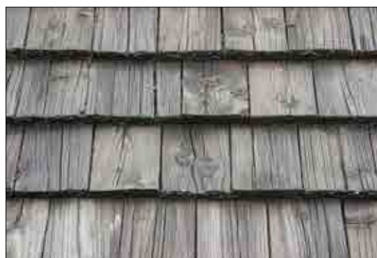
Figur 4.3. Riklig förekomst av kvist på spånen på Kvistbro kyrkas sakristia. Foto Lisa Skanser.
