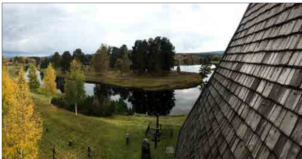
Figur 4.1. Spåntaket på Malungs kyrka har den brantaste taklutningen i hela undersökningen på 65 grader. Foto Daniel Eriksson.
