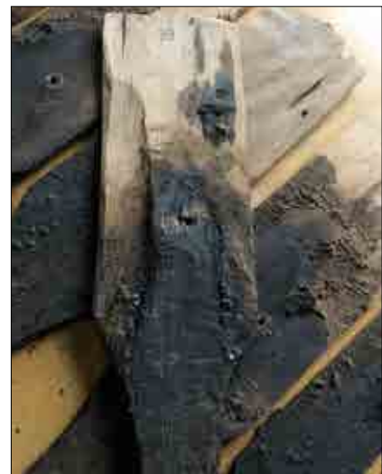
Figur 3.259. Spån som visar kraftig justering i vänsterkanten för överliggande spån. Foto Daniel Eriksson.
