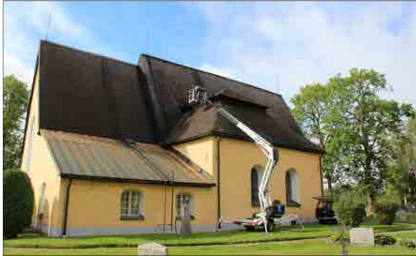
Figur 3.183. Demontering av takspån med hjälp av skylift. Foto Lisa Skanser.
