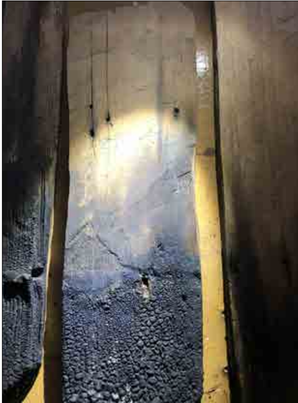
Figur 3.153. Återanvänt spån. Tjären visar nuvarande täckning, erosion visar tidigare. Foto Daniel Eriksson.
