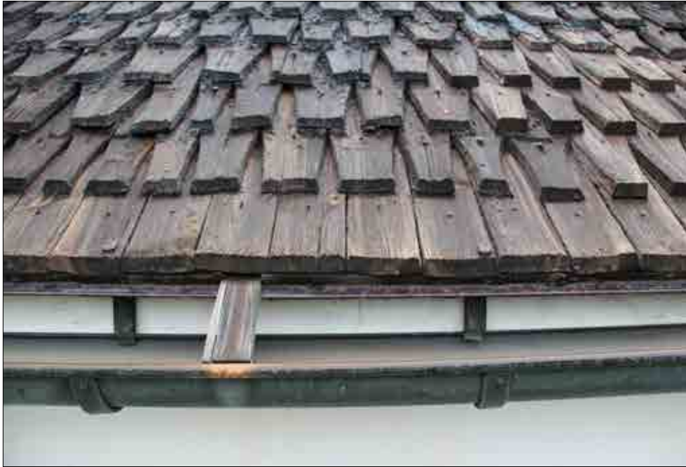
Figur 3.95. Flera spån i takfoten har bytts ut. Foto Lisa Skanser.
