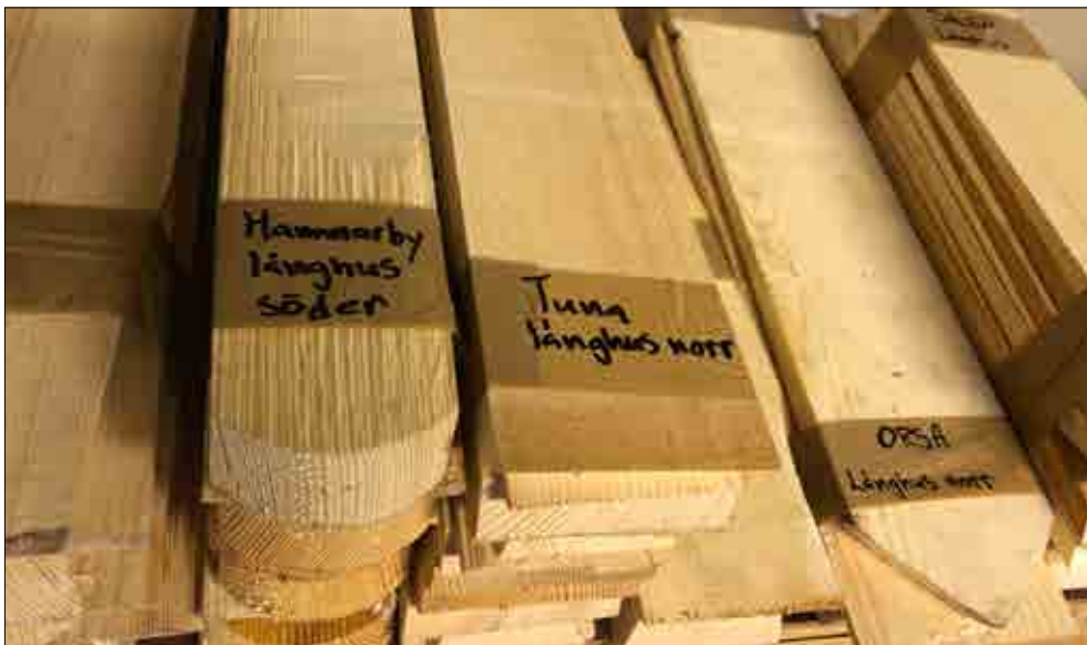
Figur 2.10. Nyttillverkade ersättningspån i väntan på återmontering. Foto Daniel Eriksson.
