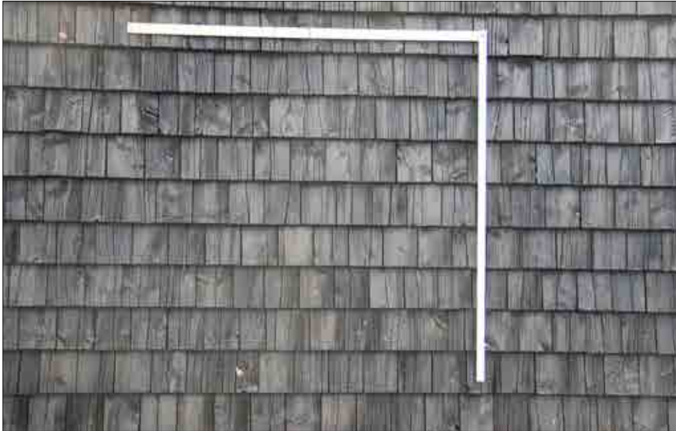
Figur 3.40. Spånnya inför uppmätning. Foto Lisa Skanser.
