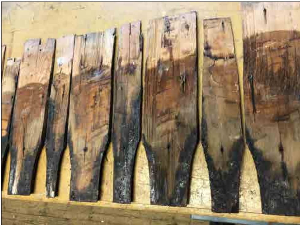
Figur 3.60. Närbild på demonterade spån i verkstad, baksidor. Det syns att spånen varit förstrukna med tjära. Foto Daniel Eriksson.
