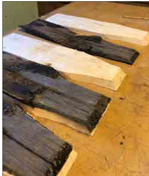
Figur 2.9. Tillverkning av ersättningspån till Ore långhus södra takfall, med de befintliga spånen som mall. Foto Daniel Eriksson.
