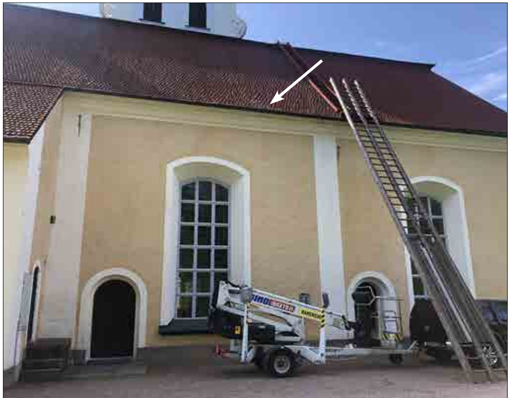
Figur 3.62. Norra takfallet efter återmontering. Pilen markerar de återmonterade spånens placering. Foto Daniel Eriksson.
