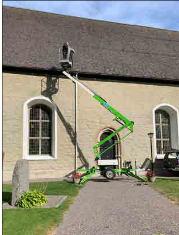
Figur 3.221. Demontering av spån på kyrkans södra takfall. Foto Jennie Björklund.
