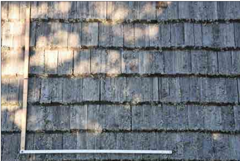
Figur 3.3. Spåntäckning på östra takfallet inför uppmätning. Foto Jennie Björklund.
