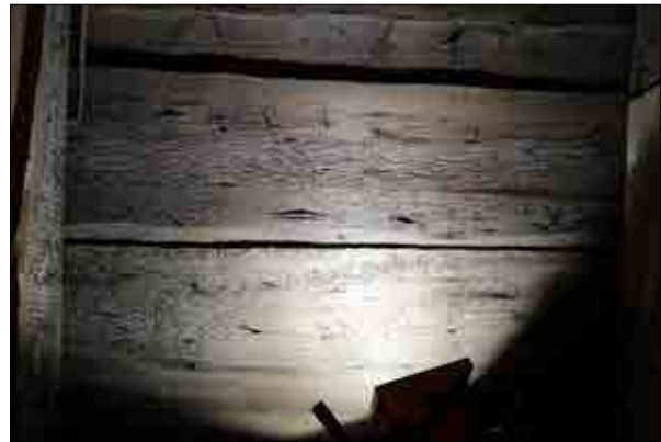
Figur 3.210. Inifrån klockstapeln studerades första generationens spik i första generationen av brädning. Foto Lisa Skanser.
