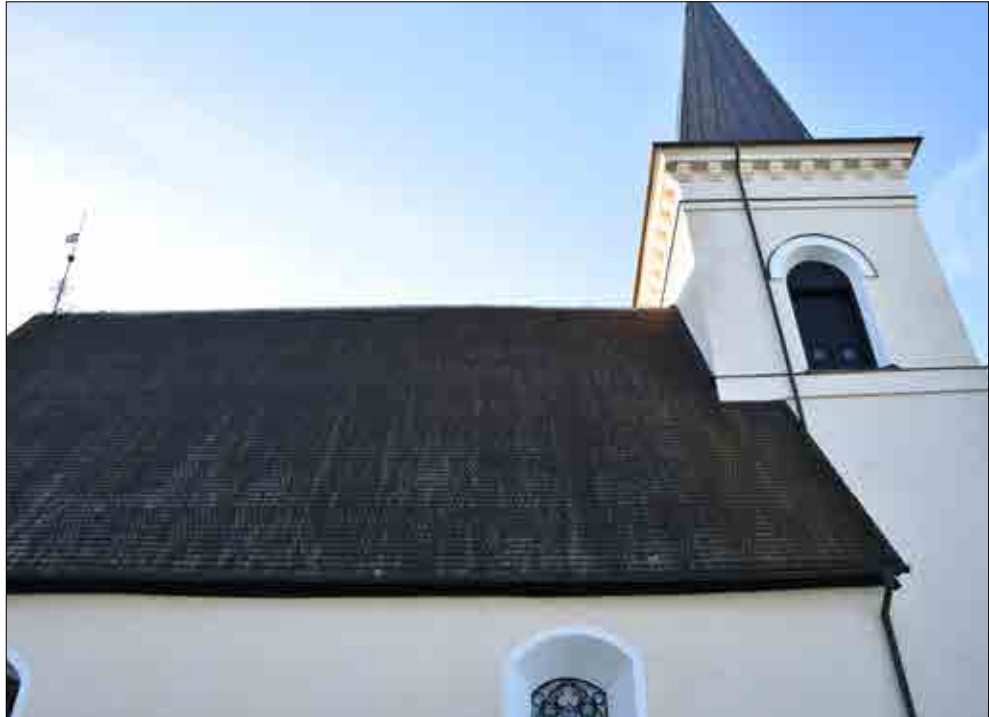
Figur 3.261. Långhusets norra takfall före demontering av spån. Foto Jennie Björklund.
