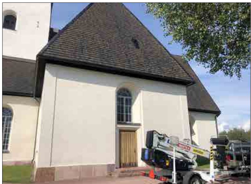
Figur 3.82. Södra korsarmens tak efter återmontering. Foto Daniel Eriksson.
