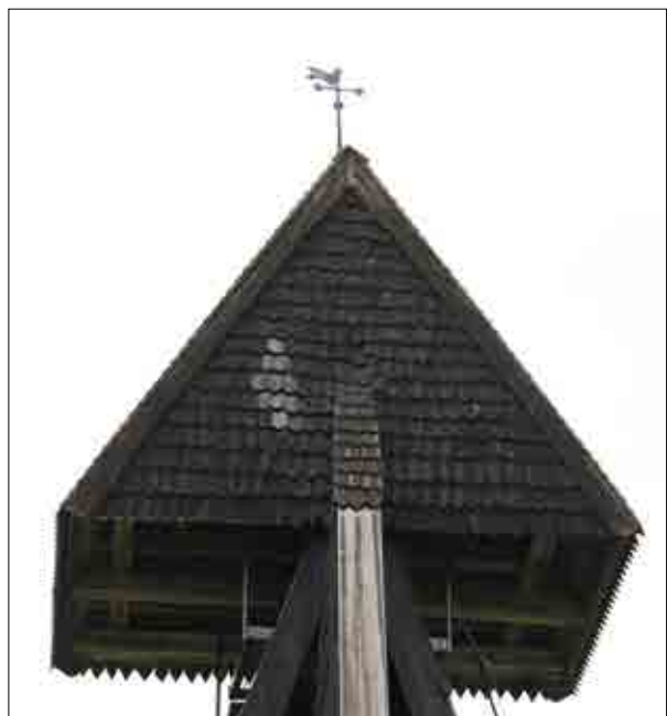
Figur 3.156. Norra fasaden med återmonterade spån, varav ett nyttillverket. Foto Lisa Skanser.
