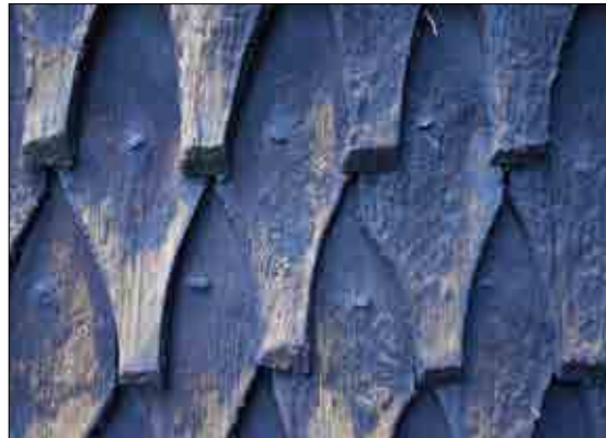
Figur 3.255. Äldre spån österut på fasaden. Mycket eroderade spån med smidd spik. Foto Daniel Eriksson.
