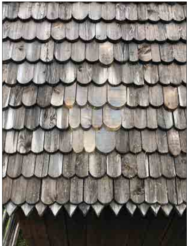
Figur 3.246. Återmontering med spån från kyrkans lager i tornet. Foto Daniel Eriksson.
