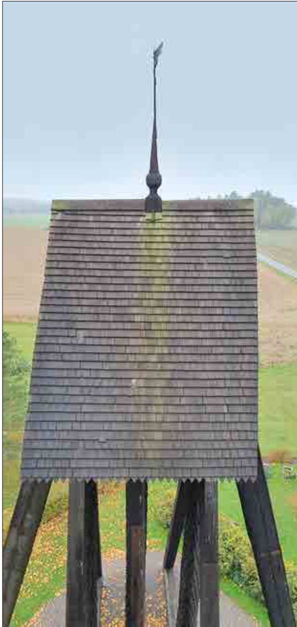
Figur 3.158. Klockstapelns östra takfall före demontering av spån. Foto Lisa Skanser.
