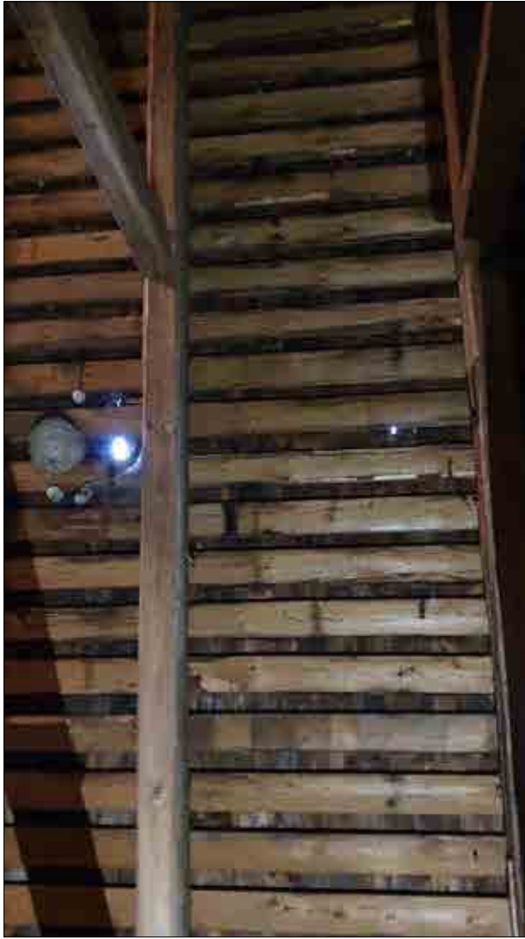
Figur 3.188. Dagsljus strilar in genom spånen, som är lagda på läkt. Foto Lisa Skanser.
