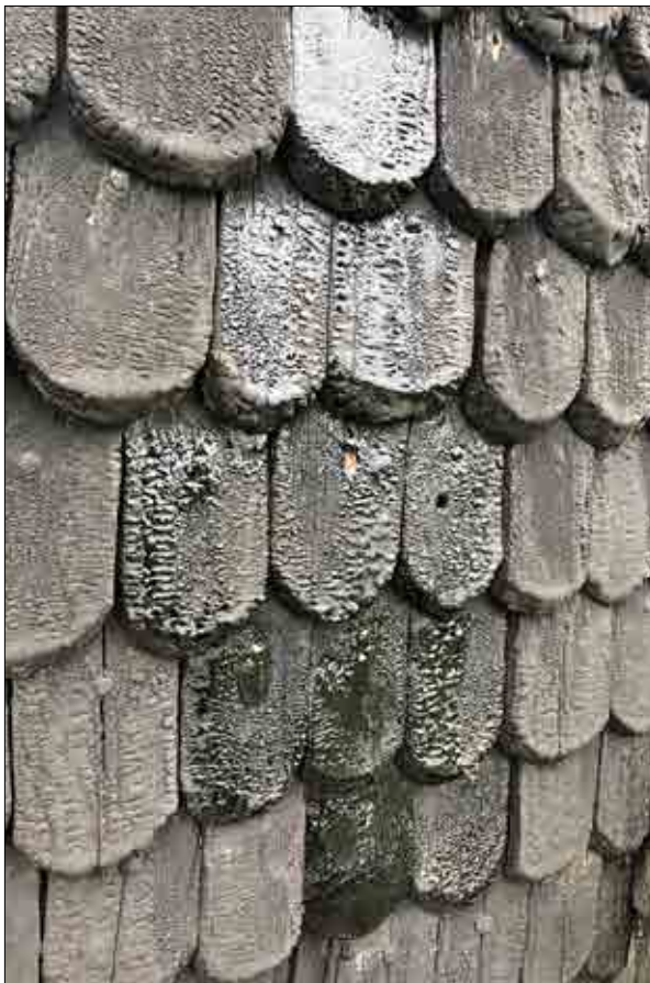
Figur 3.156. Norra fasaden med återmonterade spån, varav ett nyttillverket. Foto Lisa Skanser.
