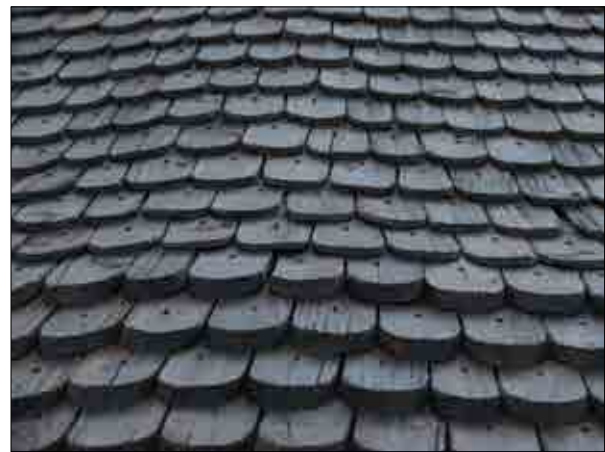
Figur 3.107. Bilden visar övergången mellan de äldre spånen (upptill i bild) och de yngre spånen (nedtill i bild), med en påtaglig skillnad. Foto Lisa Skanser.
