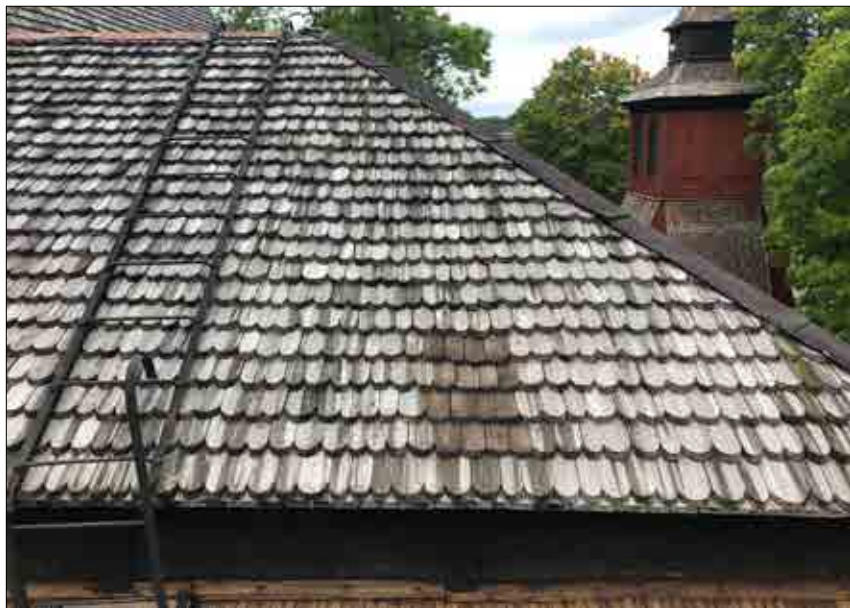
Figur 3.185. Taket med återmonterade ersättningspån. Foto Daniel Eriksson.
