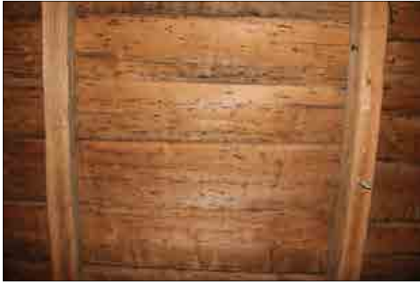
Figur 3.31. Undertak med många spikgenerationer på södra takfallet, långhusets vind. Foto Lisa Skanser.
