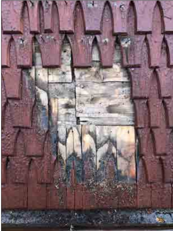
Figur 3.58. Demonterade spån på norra långhustaket. Foto Daniel Eriksson.
