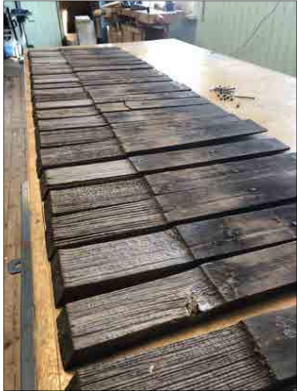
Figur 3.32. Spån från långhusets södra takfall. Eroderingen syns tydligt. Foto Daniel Eriksson.
