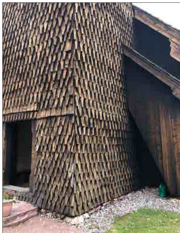
Figur 3.250. Undersökningsytan är skyddad under en trappa och därmed relativt opåverkad av väder och vind. Det ger en chans att studera relativt opåverkade spån. Foto Daniel Eriksson.
