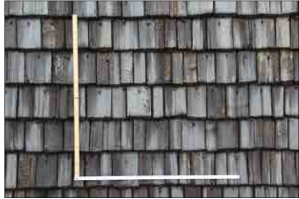
Figur 3.74. Spåntaket med mätstockar inför uppmätning. Foto Lisa Skanser.
