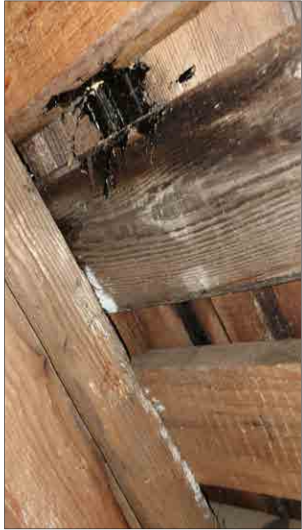
Figur 3.189. Påväxt på virke i undertaket. Foto Lisa Skanser.
