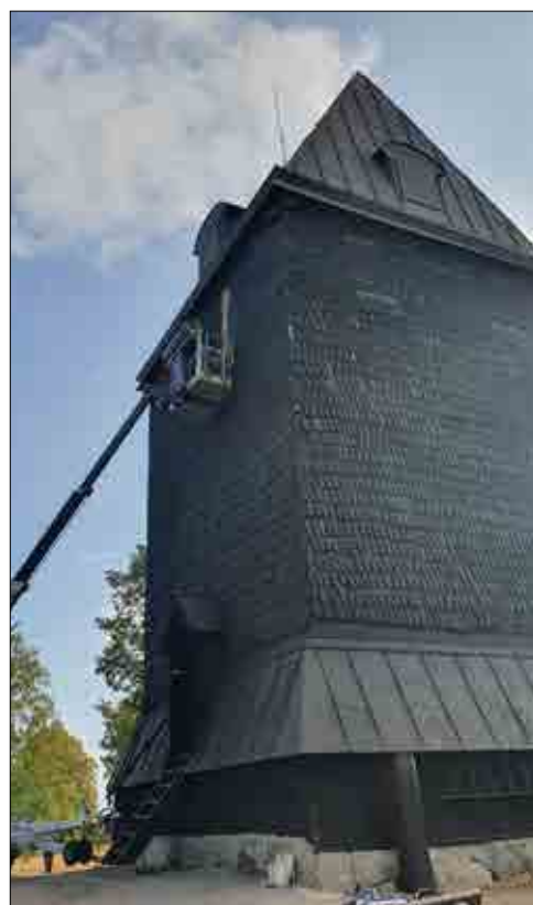
Figur 3.228. Demontering av spån pågår. Foto Lisa Skanser.
