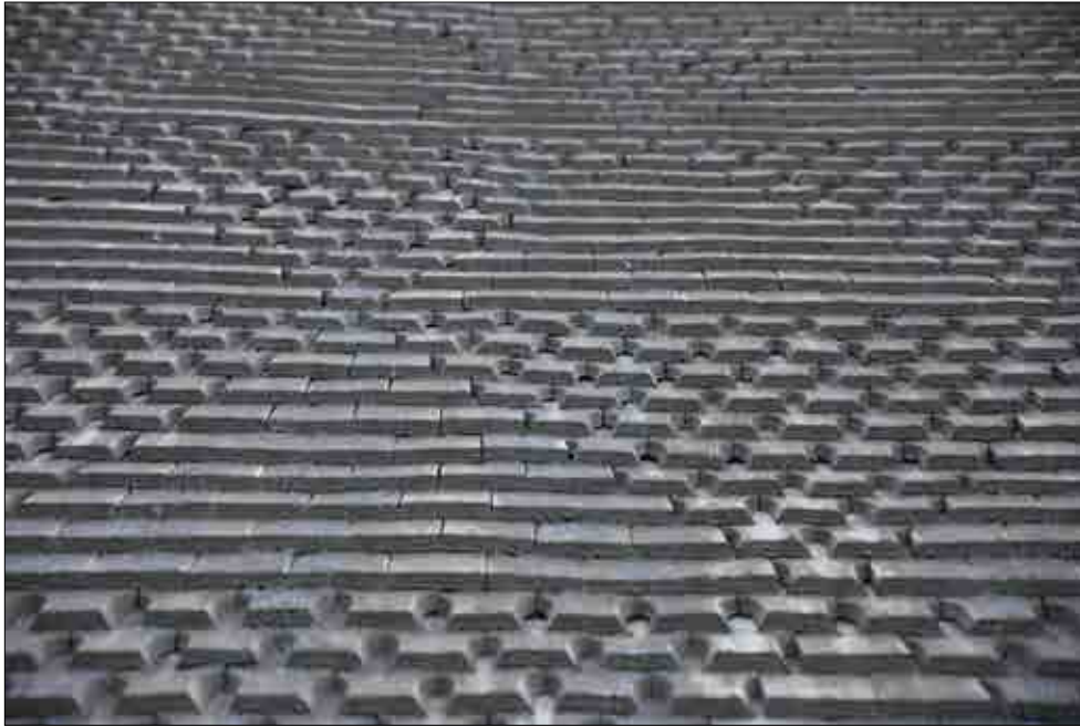
Figur 3.264. Del av spåntäckningen på norra takfallet, notera mönsterläggningen. Foto Jennie Björklund.
