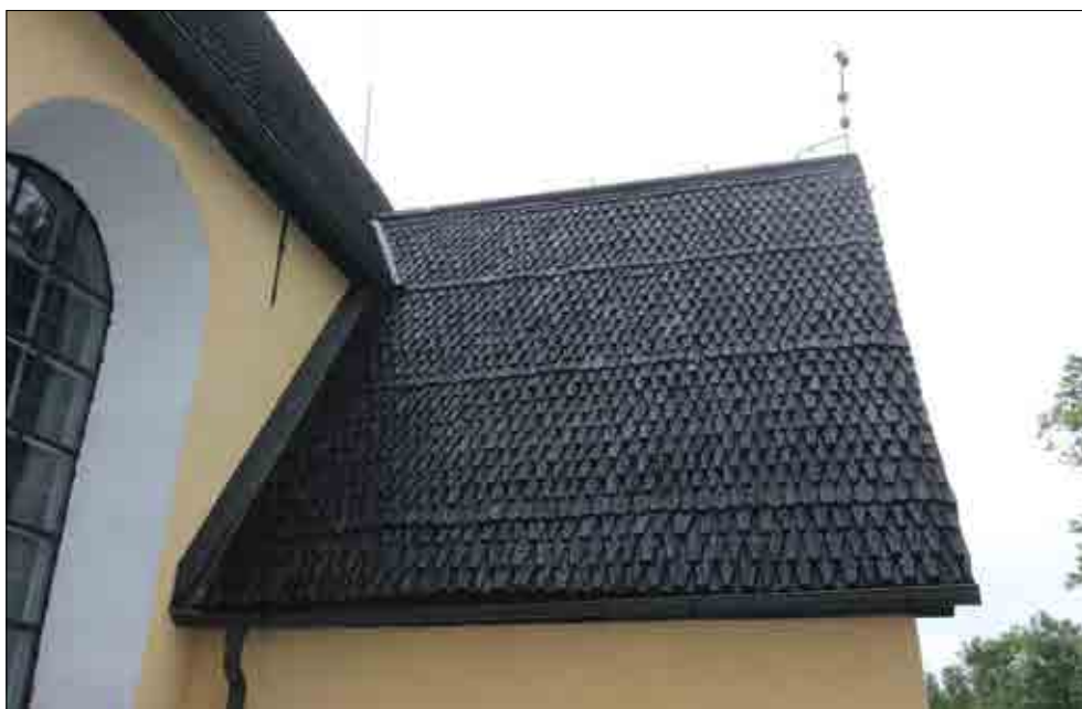
Figur 3.167. Vapenbusets västra takfall före demontering av spån. Foto Lisa Skanser.
