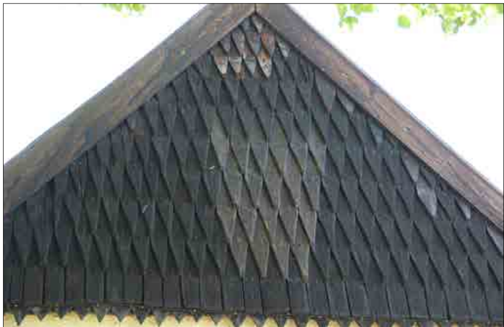
Figur 3.280. Återmonterade spån på norra gavelfasaden. Foto Lisa Skanser.
