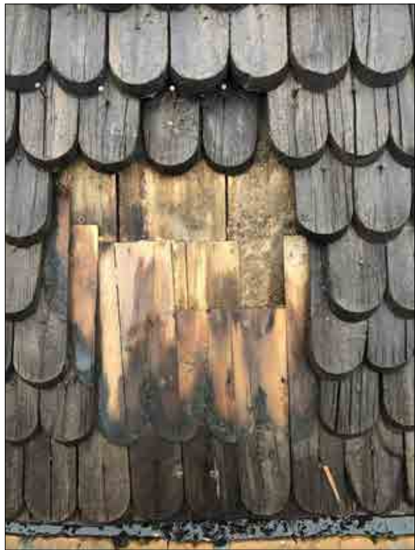
Figur 3.109. Taket efter demontering av spån. Foto Daniel Eriksson.
