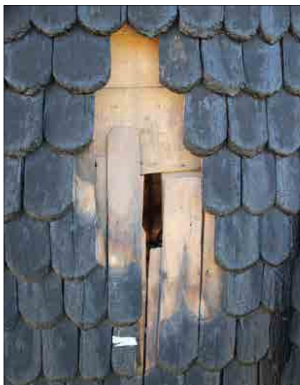
Figur 3.150. Yta med demonterade spån. Foto Lisa Skanser.
