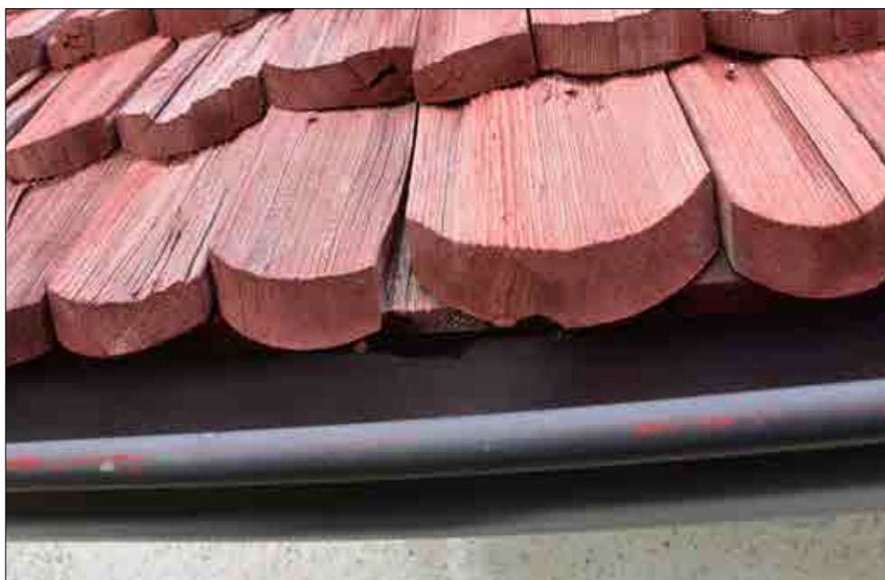
Figur 4.8. Ändrät på spån från Hammarby kyrka har spruckit upp i kubliktande bitar. Foto Jennie Björklund
