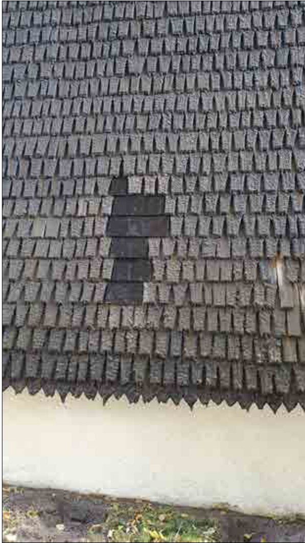
Figur 3.208. Tillfällig intäckning efter demontering av spån. Foto Lisa Skanser.
