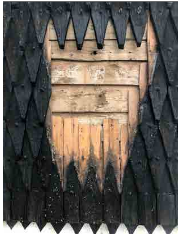
Figur 3.277. Närbild på yta efter demontering av spån. På underlaget syns att spånen är den första generationen. Foto Daniel Eriksson.
