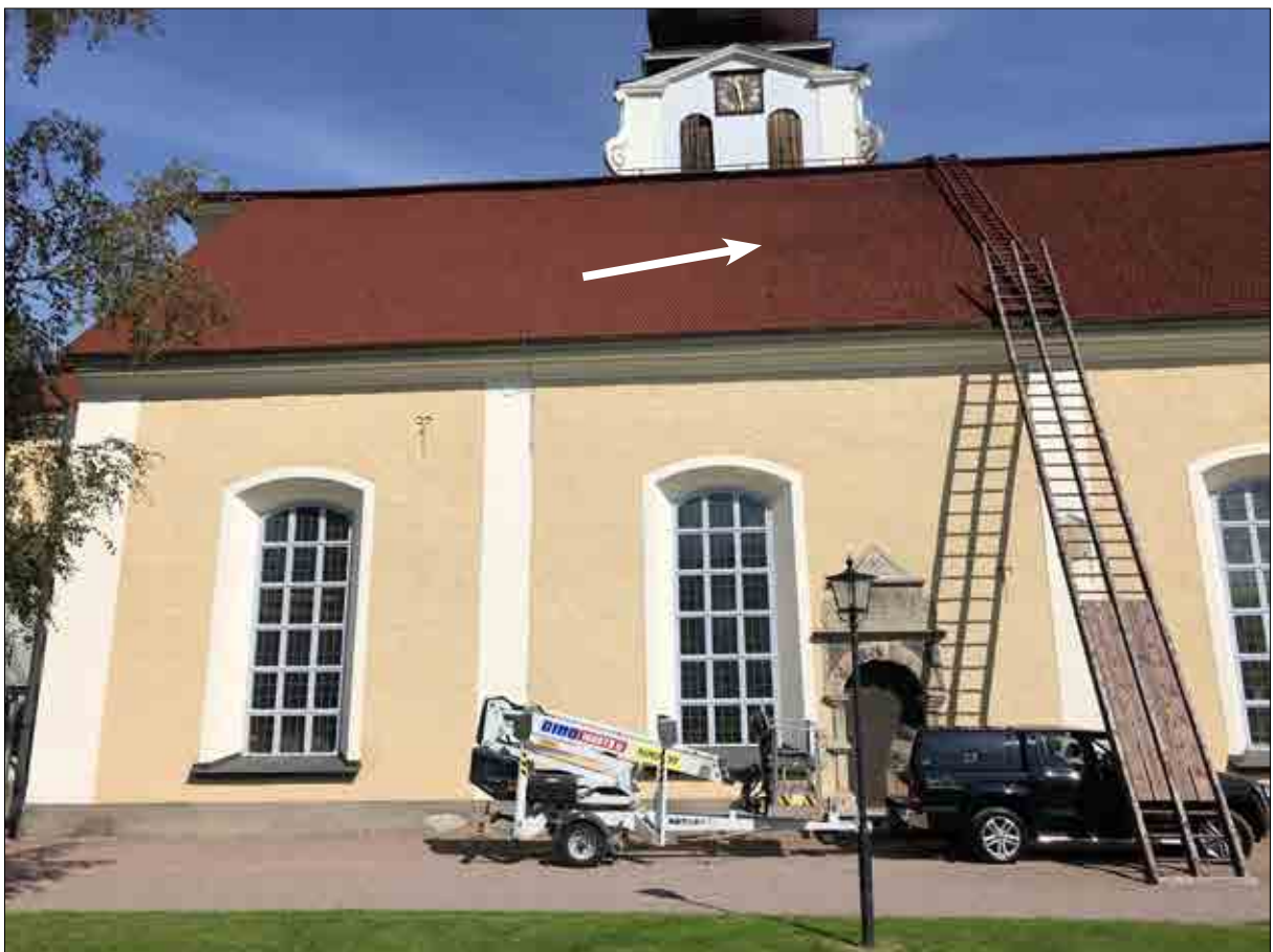
Figur 3.49. Södra takfallet efter återmontering. Pilen markerar de återmonterade spånens placering. Foto Daniel Eriksson.
