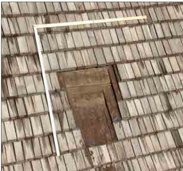
Figur 3.34. Del av långhusets södra takfall efter demontering. Foto Lisa Skanser.
