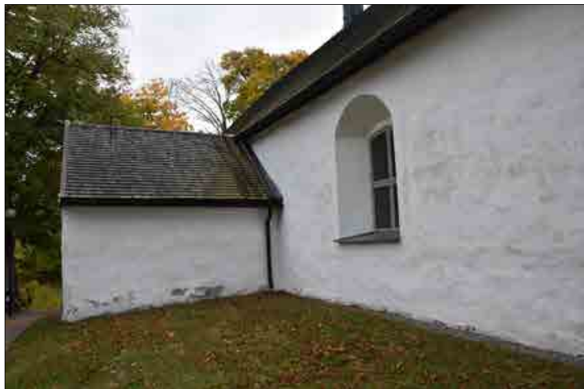
Figur 3.298. Västra takfallet på sakristian efter montering av ersättningspån. Foto Jennie Björklund.
