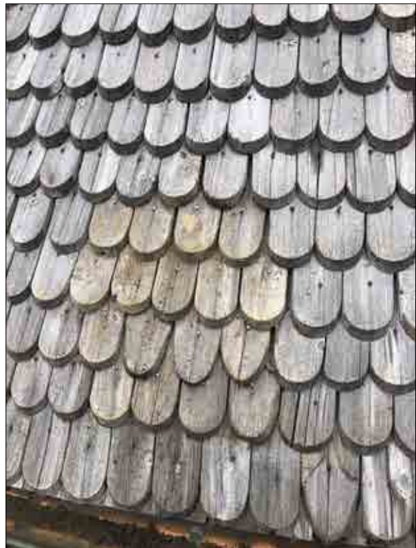
Figur 3.111. Återmonterade spån taket. Foto Daniel Eriksson.
