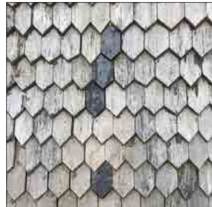
Figur 3.137. Återmonterade spån på norra långbustaket. Foto Daniel Eriksson.
