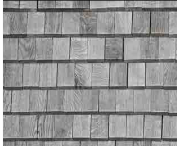
Figur 3.141. Detalj av spåntäckningen på södra takfallet. Foto Jennie Björklund.
