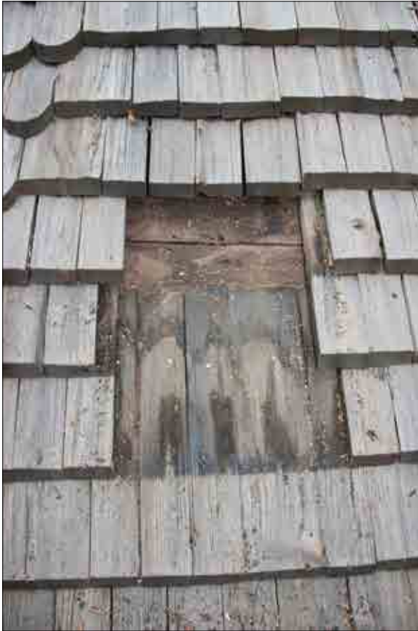
Figur 3.200. Spåntäckning på vapenbusets östra takfall efter demontering. Foto Líska Skanser.
