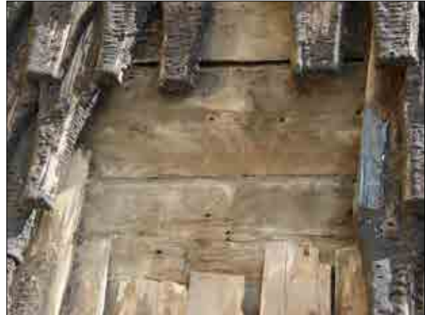
Figur 3.169. Detaljbild efter demontering. Andra generationen spån på undertak daterat till 1315. Foto Lisa Skanser.
