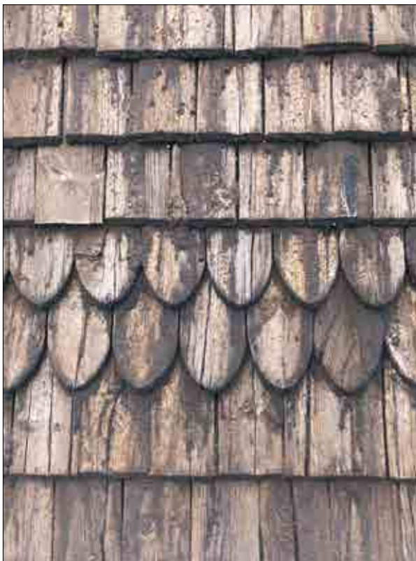
Figur 3.192. Detalj av spåntäckning på långhusets södra takfall före demontering. Foto Daniel Eriksson.
