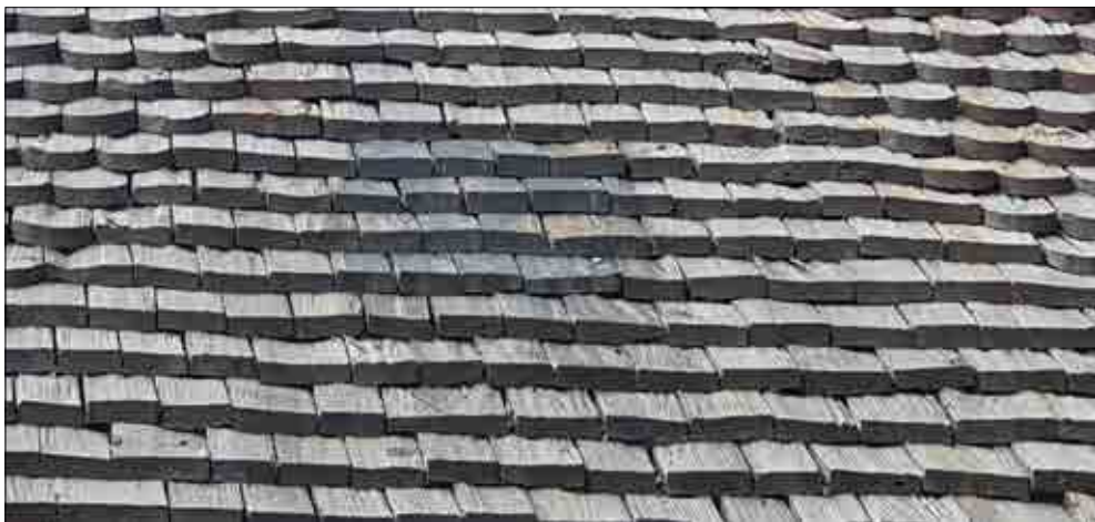
Figur 3.205. Närbild på återmonterade spån på vapenhuset. Foto Lisa Skanser.
