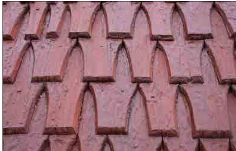
Figur 3.56 Detalj av spåntäckning på långhusets norra takfall. Foto Sanna Svensson.
