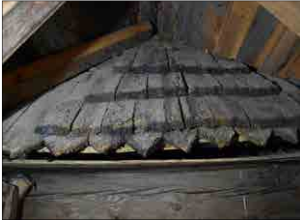
Figur 3.140. Inbyggd äldre spåntäckning synlig på vinden. Foto Jennie Björklund.
