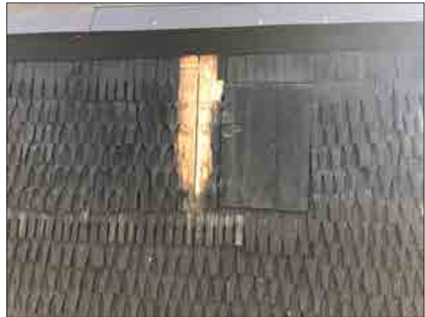
Figur 3.233. Efter demontering av spån, klockstapelns norra fasad. Foto Daniel Eriksson.
