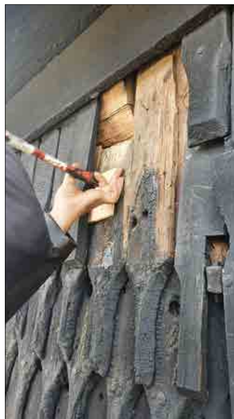
Figur 2.6. Närbild på spåndemontering på Svedvi klockstapel. Foto Låsa Skanser.
