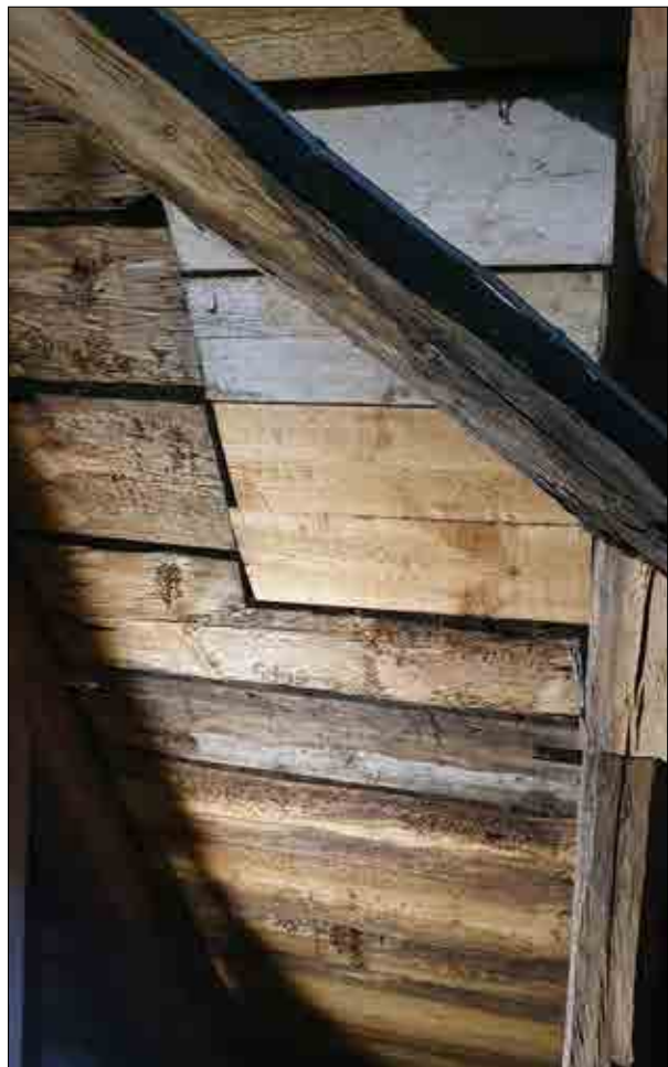
Figur 3.19. Foto taget inifrån vinden. Här upptäcktes rötskador och mögelsporer. Foto Lisa Skanser.
