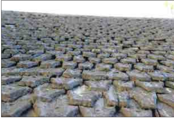
Figur 3.168. Närbild av spåntäckningen på västra takfallet. Foto Lisa Skanser.
