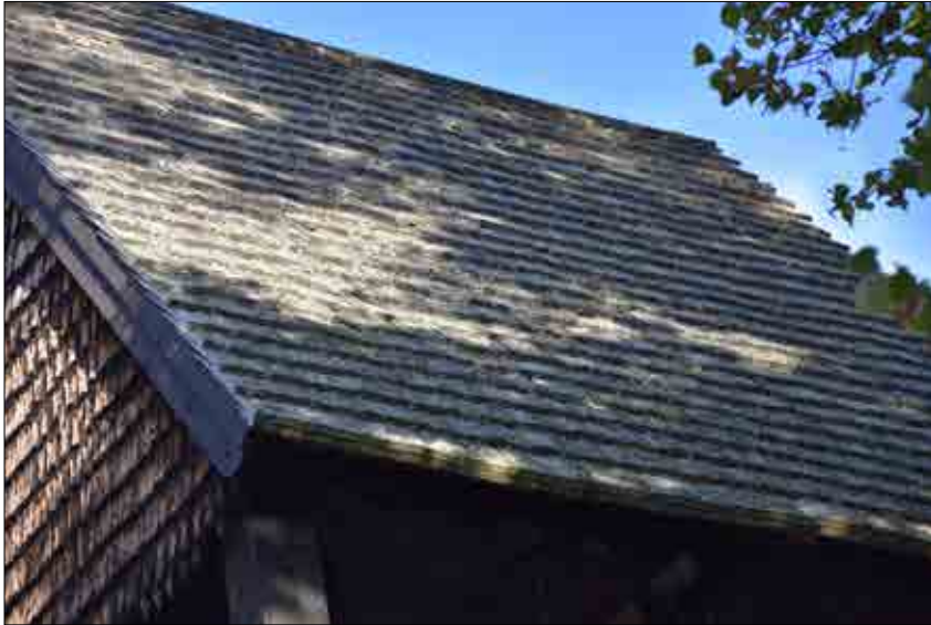
Figur 3.2. Klockstapelns östra takfall före demontering. Foto Jennie Björklund.
