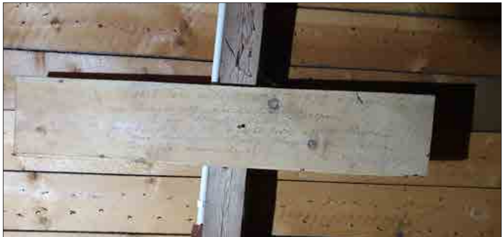
Figur 3.38. På sakristians vind står skrivet på en bräda: "Taket här omlagt omkring år 1950 i juni ensamt av fastighetsäg Axel Karlsson, Gropen [...]". Foto Lisa Skanser.
