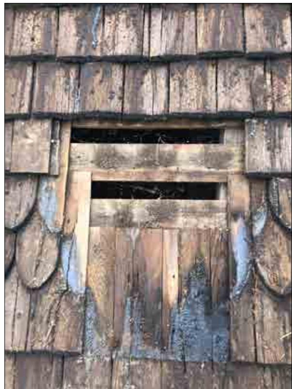
Figur 3.193. Taket efter demontering av spån. Foto Daniel Eriksson.
