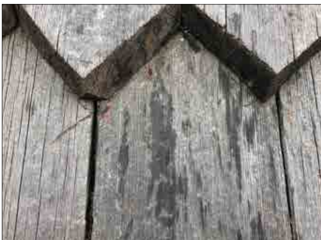
Figur 3.132. Insidan av undertaket med spikar och huggspår. Foto Sanna Svensson.
