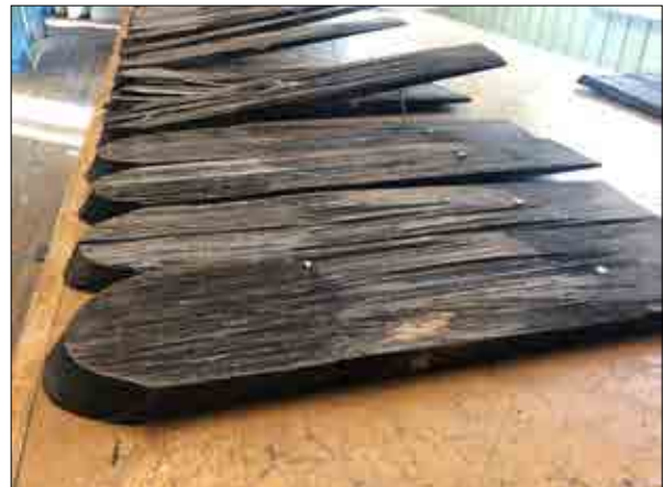
Figur 3.181. Demonterade spån i verkstad, ovensidor. Foto Daniel Eriksson.
