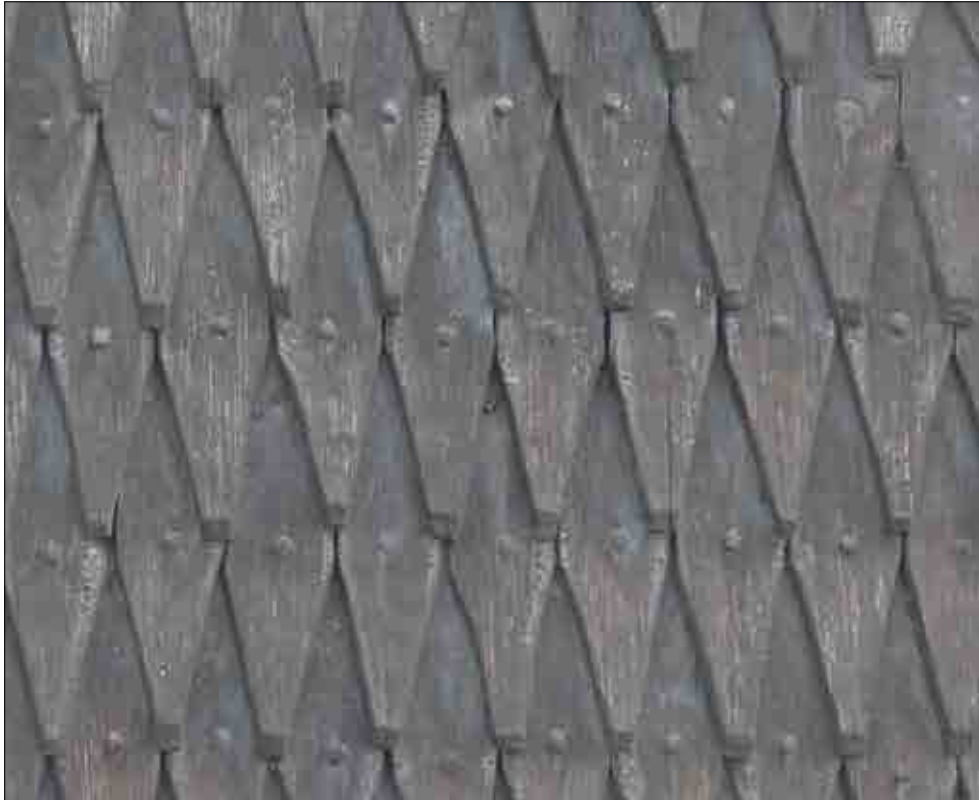
Figur 3.275. Fasadspån på sakristian. Foto Lisa Skanser.
