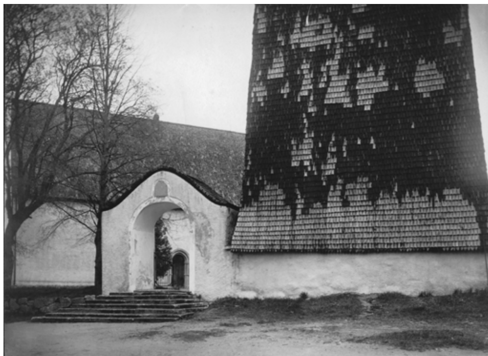
Figur bilaga 4.1. På fotot syns att spån har bytts ut på klockstapelns sydvästra fasad. Fotot är taget av Samuel Lindskog år 1929. Bildkälla: Riksantikvarieämbetet.
