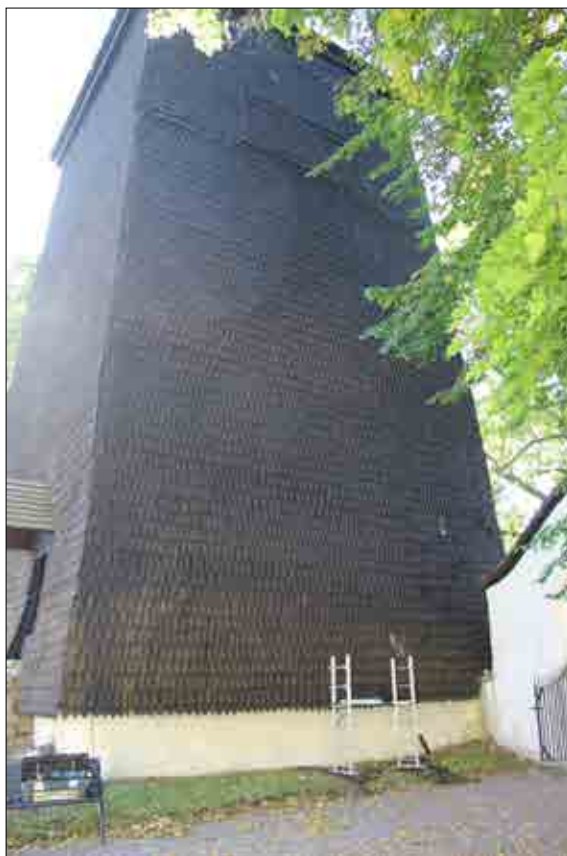
Figur 3.207. Klockstapeln fotograferad från nordväst. Den västra fasaden har den mest intakta och oförändrade spåntäckningen. Foto Lisa Skanser.
