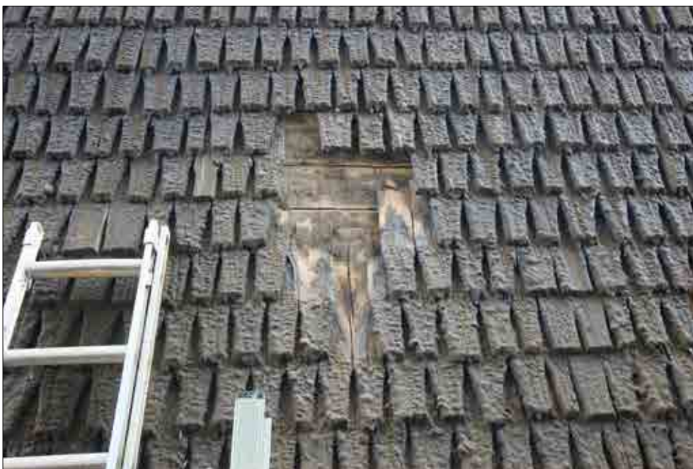
Figur 3.211. Efter demontering av spån på klockstapelns fasad. Foto Lisa Skanser.
