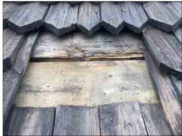
Figur 3.124. Södra långhustaket efter demontering av spån. Foto Daniel Eriksson.
