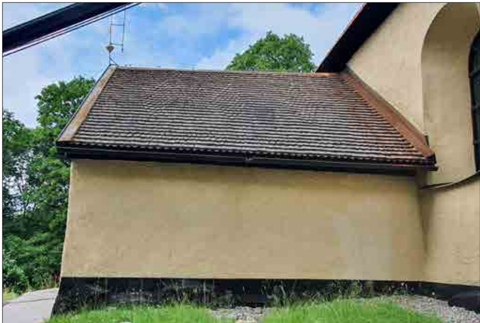
Figur 3.204. Vapenhusets västra takfall efter återmontering. Foto Lisa Skanser.
