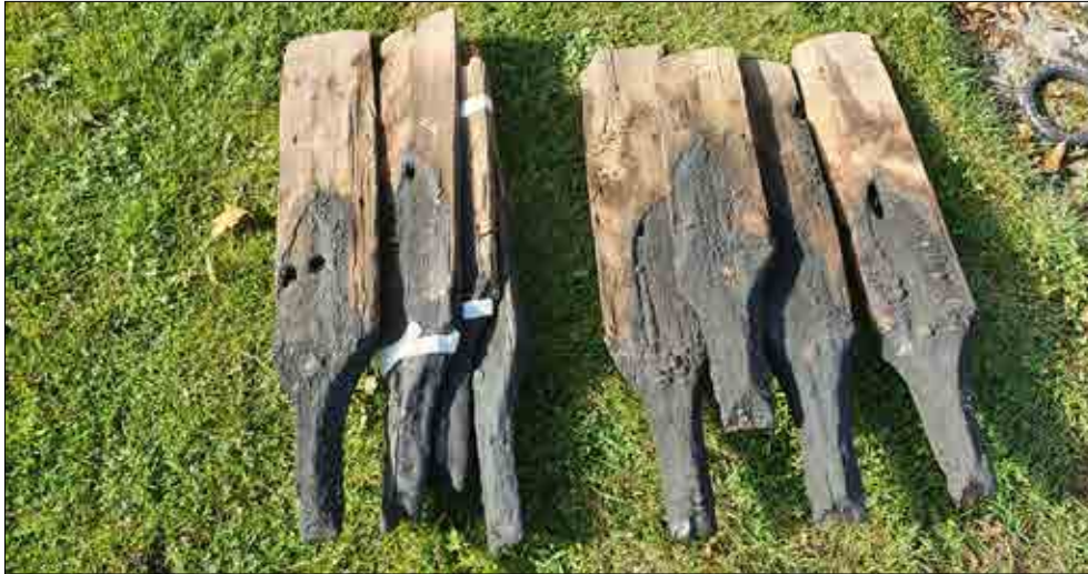
Figur 2.7. Demonterade fasadspån från Svedvi klockstapel. Foto Lisa Skanser.
