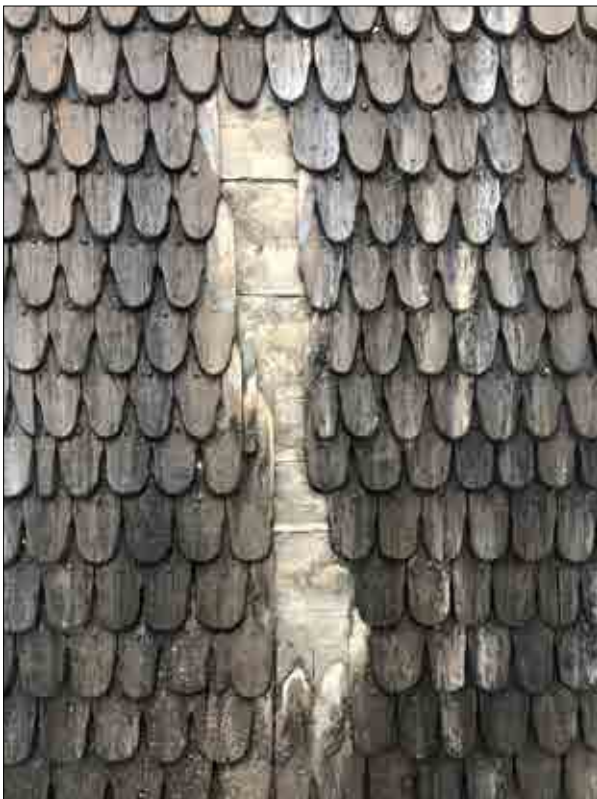
Figur 3.117. Taket efter demontering av spån. Foto Daniel Eriksson.
