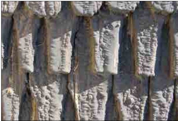
Figur 3.170. Detalj av spåntäckningen på vapenhusets västra takfall. Foto Lisa Skanser.
