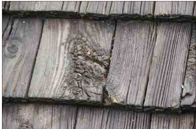
Figur 3.41. Detalj av spåntäckning, böj förekomst av kvistar. Foto Lisa Skanser.
