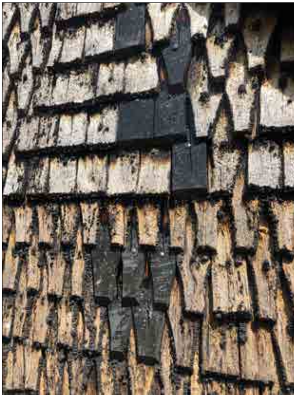
Figur 3.17. Återmonterade spån på klockstapelns södra fasad. Nyttillverkade spån har tjärats. Foto Daniel Eriksson.
