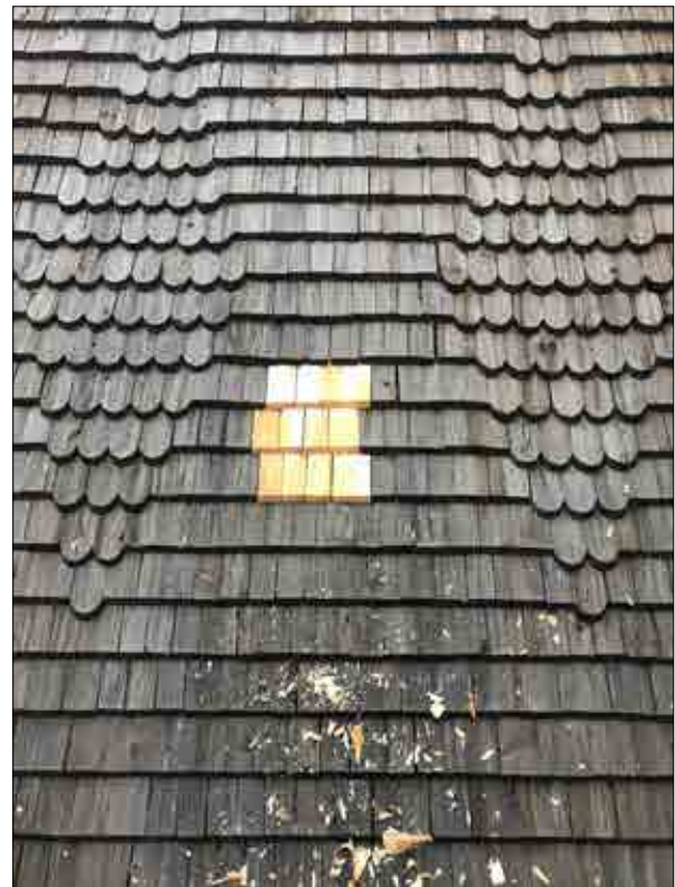
Figur 3.201. Nya ersättningsspån monterade på vapenbusets västra takfall. Foto Daniel Eriksson.
