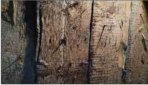
Figur 3.73. Undertaket med spikar sett från vinden. Foto Lisa Skanser.
