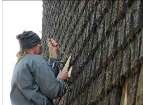
Figur 3.209. Bengt Bygdén demonterar spån på klockstapelns fasad. Foto Lisa Skanser.
