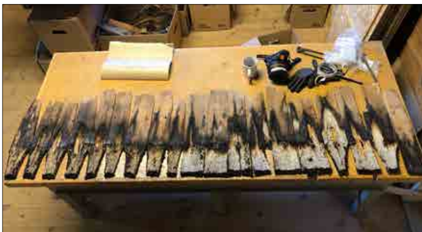
Figur 2.11. Arbetet i verkstaden börjar med att placera alla demonterade spån intill varandra. Här visas spånen från buven på Bärbo klockstapel. Foto Daniel Eriksson.
