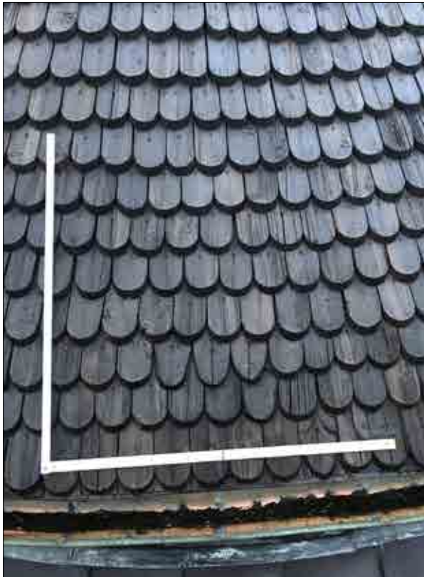
Figur 3.108. Kortaket inför uppmätning av spån. Foto Daniel Eriksson.
