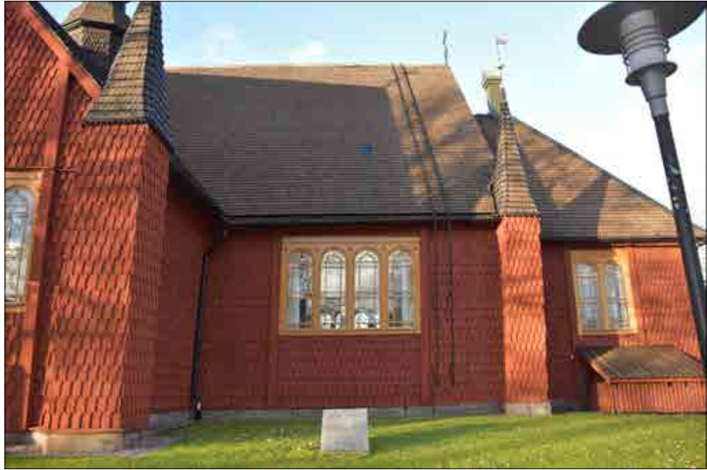
Figur 3.69. Ersättningspån på långhusets södra takfall. Foto Jennie Björklund.
