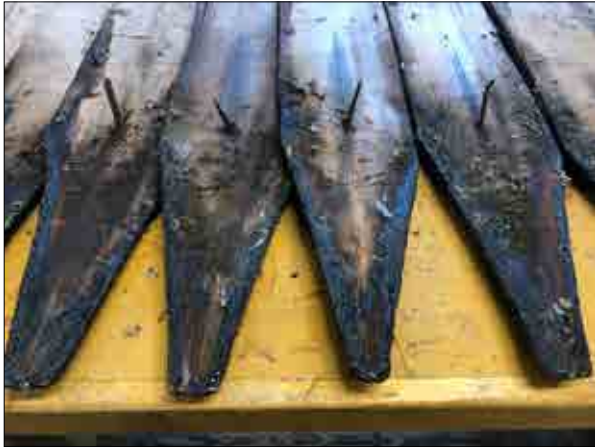
Figur 3.278. Demonterade spån i verkstad. På baksidan syns vad som möjligen är rödfärg. Foto Daniel Eriksson.
