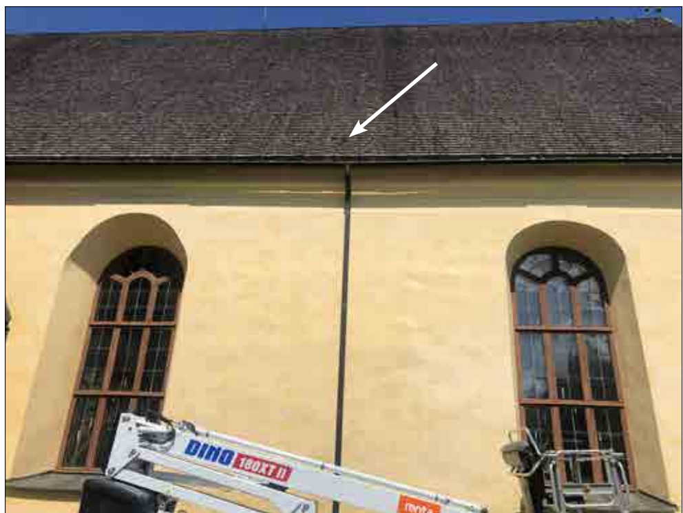
Figur 3.92. Återmonterade spån på avstånd, markerade med en pil. Foto Daniel Eriksson.
