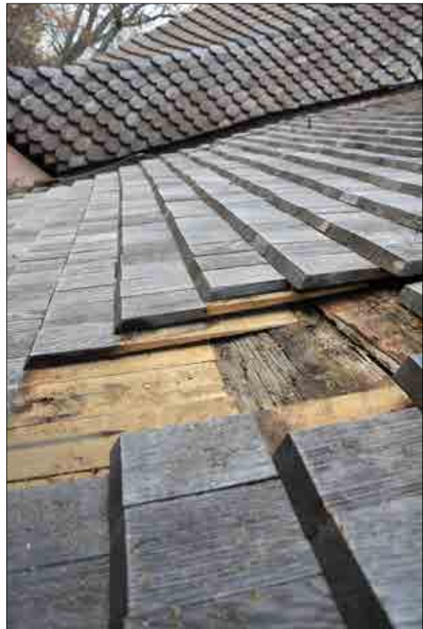
Figur 3.143. 3-lagstäckning på södra takfallet. Foto Jennie Björklund.
