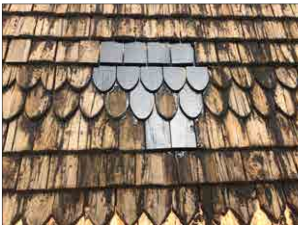
Figur 3.196. I släpljus framträder sågspår på framsidan av spånet. Foto Daniel Eriksson.
