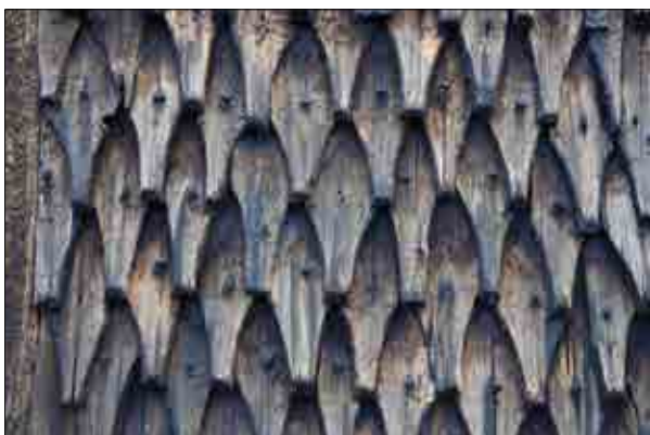
Figur 3.249. Spånytan uppvisar eroderingslinjer efter hur spånen suttit tidigare vilket tyder på återanvändning. Foto Sanna Svensson.
