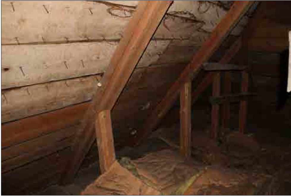
Figur 3.115. Underlagstaket med spikar sett inifrån vinden. Foto Lisa Skanser.
