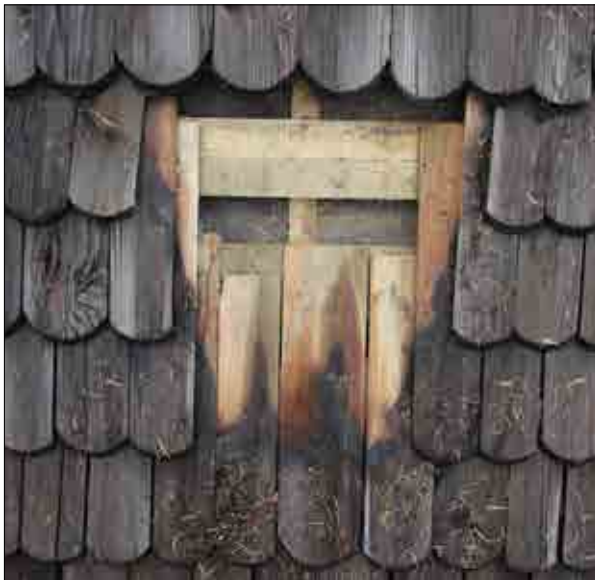
Figur 3.245. Efter demontering av spån. Tryckimpregnerad läket på papp. Foto Lisa Skanser.
