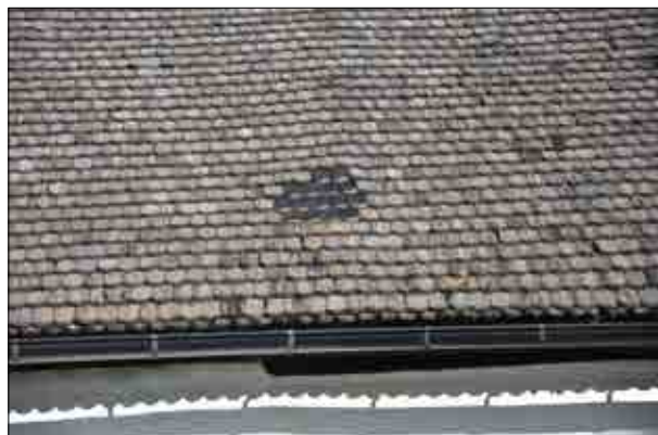
Figur 3.290. Nya spån på plats efter återmontering. Foto Jennie Björklund.
