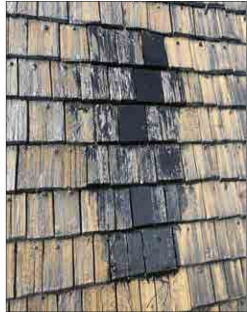
Figur 3.80. Återmonterade spån på korsarmens södra takfall. Foto Daniel Eriksson.
