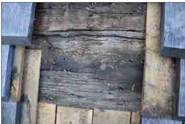
Figur 3.144. Underlaget består av kluvna och buggna brädor som kan vara original från taklagets byggnation. Foto Jennie Björklund.
