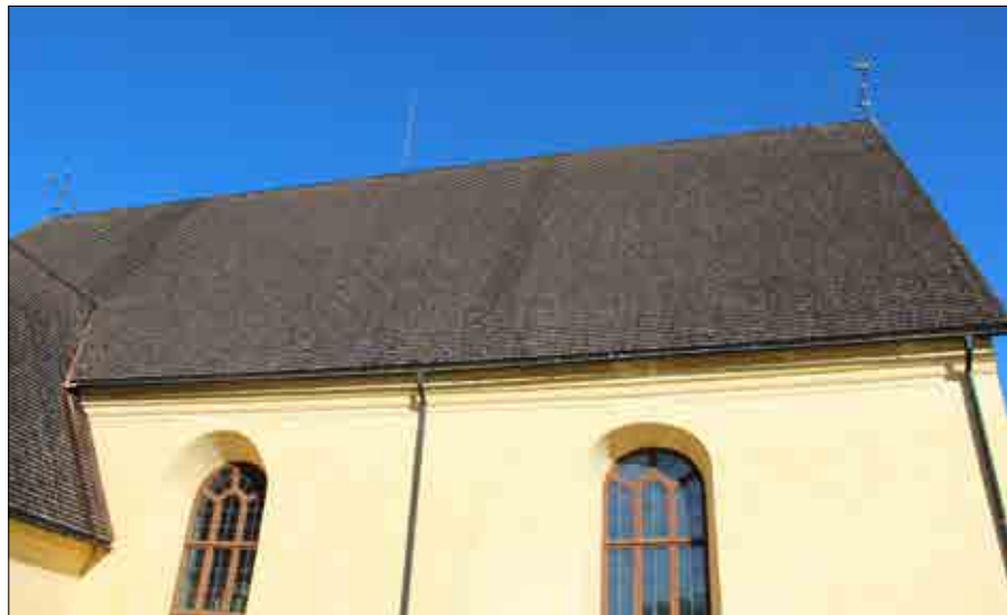
Figur 3.86. Södra takfallet före demontering av spån. Foto Lisa Skanser.
