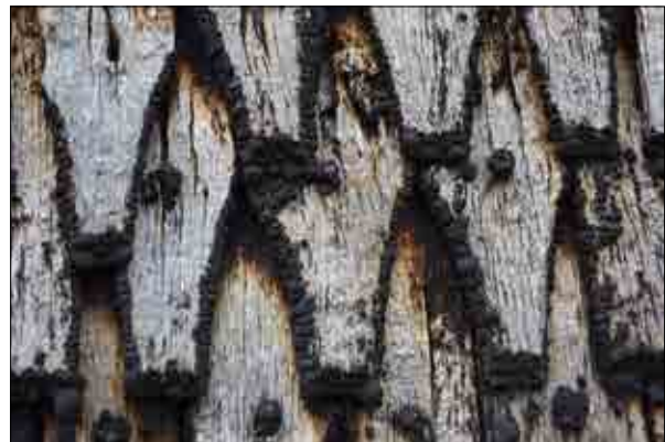
Figur 3.14. Den övre halvan av södra fasaden har ekspån. Foto Jennie Björklund.
