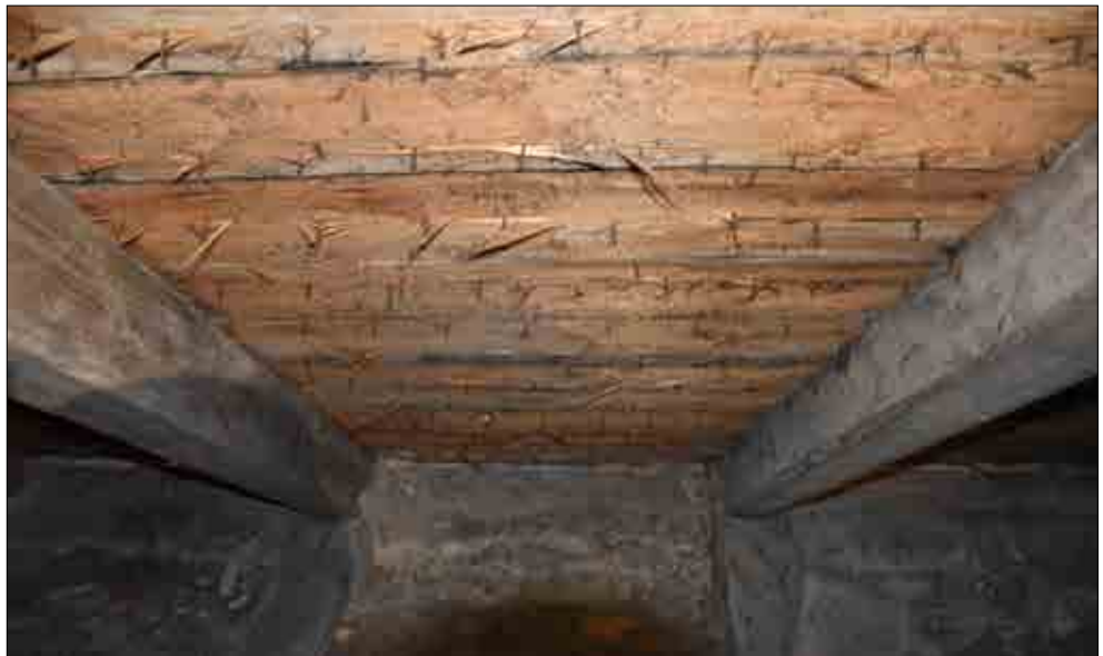
Figur 3.57. Norra takfallets undertak uppvisar två generationers spikebäl. Foto Sanna Svensson.
