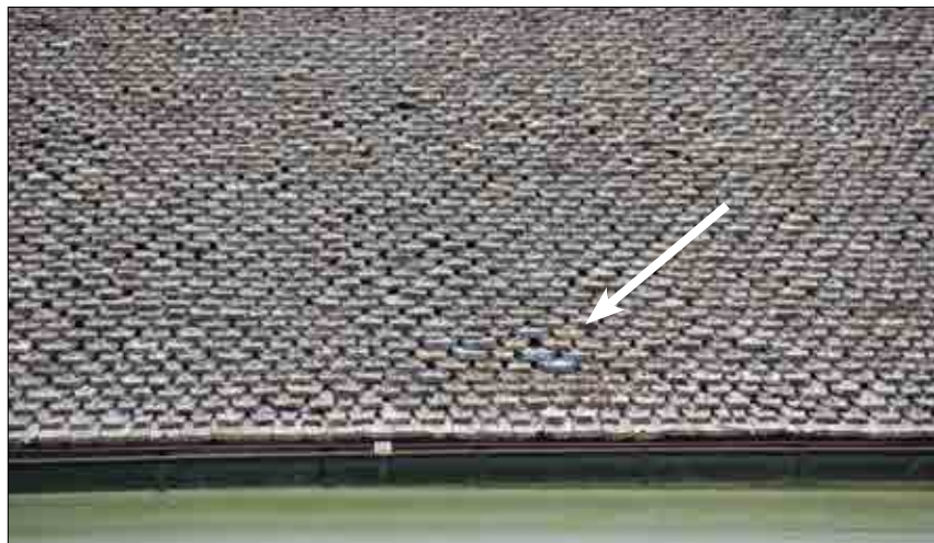
Figur 3.103. Återmonterade spån på södra takfallet, markerade med pil. Foto Daniel Eriksson.
