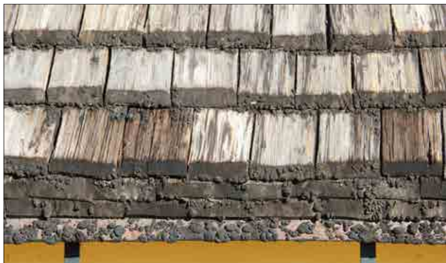
Figur 3.87. Uppbyggnad av spån vid takfot. Ändröret visar att spånämnenas uttag inte varit viktigt. Årsringarnas orientering varierar, likaså tätvuxenbeten i virket. Foto Lisa Skanser.
