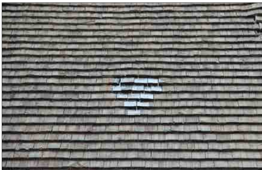
Figur 3.43. Nymonterade spån på sakristians västra takfall. Foto Lisa Skanser.
