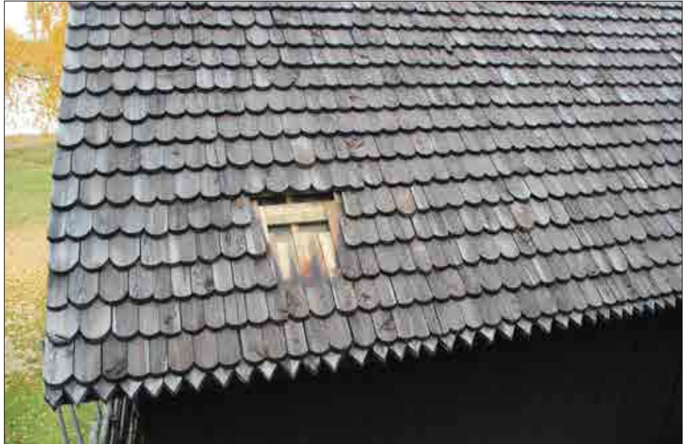
Figur 3.244. Sakristians västra takfall efter demontering av spån. Foto Lisa Skanser.
