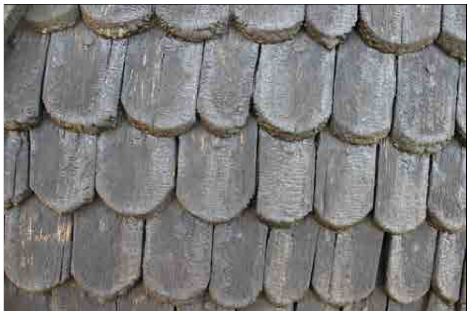
Figur 3.152. Detalj av fasadspån på klockstapelns norra sida. Foto Lisa Skanser.
