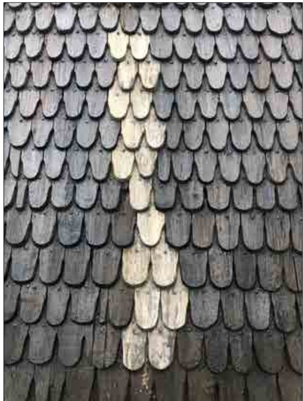
Figur 3.120. Sakristians tak efter återmontering av spån. Foto Daniel Eriksson.
