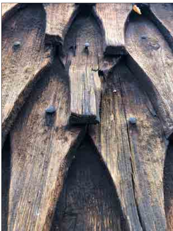
Figur 3.252. Detalj av spån med erosion. Vissa spån har hål och sprickbildning. Foto Daniel Eriksson.
