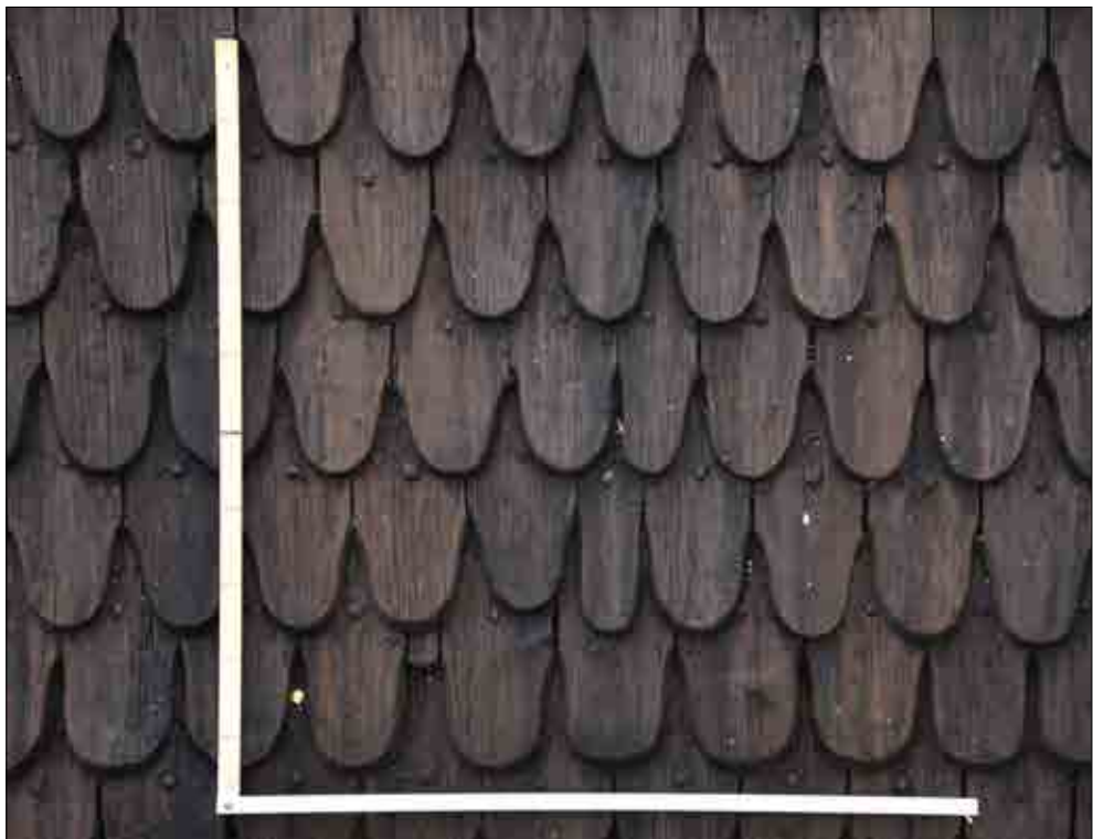
Figur 3.114. Spånnya med mätstockar inför uppmätning. Foto Sanna Svensson.
