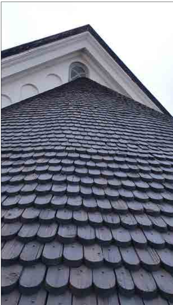
Figur 3.107. Bilden visar övergången mellan de äldre spånen (upptill i bild) och de yngre spånen (nedtill i bild), med en påtaglig skillnad. Foto Lisa Skanser.
