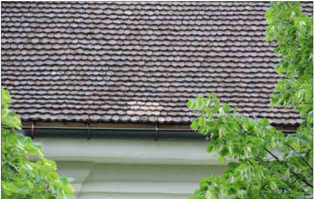
Figur 3.128. Återmonterade spån på södra takfallet, inga nytillverkade. Foto Daniel Eriksson.
