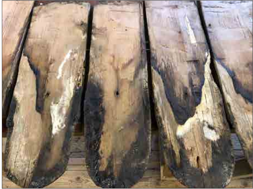
Figur 3.118. Demonterade spån med någon form av påväxt på baksidan. Foto Daniel Eriksson.
