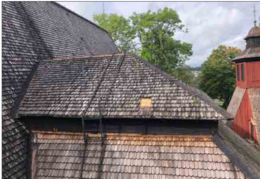
Figur 3.184. Korsarmstaket efter demontering av spån. Foto Daniel Eriksson.
