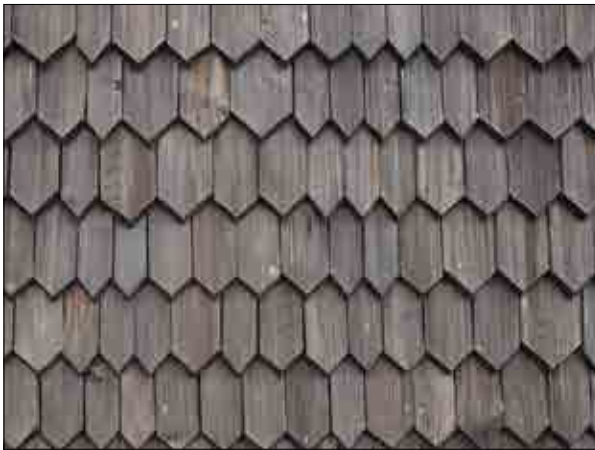
Figur 3.123. Detalj av spånen på södra långhustaket. Foto Sanna Svensson.
