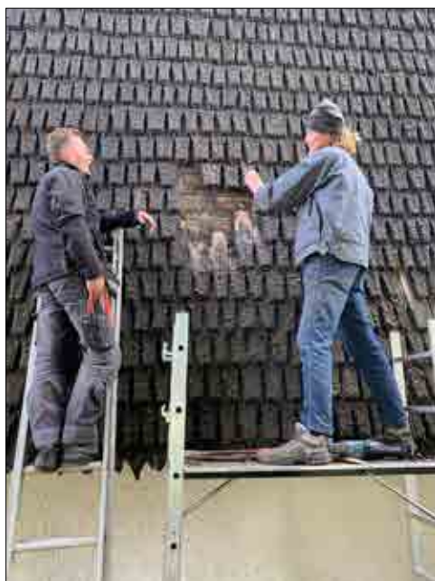
Figur 2.5. Timmerna Daniel Eriksson och Bengt Bygdén demonterar spån på Sköllersta klockstapel, ovanligt nog behövs här ingen skylift. Foto Jennie Björklund.
