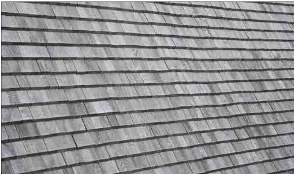
Figur 4.6. På Ripsta kyrka finns ingen synlig ytbehandling på spåntäckningen. Foto Jennie Björklund.
