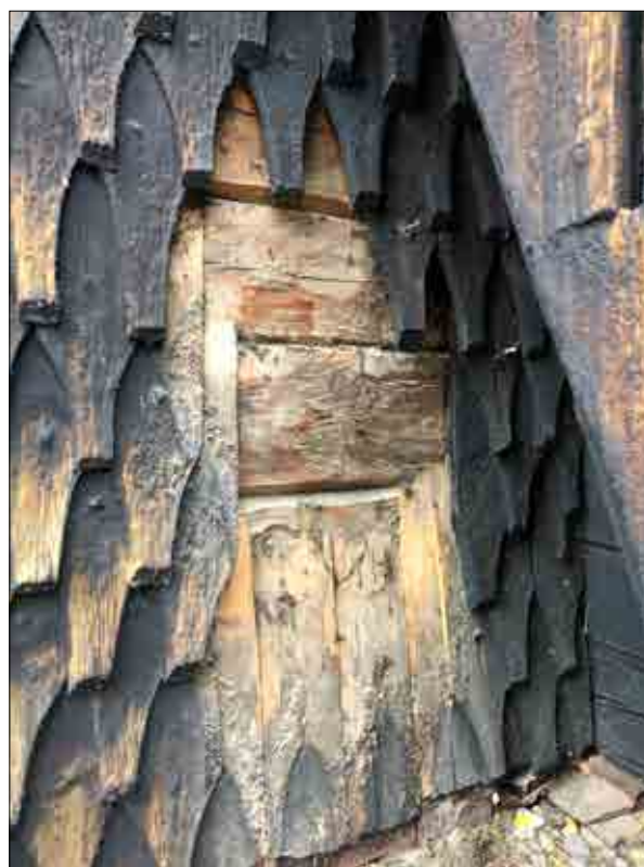
Figur 3.253. Den demonterade ytan visar att spånen är första generationen. Foto Daniel Eriksson.
