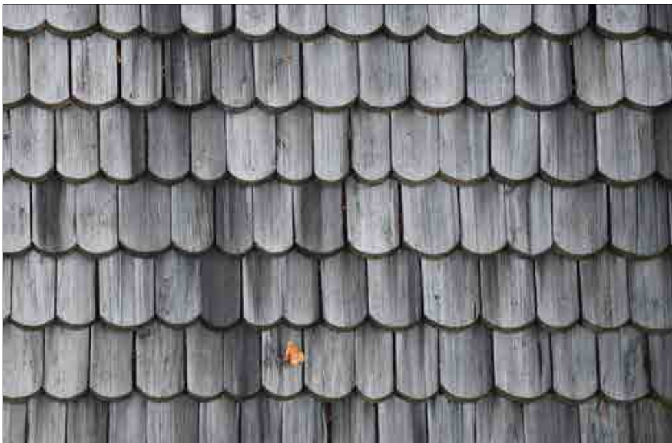
Figur 3.293. Del av spåntäckningen på sakristians västra taksfall. Foto Jennie Björklund.
