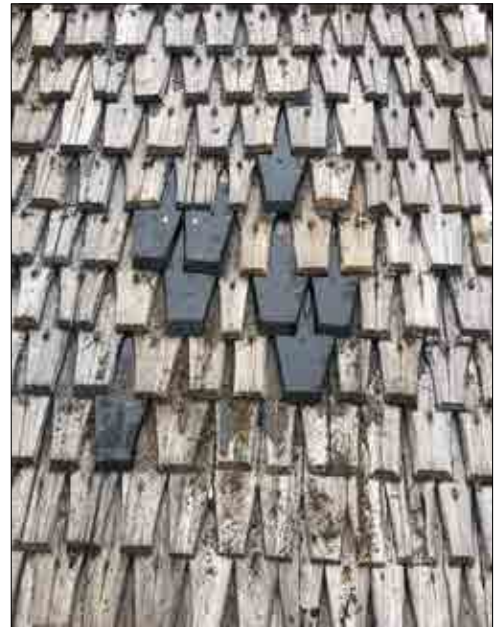
Figur 3.102. Återmonterade spån, nya spån tjärade. Foto Daniel Eriksson.
