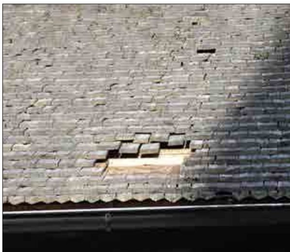
Figur 3.218. Efter demontering av spån på långhusets södra takfall. Foto Jennie Björklund.
