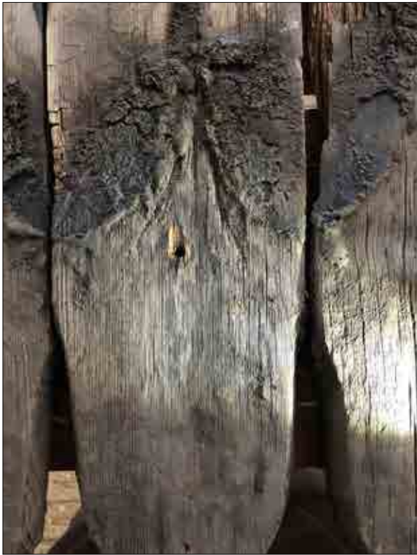
Figur 3.119. Demonterade spån med ritsar för överliggande spån. Foto Daniel Eriksson.
