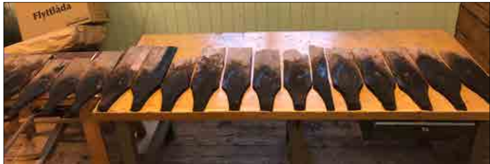
Figur 3.254. Demonterade spån från tornfasaden på verkstadsanalys. Foto Daniel Eriksson.
