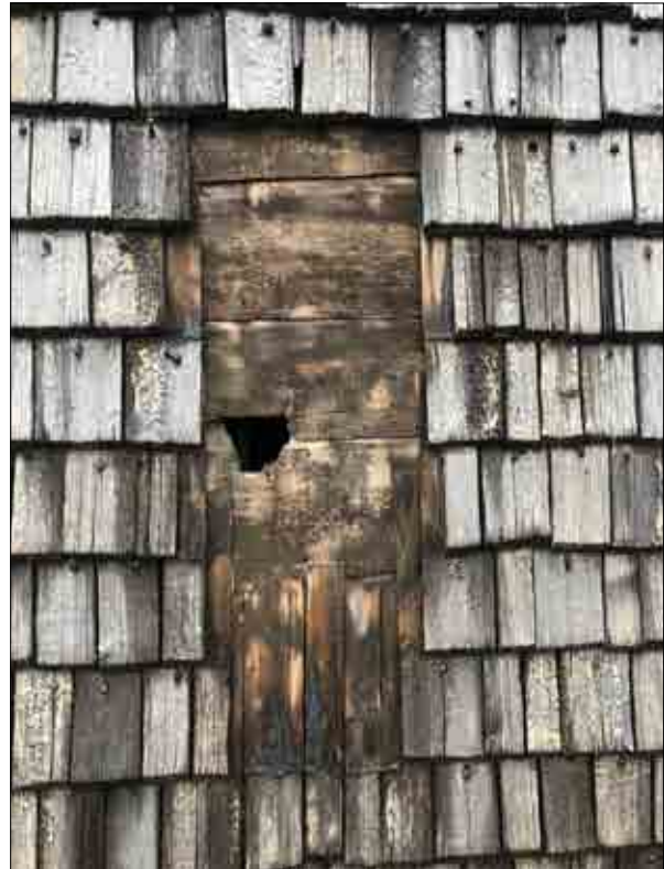
Figur 3.76. Detalj av undertaket med uppbugget ställningsbål. Foto Daniel Eriksson.
