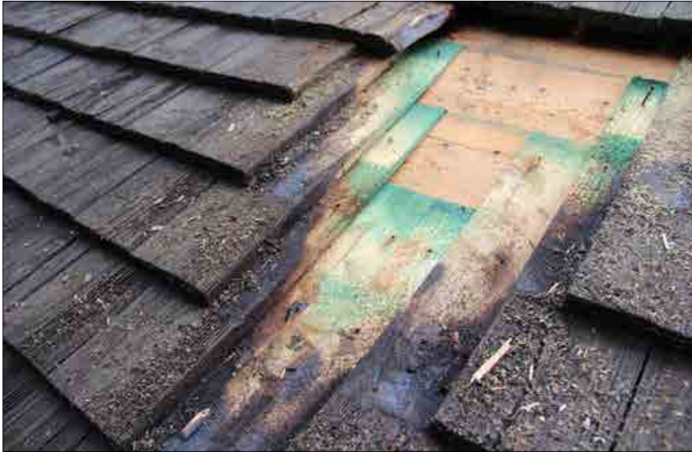
Figur 4.2. Spånen på Kvistbro sakristia är lagda med 4-lagstäckning, det enda exemplet i fallstudien. Foto Lisa Skanser.
