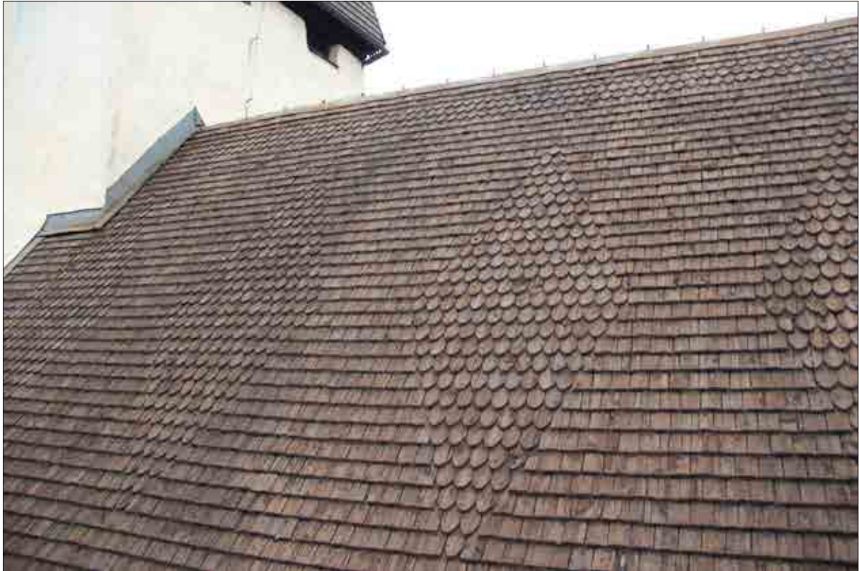
Figur 3.191. Del av långhusets södra takfall före demontering av spån. Notera mönsterläggningen. Foto Liza Skanser.
