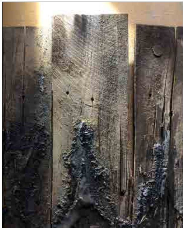
Figur 3.196. I släpljus framträder sågspår på framsidan av spånet. Foto Daniel Eriksson.
