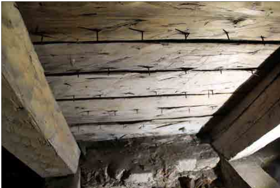
Figur 3.132. Insidan av undertaket med spikar och huggspår. Foto Sanna Svensson.
