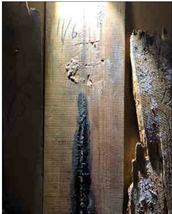
Figur 3.268. Spån med maskinhyvlad framsida. Foto Daniel Eriksson.
