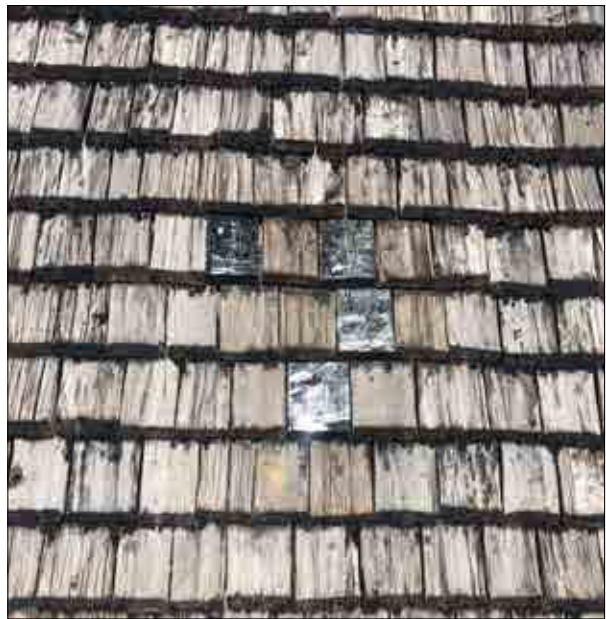
Figur 3.91. Återmonterade spån på långhusets södra takfall. De nya spånen ströks med tjära. Foto Daniel Eriksson.
