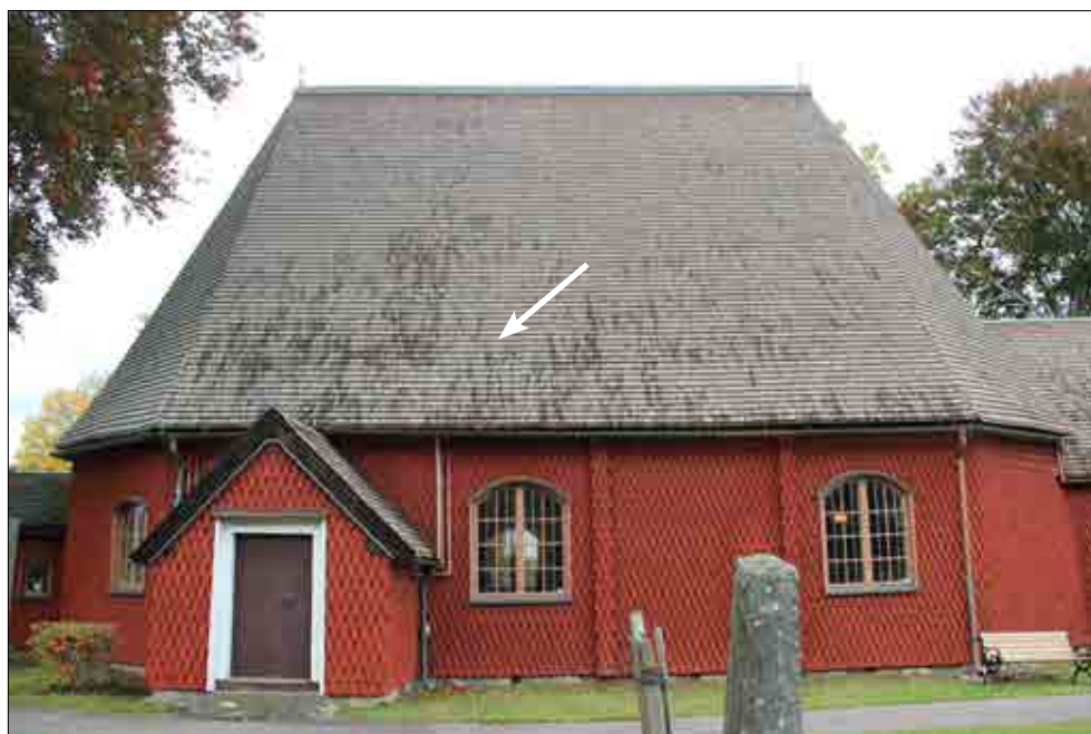
Figur 3.30. Södra takfallet med ersättningspån monterade, markerade med pil. Foto Lisa Skanser.
