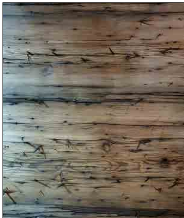
Figur 3.219. Undertaket på långhusets södra sida dateras till 1340-tal. Här syns spåren från många spikgenerationer. Foto Lisa Skanser.
