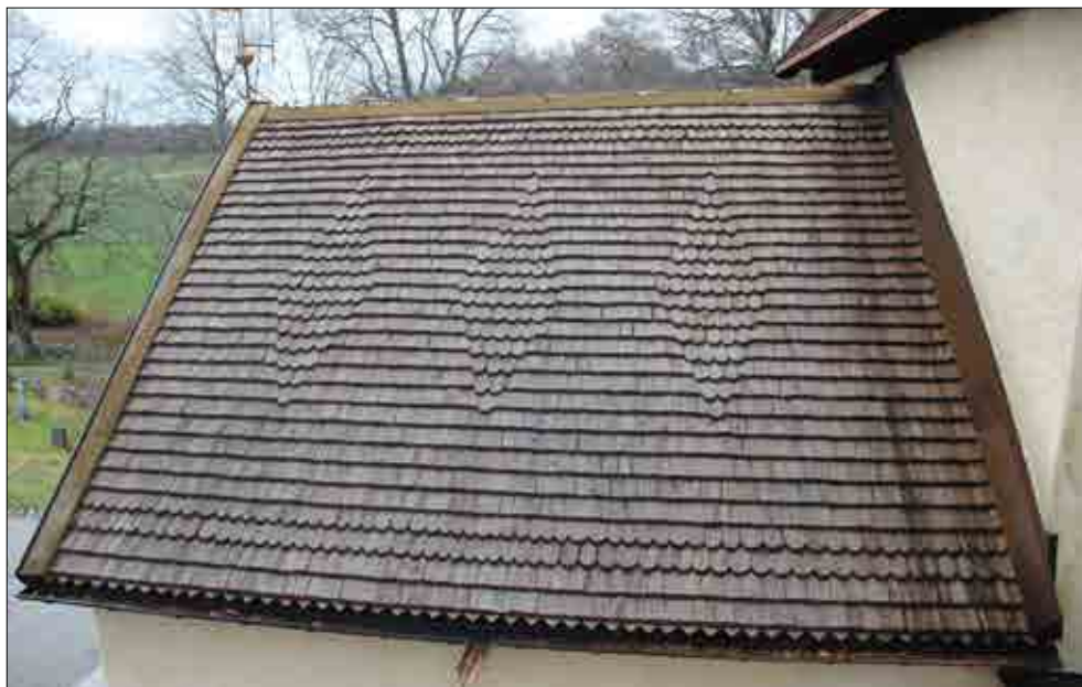
Figur 3.199. Vapenbusets östra takfall före demontering av spån. Foto Lisa Skanser.
