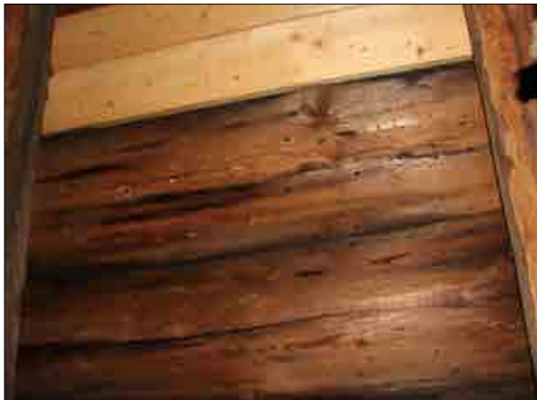
Figur 3.180. Både äldre och yngre brädor i underlagstaket. Foto Lisa Skanser.
