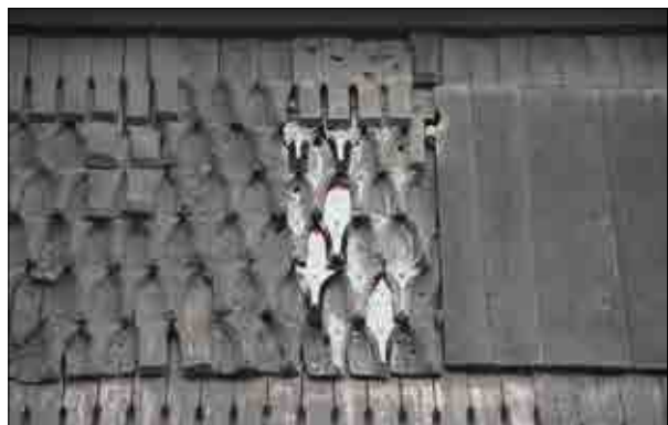
Figur 3.239. Återmonterade spån varav fem nytillverkade. Nya spån tjärades. Foto Lisa Skanser.
