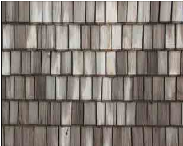
Figur 3.33. Del av långhusets södra takfall före demontering. Foto Lisa Skanser.
