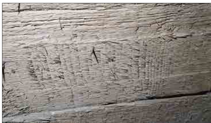
Figur 3.227. Smala tunna spetsar på spånspik i ramsågat virke. Foto Lisa Skanser.
