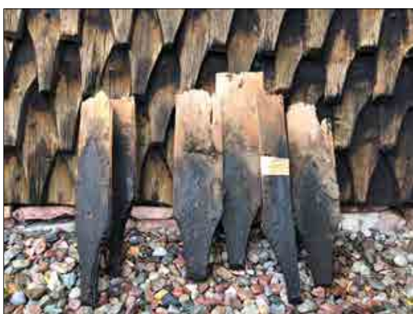
Figur 3.250. Undersökningsytan är skyddad under en trappa och därmed relativt opåverkad av väder och vind. Det ger en chans att studera relativt opåverkade spån. Foto Daniel Eriksson.
