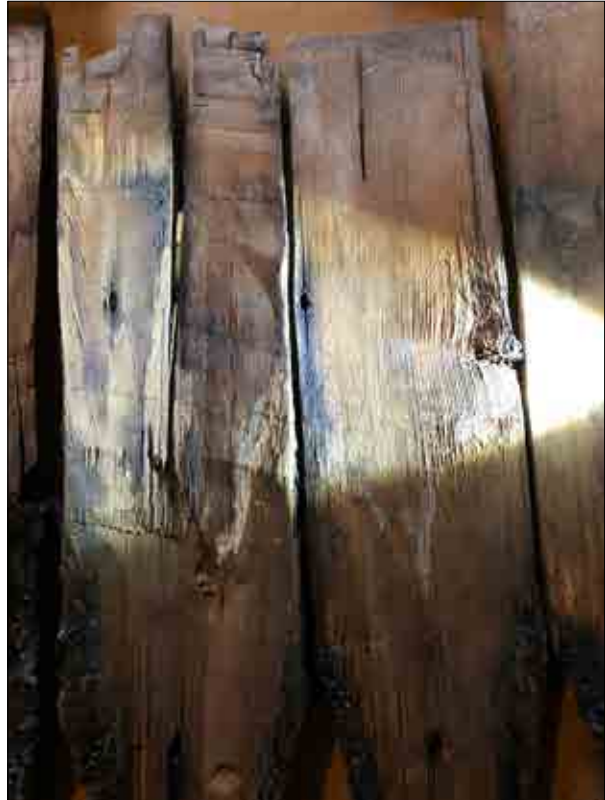
Figur 3.174. Huggspåren visar att spånet huggits av en höger- och en vänsterhänt person. Foto Daniel Eriksson.
