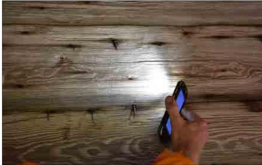
Figur 3.5. Underlagstaket från vinden med verktygsspår och spikar. Foto Jennie Björklund.
