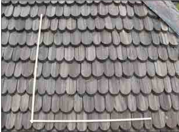
Figur 3.178. Spånnya på korsarmens övre östra takfall, före uppmätning av spån. Foto Lisa Skanser.
