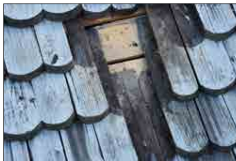
Figur 3.295. Undertaket är modernt och glest lagt. Foto Jennie Björklund.
