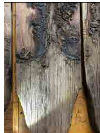
Figur 2.12. I släpljus i verkstaden framträder verktygsspår och ytbehandling tydligare än i dagsljus. Foto Daniel Eriksson.
