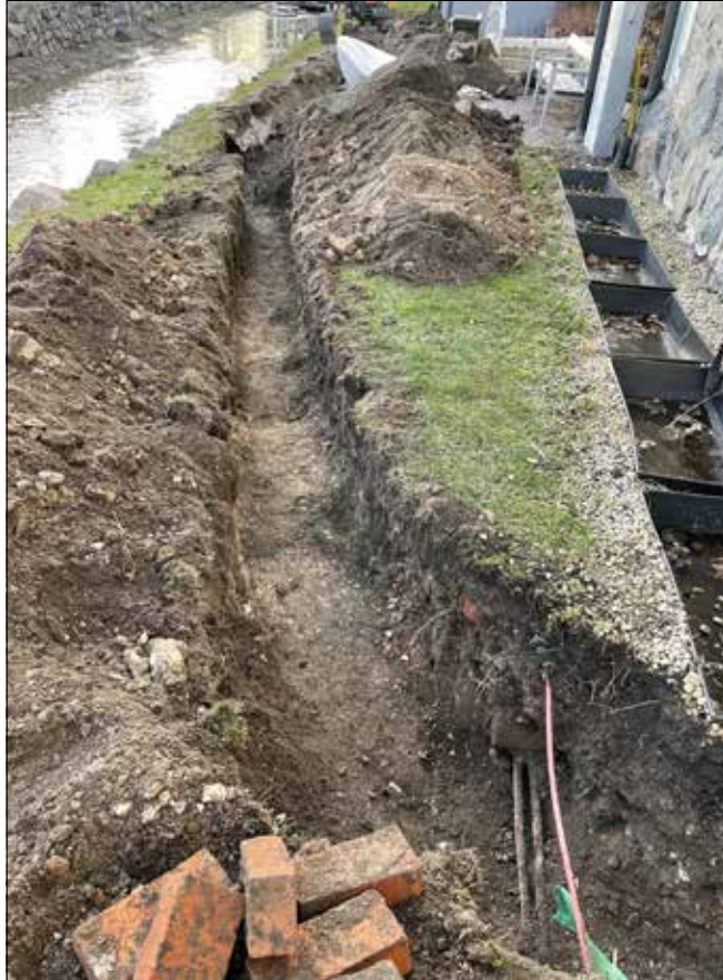
Figur 7. Schaktet från nordöst. Lager 1 syns i botten.
