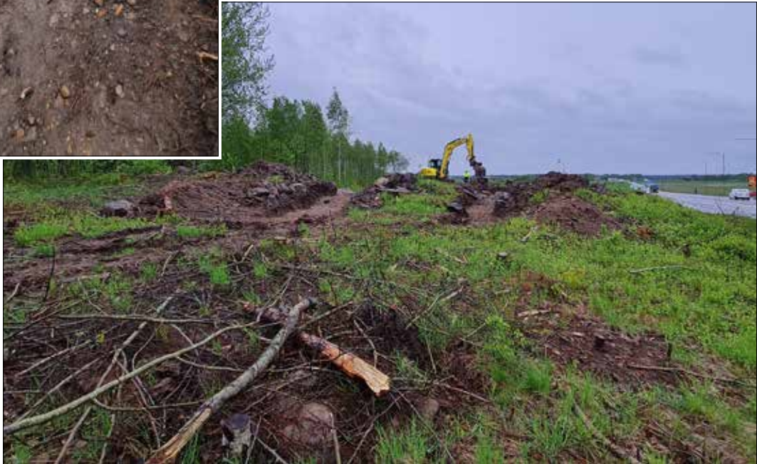
Figur 7. Flera schakt grävdes genom det stora röset L2021:276 för att få fram de anläggningar som dolde sig under det, samtidigt som rösets uppbyggnad kunde dokumenteras. Foto från söder.
