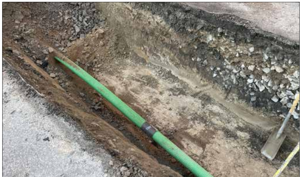
Figur 6. Södra delen av schaktet från nordväst.
