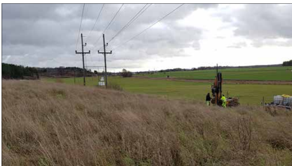
Figur 4. Borrning vid punkt 1C1072 precis nedanför impedimentet där L1984:7168 och L2020:5670 ligger. Transport till borrhunkten skedde runt impedimentet via åkermark. I horisonten skimtar västra utkanten av Nyköping. Foto från nordväst.
