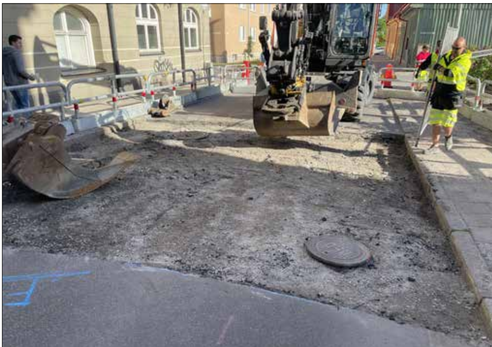
Figur 4. Undersökningsområdet från söder efter att asfalten skurits, men innan schaktningen började.
