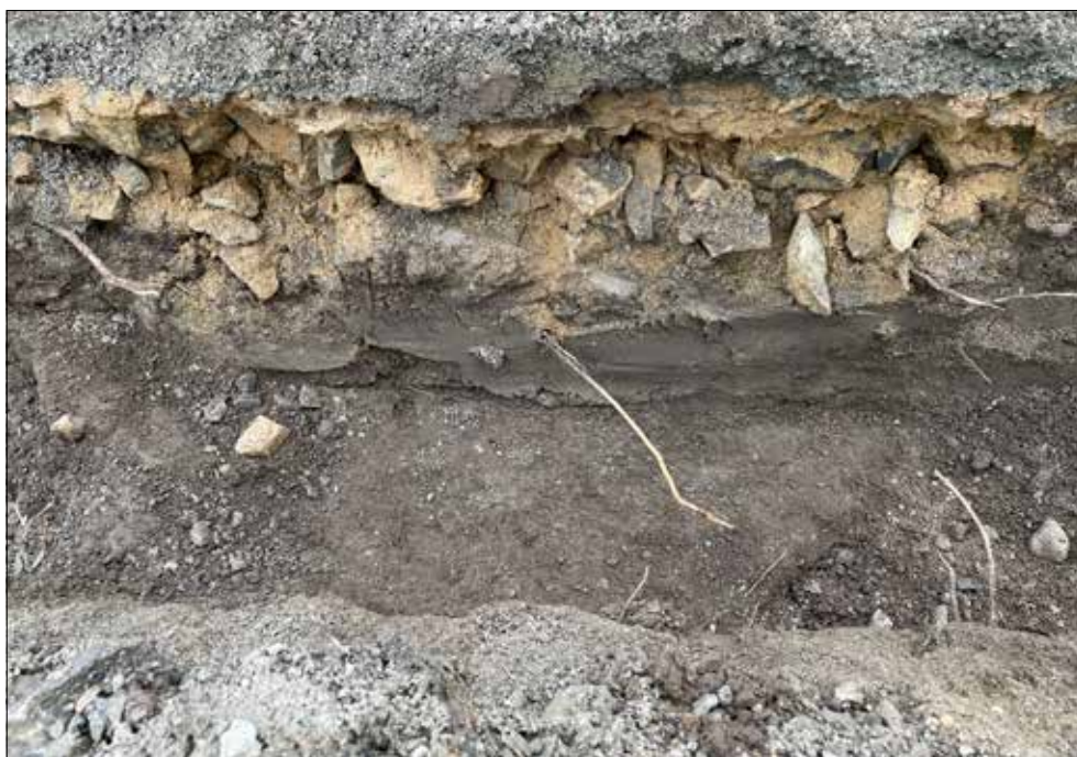
Figur 18. Lager 1028 syns under bärlager. Foto från söder.
