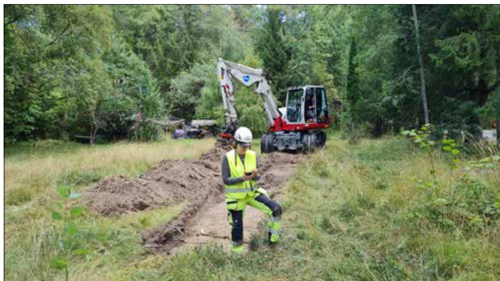
Figur 9. Dokumentation av schakt 8 inom objekt 18. Foto från väster.
