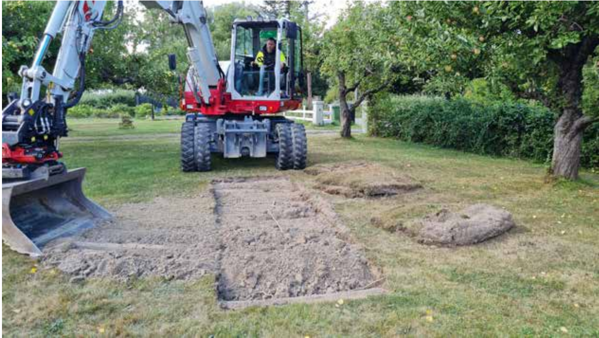
Figur 3. Igenläggning av schakt 4 inom objekt 23. Foto från nordöst.
