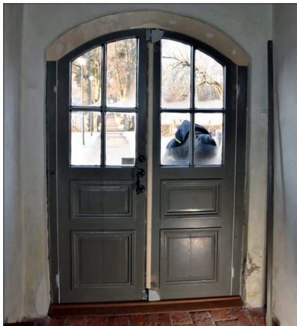
Figur 41. Dörren sedd inifrån. Målning och återmontering av dörrlist återstår.
