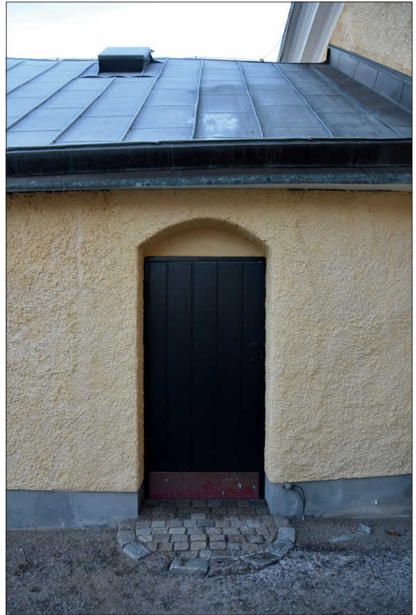
Figur 50. Ny utrymningsväg i sakristian.
