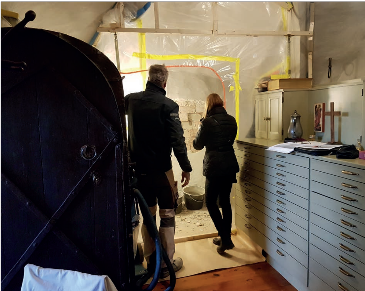
Figur 8. Antikvarie Christina Andersson på plats för att inspektera spår av igenputsad dörröppning i sakristian. Murare Tero visar. Foto: Fredrik Lindblom.
