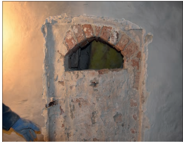
Figur 11. Vägg i sakristian, tidigare öppning har påträffats.
