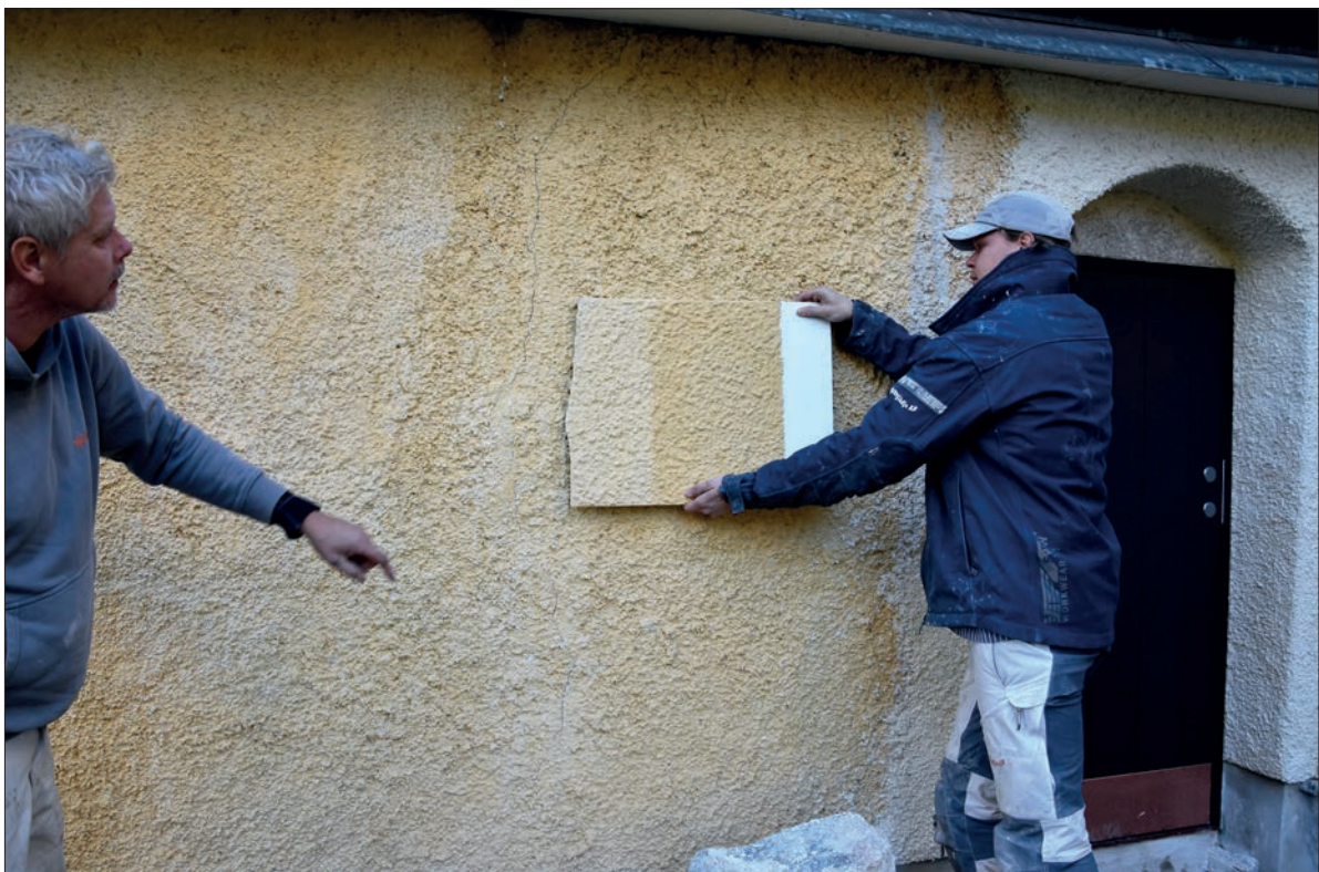
Figur 32. Hösten 2020, väggen är spritputsad och färgprover framtagna. På bilden Tero med son. Även dörren har kommit på plats och målats med två strykningar.
