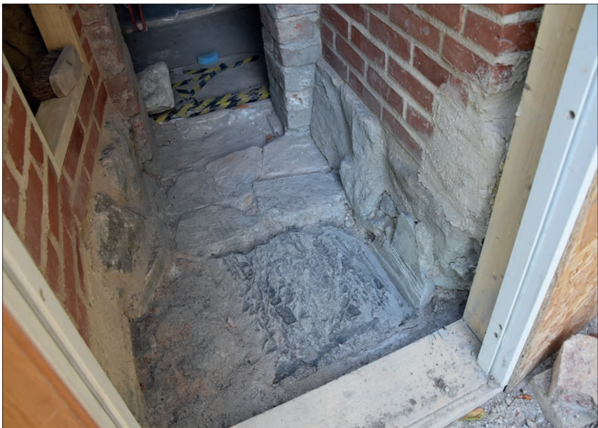
Figur 24. Detalj av golvet i passagen. En av de större stenarna har kapats för planare yta.
