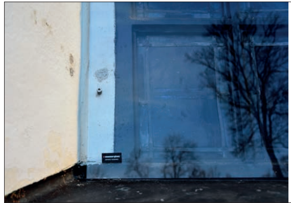
Figur 47. Detalj av infästning med skruv.
