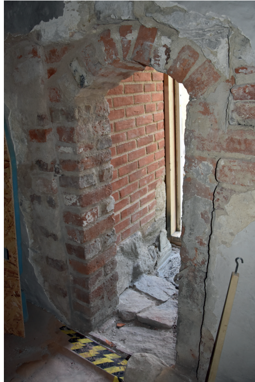
Figur 26. Besök i augusti 2020. Omsättning av befintligt tegel och nytt tegel på plats.
