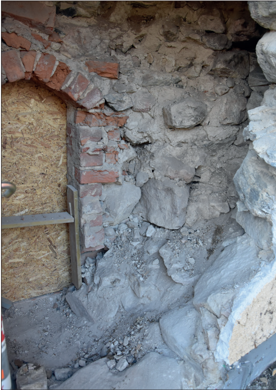
Figur 19. Utrymmet mellan inre och yttre mur. Efter att lösa stenar plockats ner, sommaren 2020.
