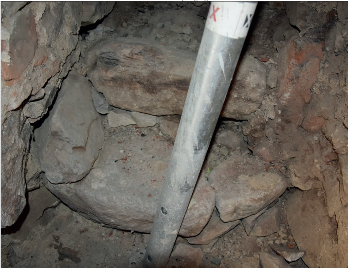
Figur 21. Detalj av den påträffade trappan upp till sakristians vind, belägen mellan yttre och inre mur. Augusti 2020.
