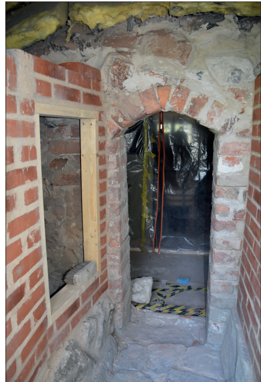
Figur 23. Befintlig stentrappa har sparats och en liten dörr är tänkt att placeras i den nya tegelmuren för att kunna nå sakristians vind.
