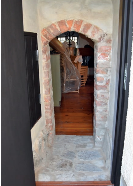
Figur 30. Passagen sedd utifrån och in. Vid besök i september 2020. Dörrarna är på plats och passagens insida putsad.
