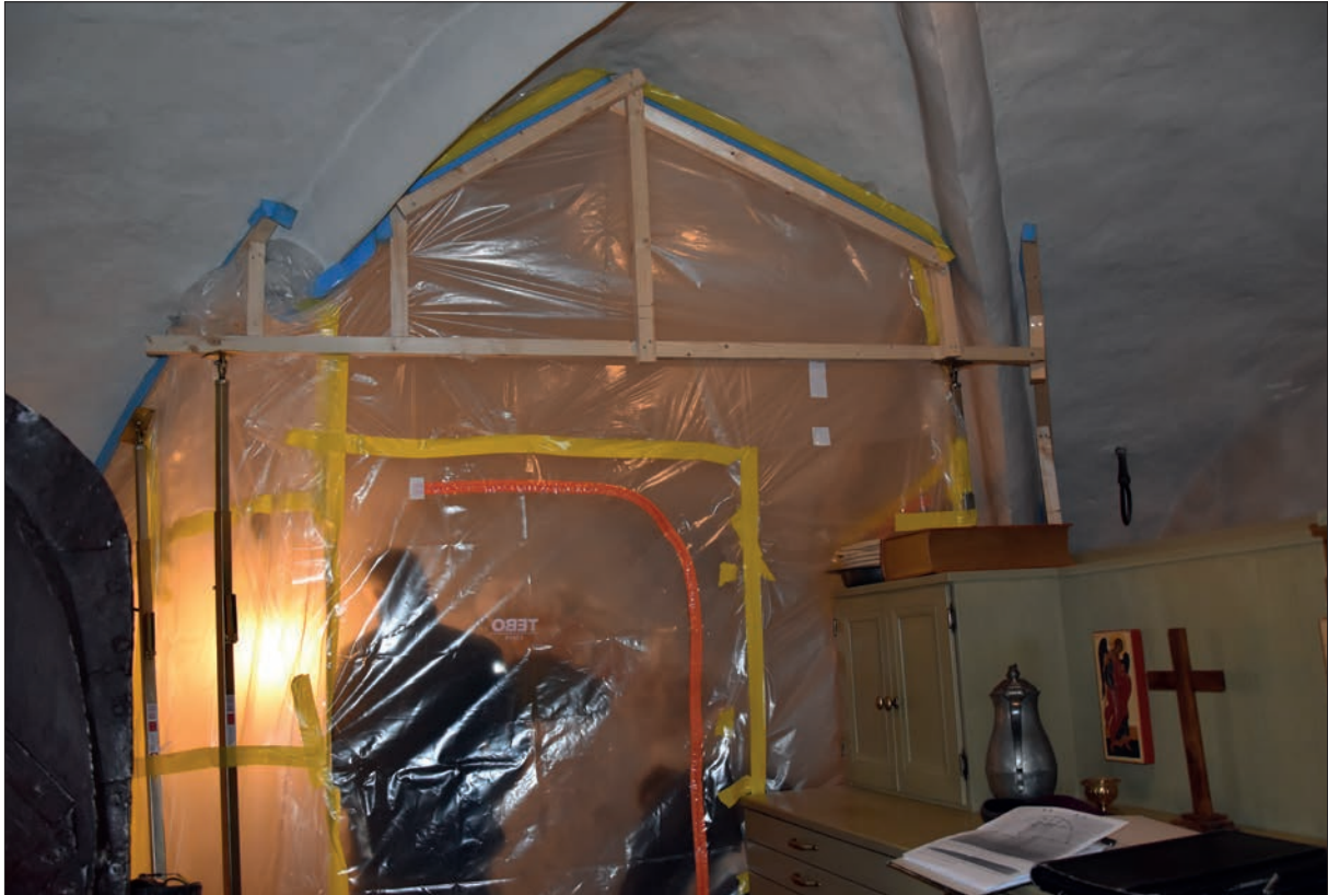
Figur 9. Sakristian vid startmöte i februari 2020. Muraren Tero står innanför uppsatt plasthölje och har påträffat en igenmurad vägg av tegel.
