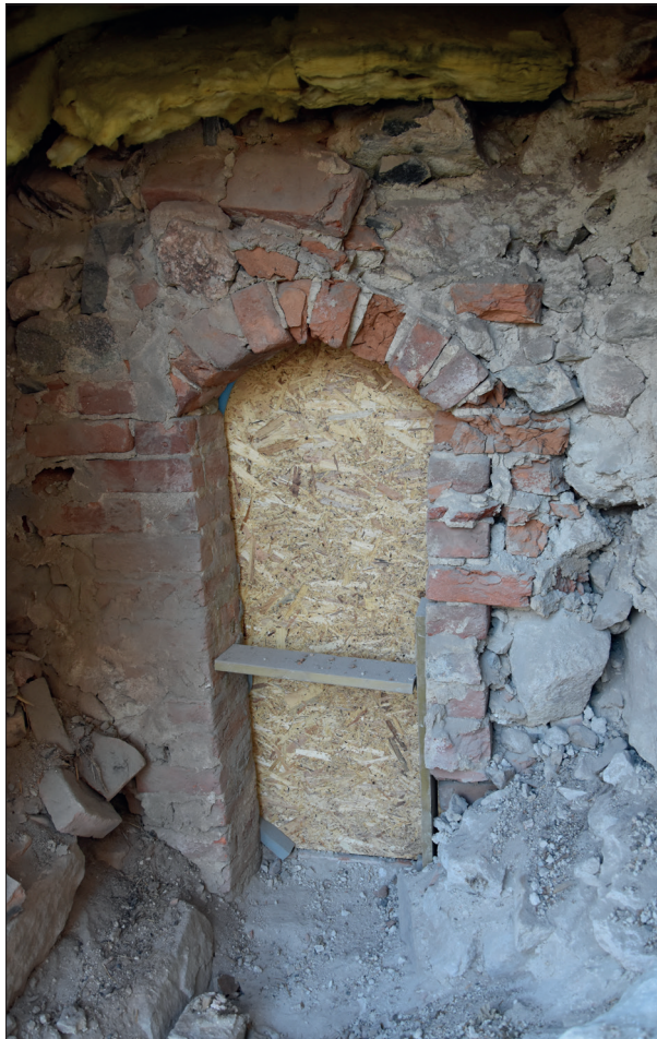
Figur 15. Detalj av tidigare muröppning sedd från utsidan.
