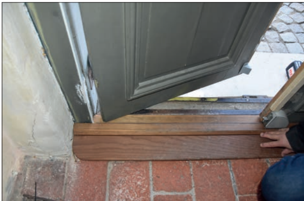
Figur 39. Detalj av ny sockel som monteras med spårskruv.
