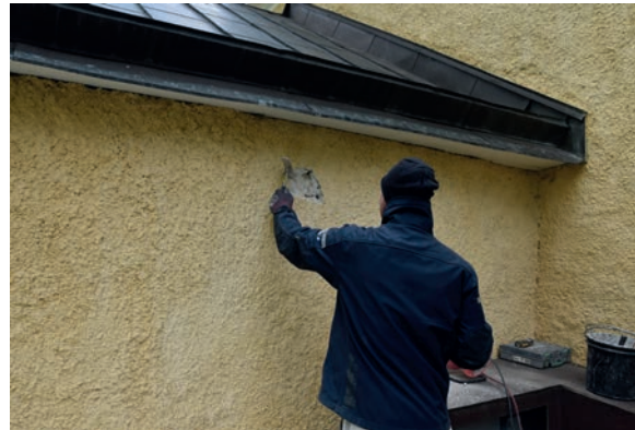
Figur 4. Tero har påbörjat arbetet.
