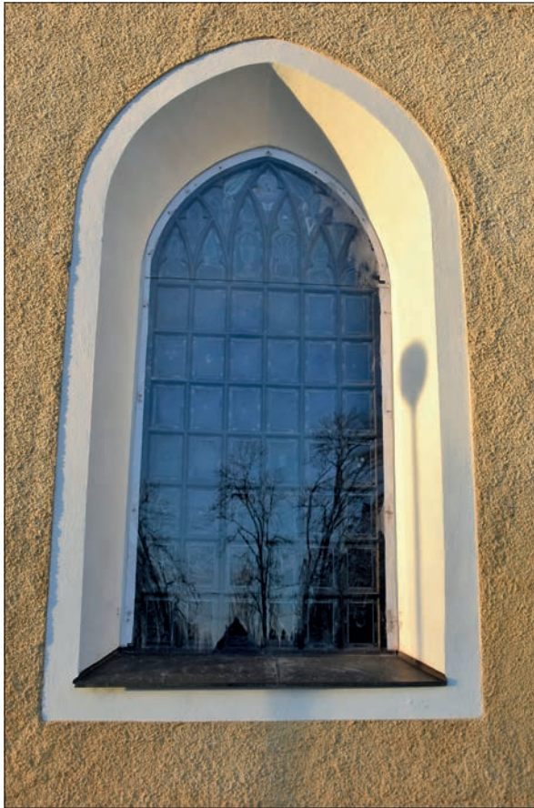
Figur 49. Skyddsglas monterat.
