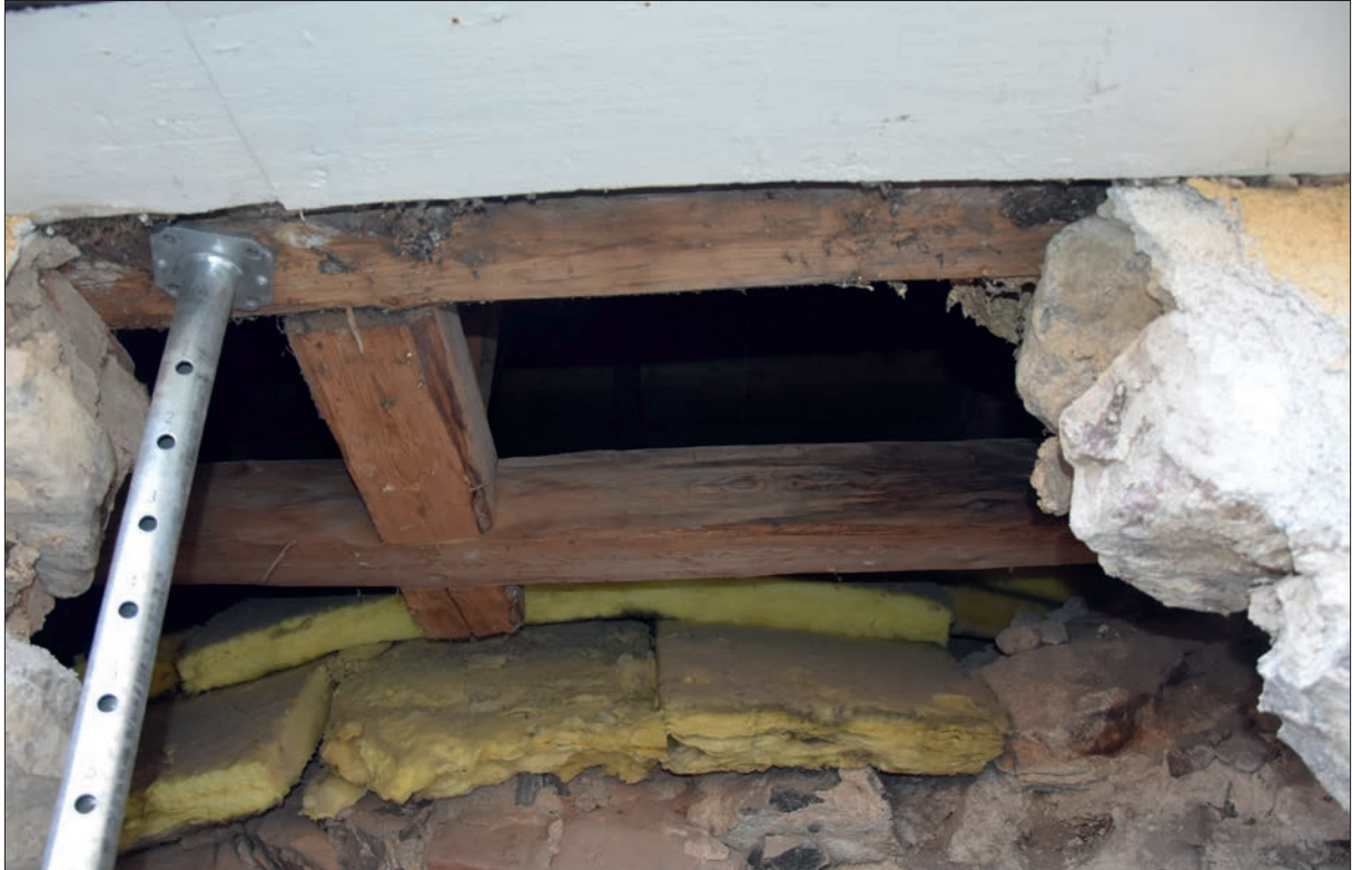
Figur 17. Utblick uppåt, vindsutrymme ovanför sakeristian som tidigare nåddes via stentrappa.
