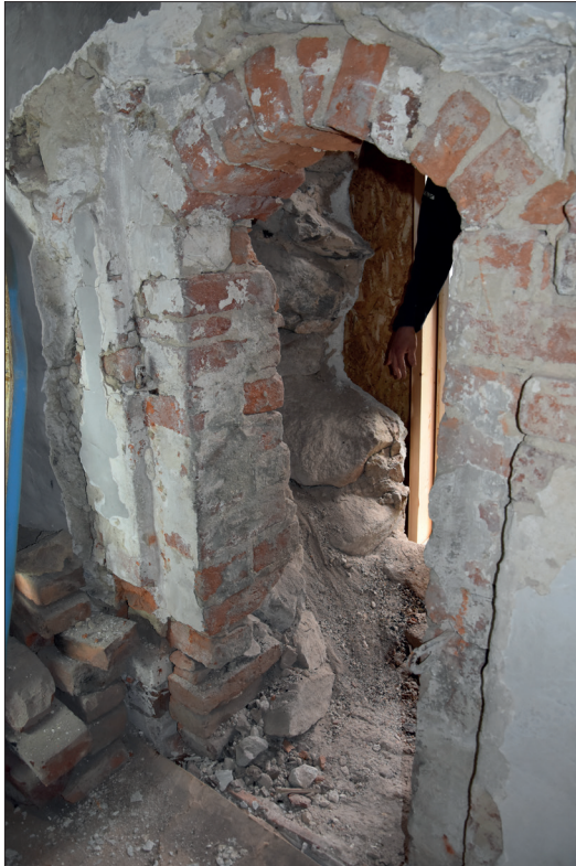
Figur 25. Muröppning sedd från sakristian i maj 2020 före omsättning.
