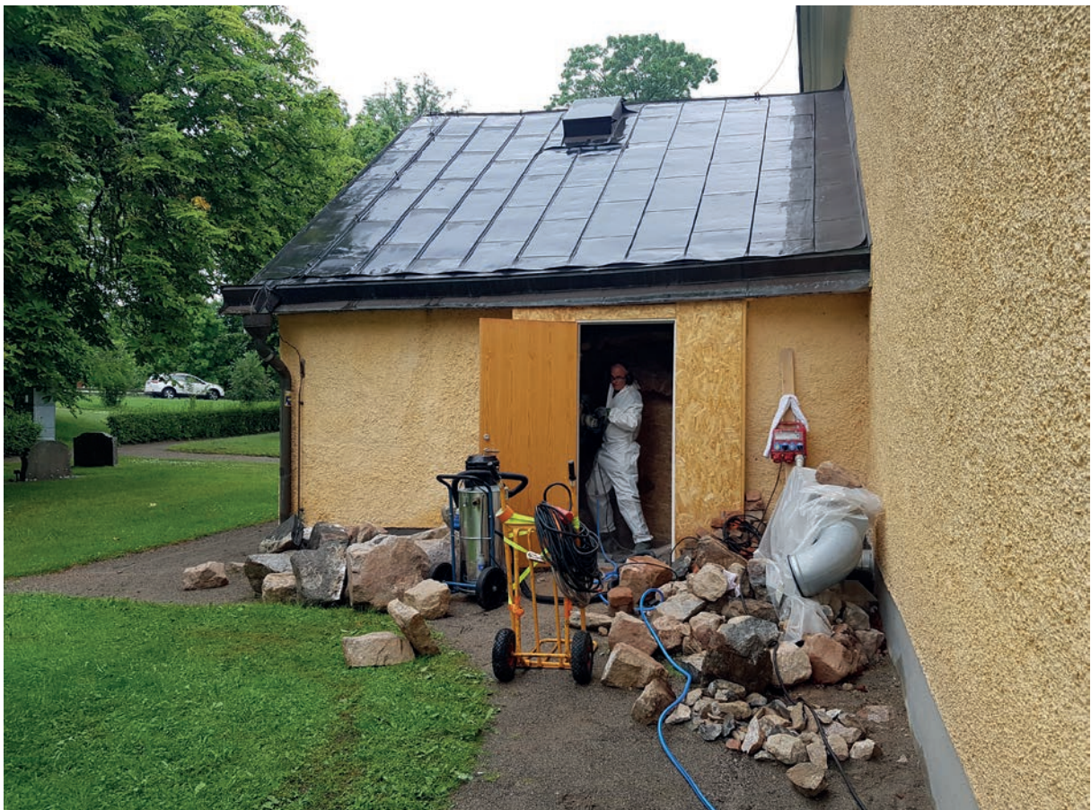
Figur 18. Gråstensmurens yttre kant jämnas till av Anders Haggström från S.I.S Industrisanering.
