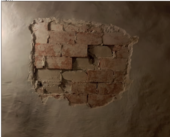
Figur 10. Vägg i sakristian, bakom putsen påträffas tunntegel och där under tegel.
