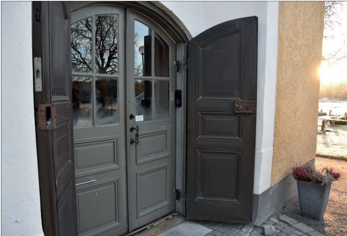
Figur 37. Slutbesiktning i december 2022. Västerportens inre dörrpar öppnas utåt och kortläsare är monterad.
