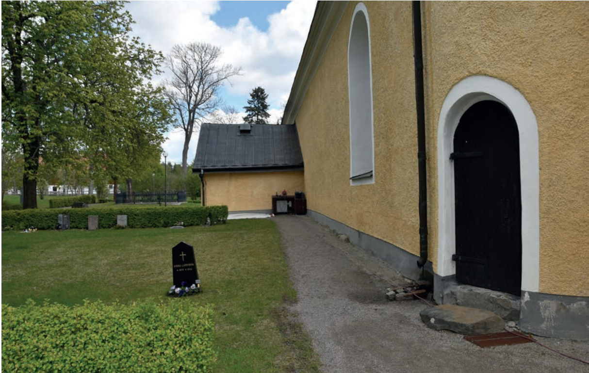
Figur 2. Våren 2019. Det har blivit dags att ta reda på om det finns en äldre dörröppning till sakristian bakom putsen.
