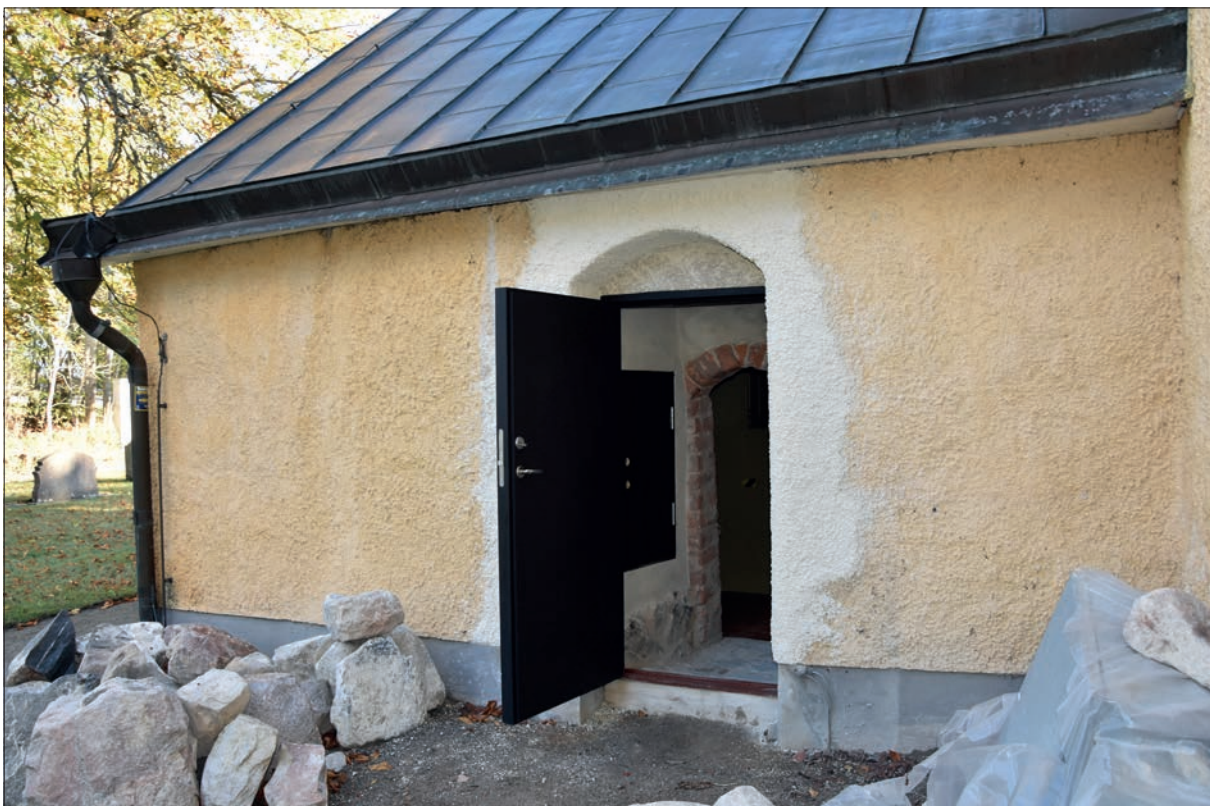
Figur 34. Arbetet avslutas tillfälligt i september 2020. Kvar är anfärgning av fasader och slutstrykning av dörrar samt markbeläggning utanför dörren.
