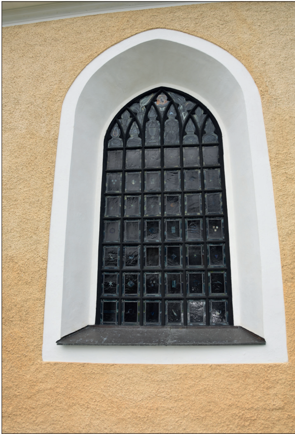
Figur 45. Korfönstret före montering av skyddsglas..
