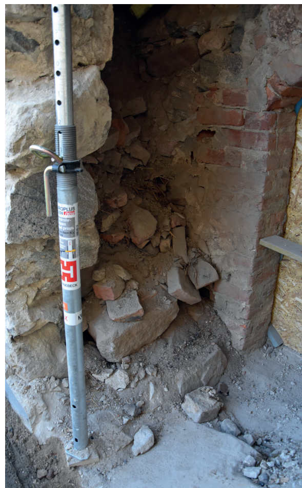
Figur 16. Mellan yttre och inre muren finns rester av en stentrappa upp till vinden.
