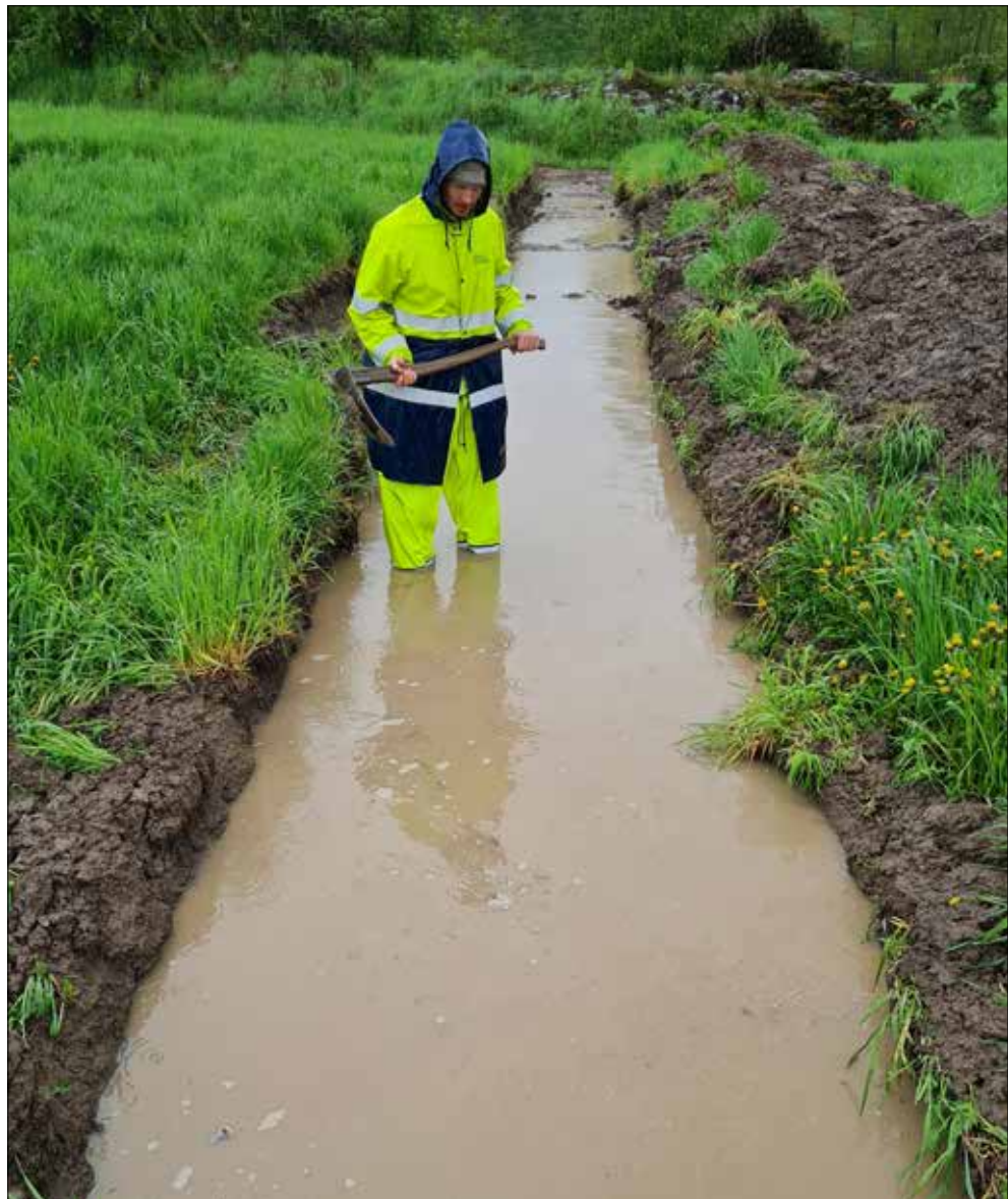
Figur 3. Marcus Asserstam i ett av de vattenfyllda schakten den 26 maj 2021.
