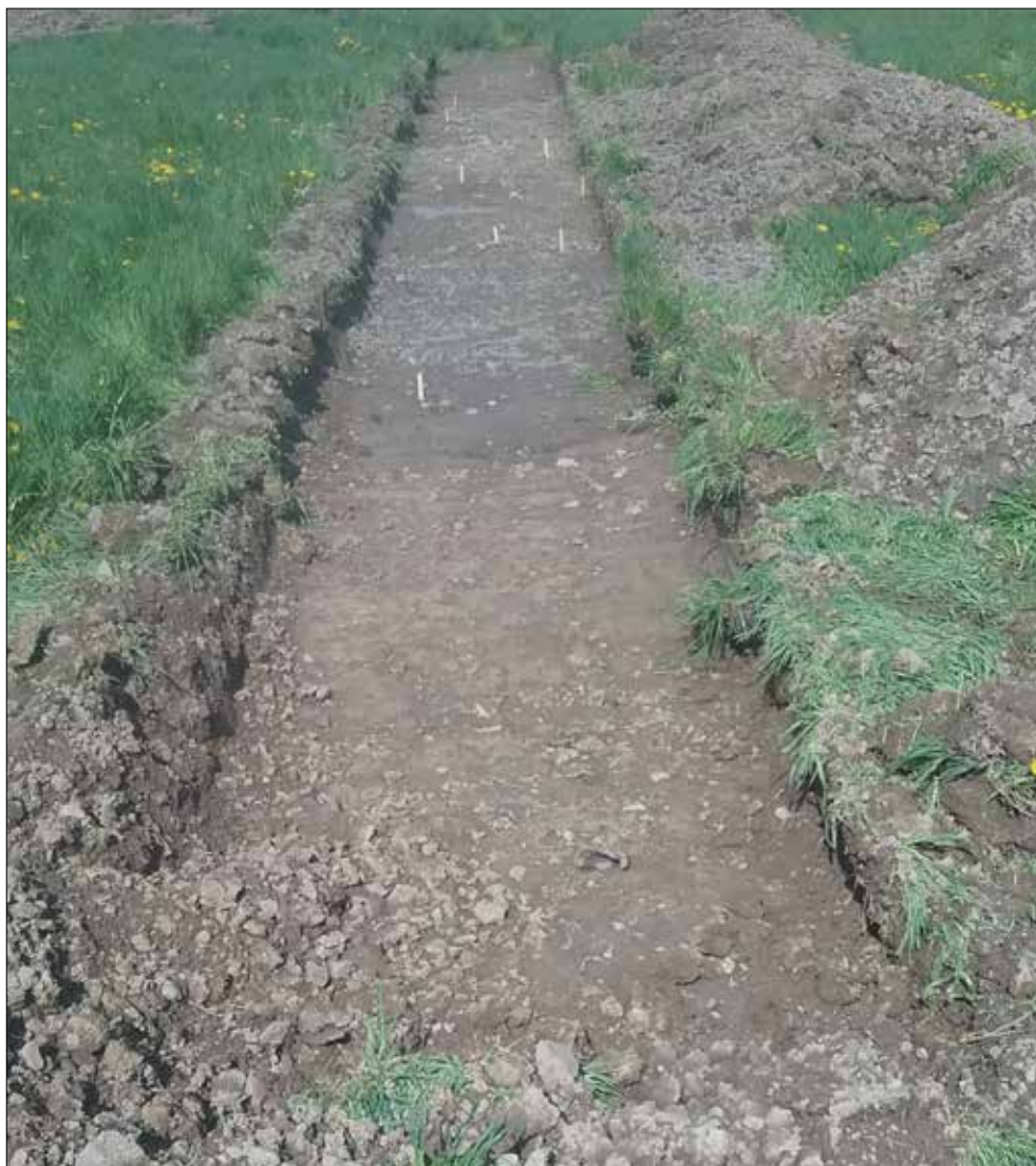
Figur 7. Schakt 455. Foto från söder.
