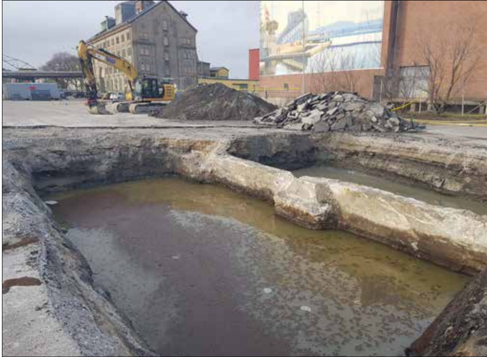
Figur 19. Översikt från sydöst över ett vattenfyllt schakt B. Foto Marcus Asserstam.
