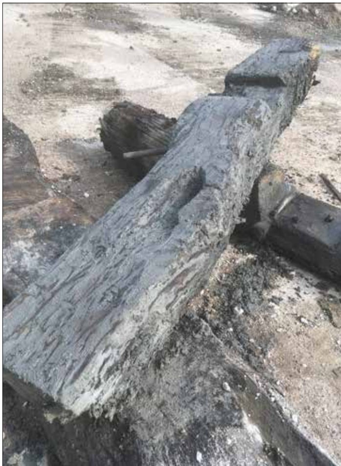
Figur 18. Stock 802, liggandes ovanpå 800 närmast i bild och 801 längre bort. Notera uthuggningarna samt pluggen som sticker ut på stockens baksida.
