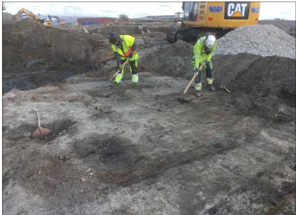
Figur 44. Schaktning i östra delen av schakt A. Foto från söder.
