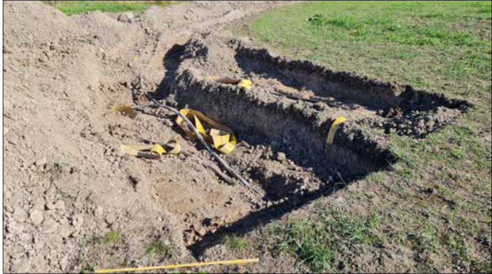
Figur 5a. Södra delen av schakt S201. Foto från söder.
