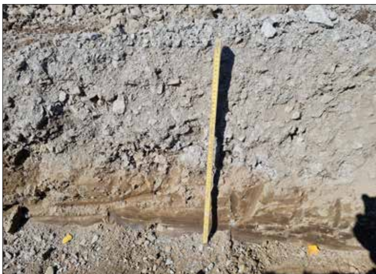
Figur 6. Profil över den störda ytan i undersökningsområdets södra del. Ytan var urschaktad och återfylld med ett cirka 0,3 meter tjockt lager grus och småsten. Foto från sydöst.
