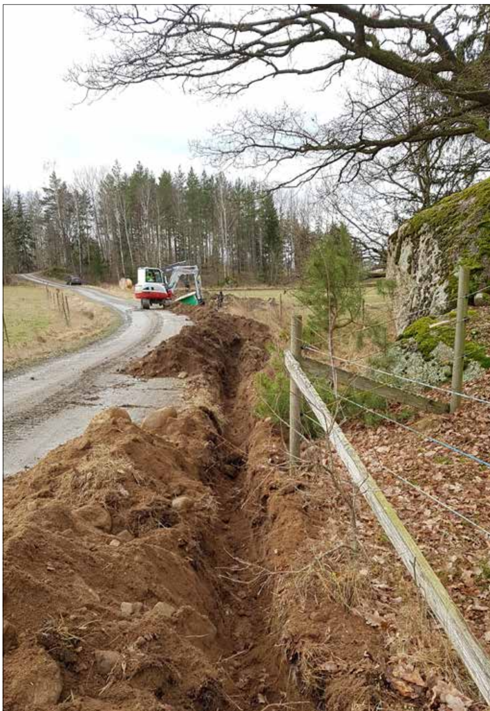
Figur 10. Översikt över schakt i den norra delen av område 1. Foto Karolina Karlsson från norr.
