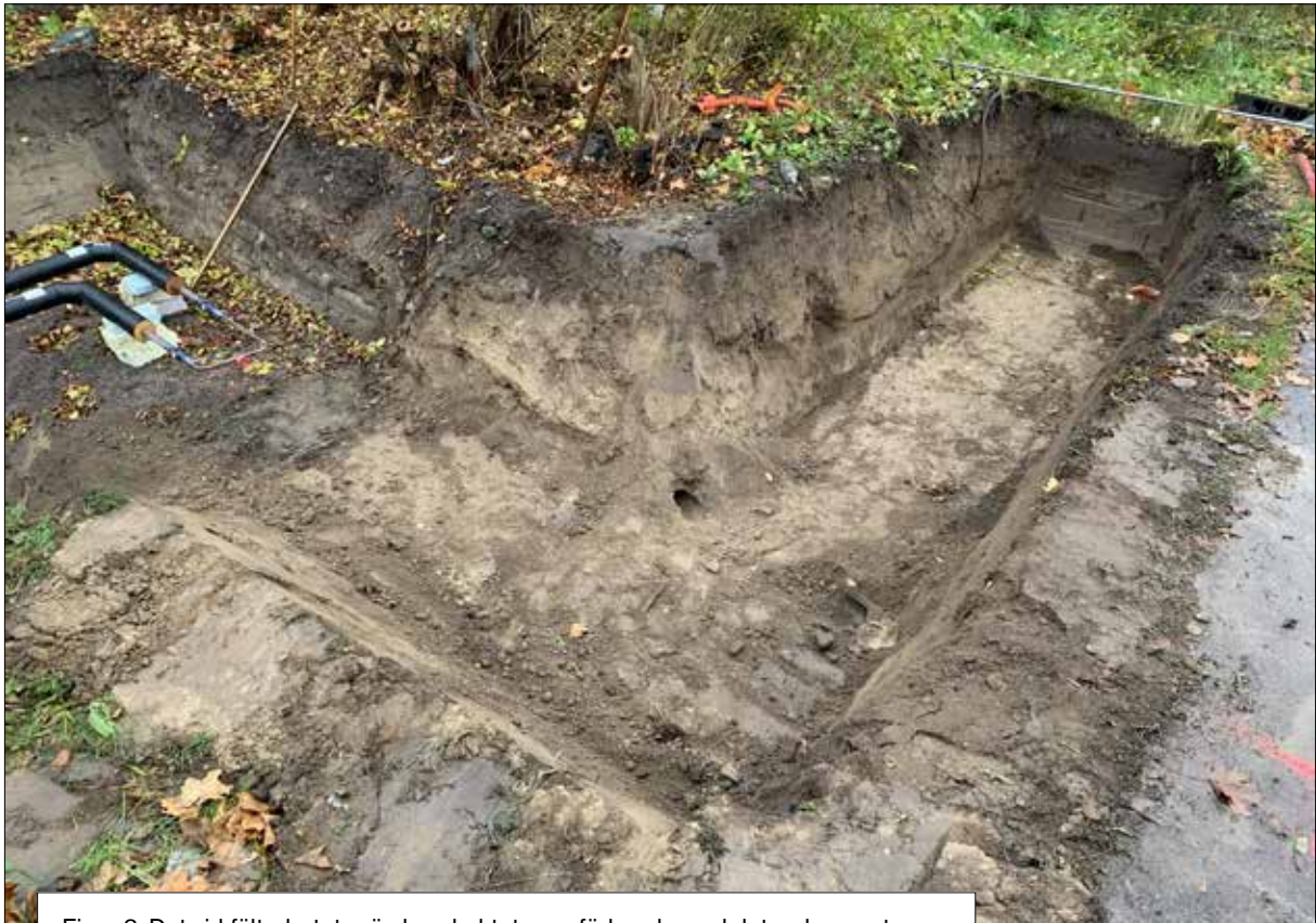
Figur 3. Det vid fältarbetet grävda schaktet som förbands med det redan upptagna. Foto från sydöst.
