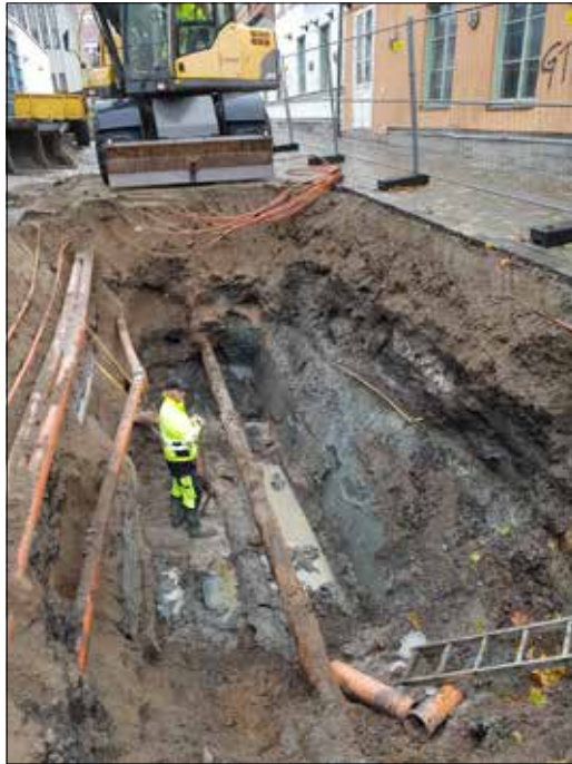
Figur 69. Schakt 18 blev 3,2 meter djupt. I samband med schaktningen gick spåledningarna sönder. Till höger ses kulturlagret. Foto från sydöst.
