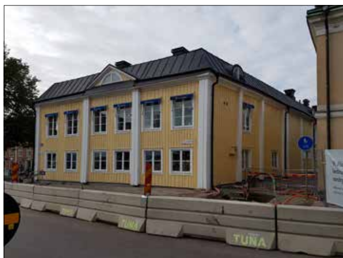
Figur 24. Schakt 7 togs upp vid korsningen Västra Kyrkogatan-Prästgatan. Invid väggen bakom stegen framkom bebyggelselämningar. Foto från nordöst.
