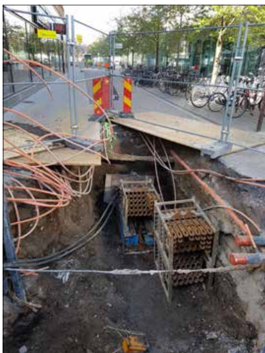
Figur 57. Från schakt 15 som togs upp i korsningen Smedjegatan-Vasagatan styrborrades och relinades ledningar till schakt 14 och vidare till schakt 13 (figur 46 och 49). Här ses delar av utrustningen i form av länkar som användes då ledningarna drogs under marken och vidare till schakt 14 och 13. Foto från öster.
