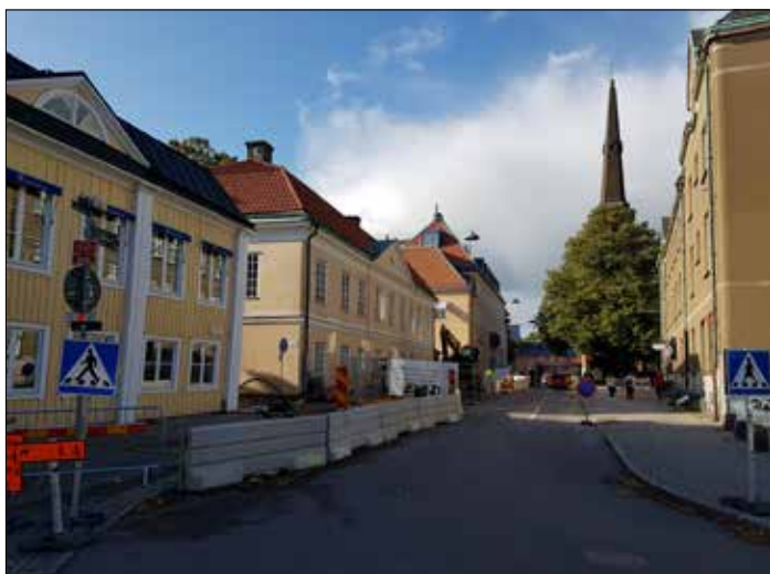
Figur 22. Översikt som visar Västra Kyrkogatan och schakt 6. Foto från söder.
