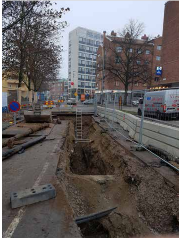
Figur 78. Schakt 24 i Kopparbergsvägen. I den bögra schaktväggen dokumenterades gatubeläggningar och hårdgörningsytor tillhörande Kopparbergsvägens föregångare. Foto från norr.
