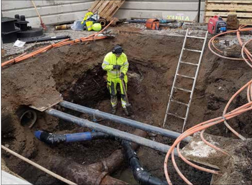
Figur 27. I schakt 9 fanns många ledningar. Schaktet togs upp intill Bondtorget. Foto från nordöst.
