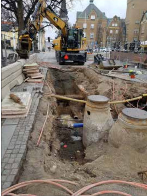
Figur 39. Del av schakt 11. Foto från sydöst.
