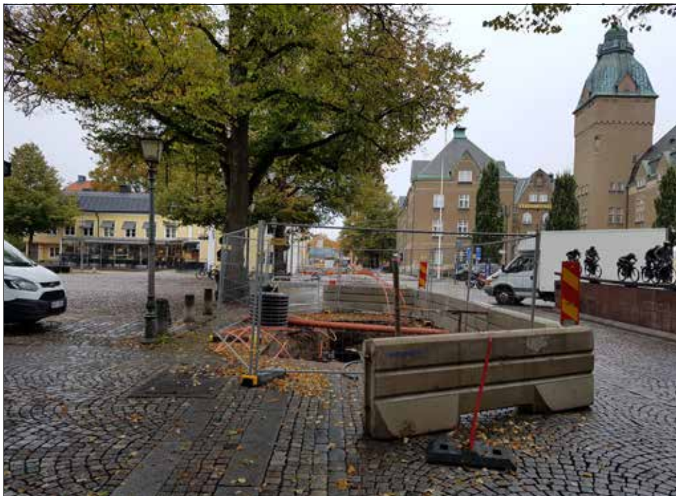
Figur 35. Schakt 10. Foto från sydöst.
