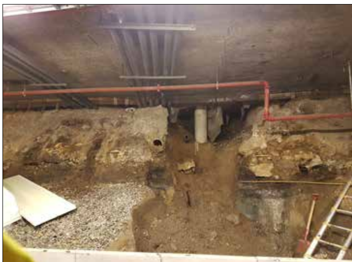
Figur 48. Bakom plåtväggen i Citytunneln i schakt 13 fanns kulturlager och bebyggelse lämningar som daterades till 1200–1600-talet. Kulturlagret var bortgrävt i mitten av bilden där det fanns vattenledningar. Foto från väster.
