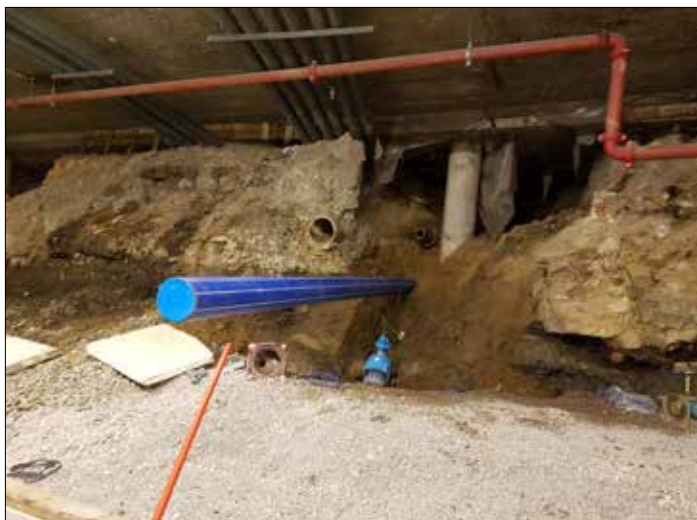
Figur 49. En vattenledning borrades från schakt 15 till schakt 14 och kom fram i schakt 13. Foto från sydöst.
