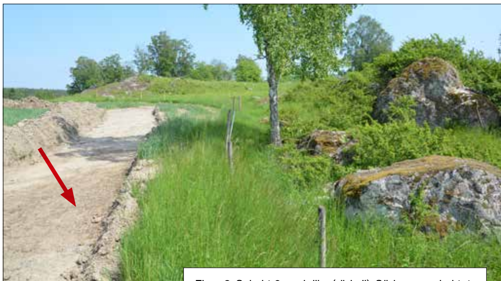
Figur 8. Schakt 6 med dike (röd pil). Söder om schaktet, till höger på bilden, syns ett mycket blockrikt område. Foto från västsydväst.
