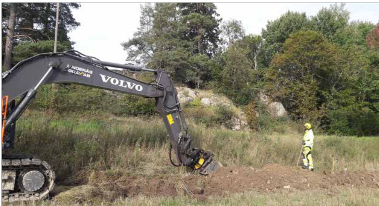
Figur 6. Schaktning pågår i åkermarken öster om grusvägen. I bakgrunden syns den skogklädda höjden på vilken de två gravhögarna ligger. Foto från öster.
