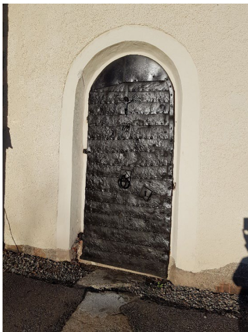
Figur 83. Den plåtklädda dörren behandlad med uppvärmd linolja.
