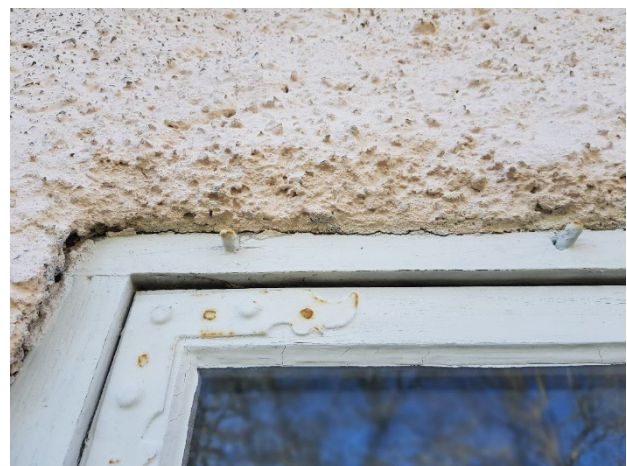
Figur 38. Sakristian, beslag som delvis rostade. Pluggen i överkant bör samman med hål i fönsterluckan.
