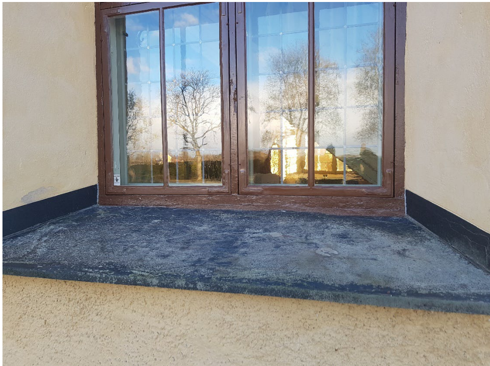
Figur 18. Åtgärdad glipa mellan karm och solbänk.
