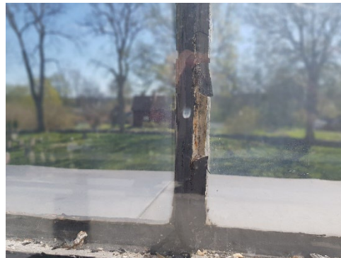
Figur 39. Sakristia tidigare silikonlagning där plugg saknas. Smärre rostangrepp och kittbortfall samt sprickor i kittfals.
