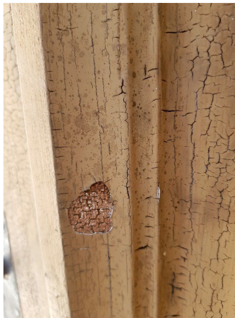
Figur 29. Västporten med omfattande krakelering i färglager och dålig vidhäftning. Uttorkat virke.
