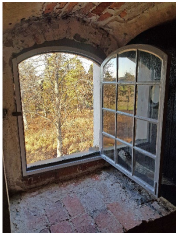
Figur 46. Tornfönster efter åtgärder.
