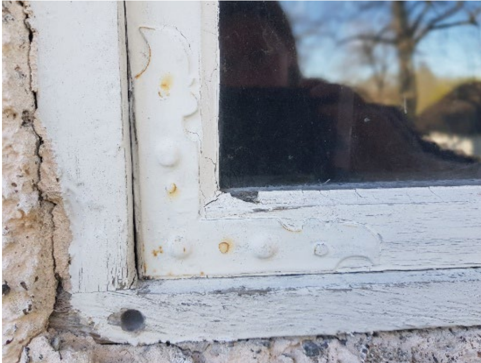
Figur 39. Sakristia tidigare silikonlagning där plugg saknas. Smärre rostangrepp och kittbortfall samt sprickor i kittfals.
