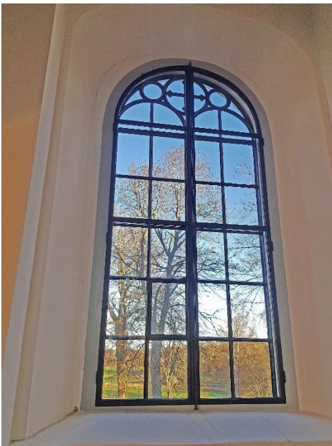
Figur 52. Innerbåge efter åtgärder.
