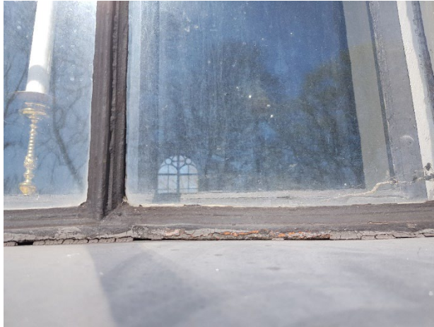
Figur 28. Exempel från södra sidan. Hur ser fog ut mellan karm och solbänk. Inmålad?
