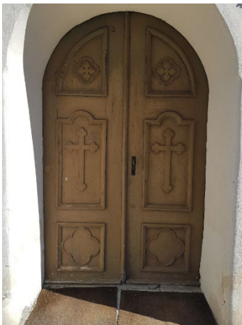
Figur 29. Västporten med omfattande krakelering i färglager och dålig vidhäftning. Uttorkat virke.
