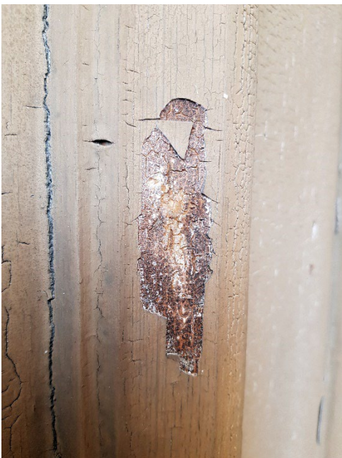
Figur 31. Underliggande färglager västport.
