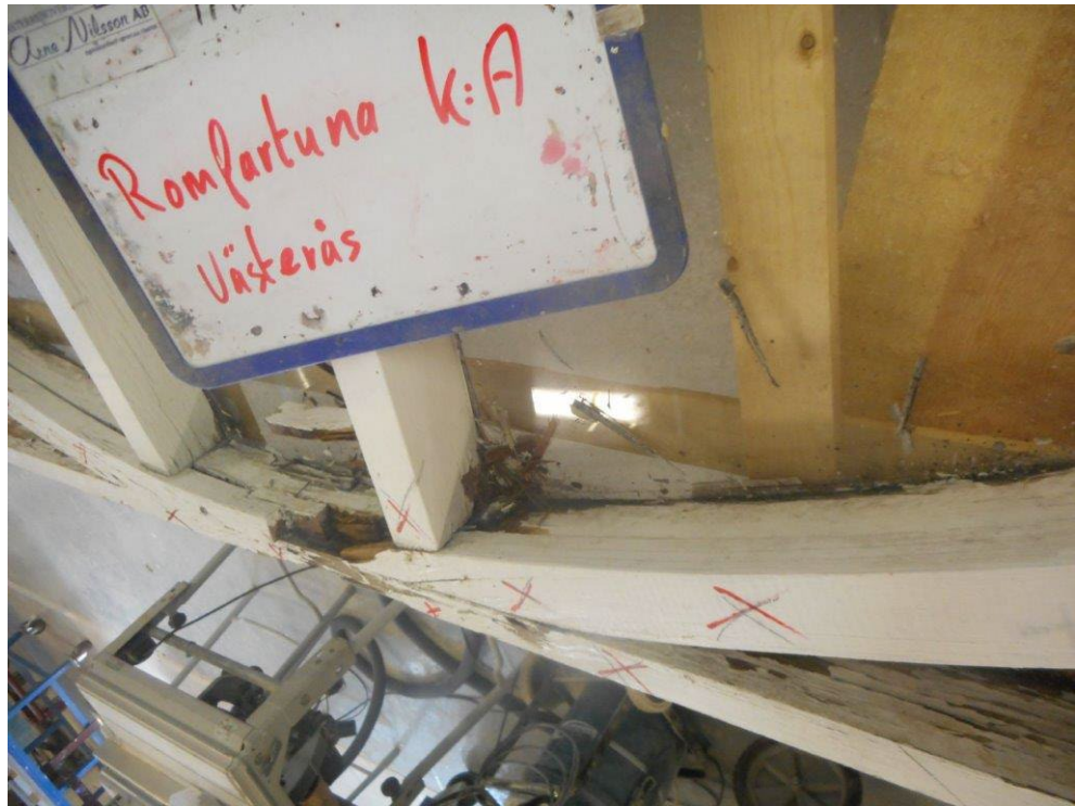
Figur 70. Skador i korfönsterbåge.
