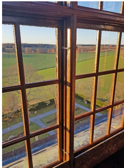
Figur 21. Åtgärdad fönsterbåge samt mörkare fog mot solbänken på sidorna. Figur 22. Ommålad innerbåge i kyrkorummet.
