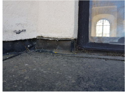
Figur 34. Norra sidan. Fog mellan puts och plåt. Skulle den åtgärdas?
