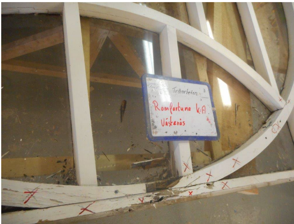
Figur 69. Skador i korfönsterbåge. Svaga partier.
