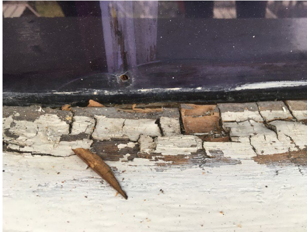
Figur 67. Omfattande rötskador i korfönstrets karmbottenstycke. Figur 68. Omfattande rötskador i korfönstrets karmbottenstycke.
