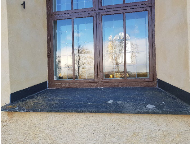
Figur 21. Åtgärdad fönsterbåge samt mörkare fog mot solbänken på sidorna. Figur 22. Ommålad innerbåge i kyrkorummet.
