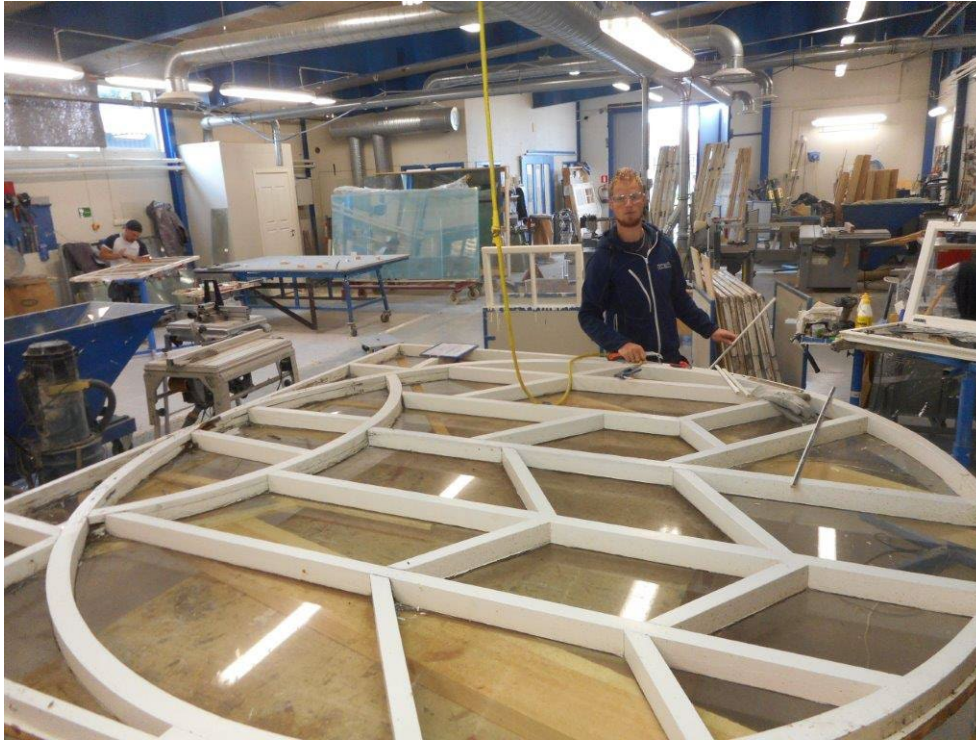
Figur 72. Reparation av övre del av korffönster.
