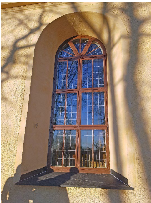
Figur 23. Färdigrenoverat fönster. Figur 24. Västra mittposten i lanterninen är utbytt.
