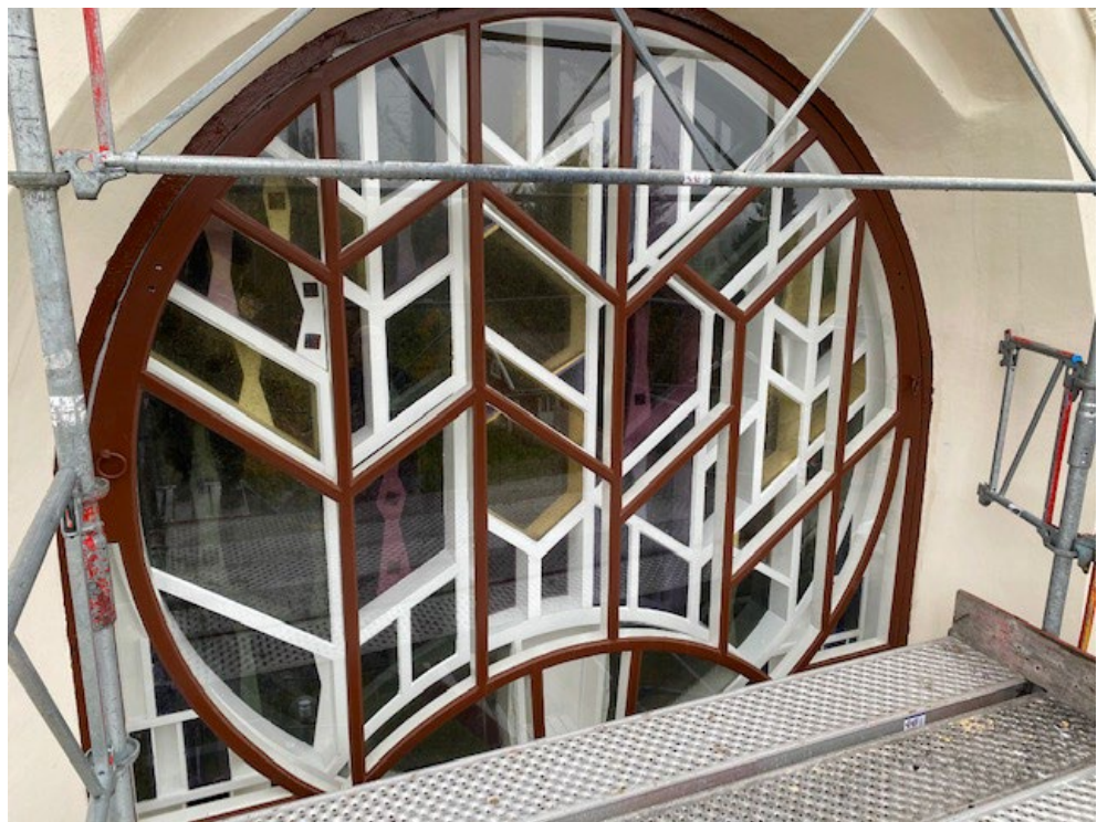
Figur 76. Körfönstrets övre del efter åtgärder.
