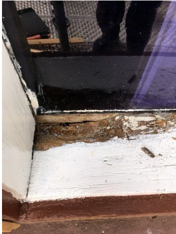
Figur 67. Omfattande rötskador i korfönstrets karmbottenstycke. Figur 68. Omfattande rötskador i korfönstrets karmbottenstycke.
