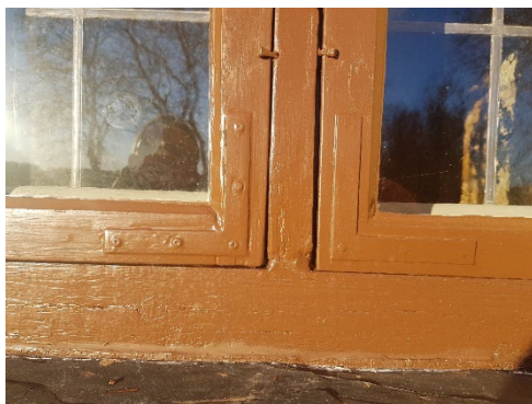
Figur 19. Åtgärdade börnjärn och inmålad fog under karm.
