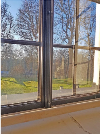
Figur 50. Innerbåge efter åtgärder.
