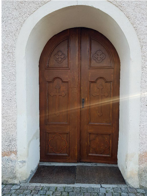
Figur 54. Västporten eklaserad.
