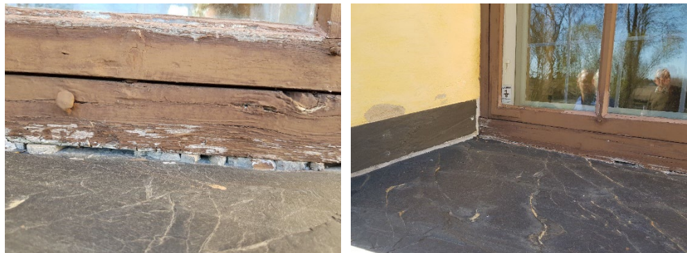
Figur 7. Befintlig fog mellan karm och solbänk.
