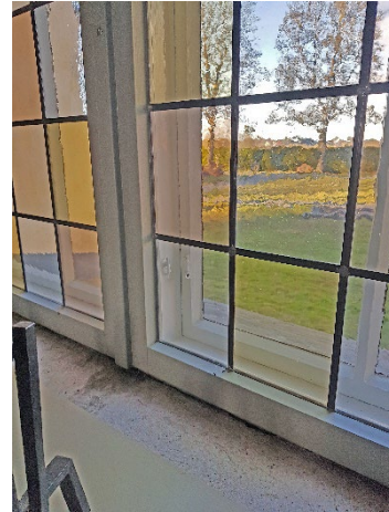
Figur 21. Åtgärdad fönsterbåge samt mörkare fog mot solbänken på sidorna. Figur 22. Ommålad innerbåge i kyrkorummet.
