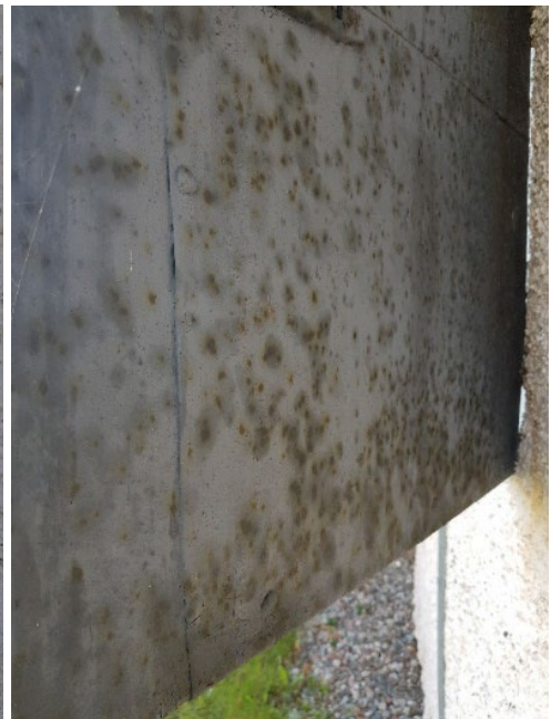
Figur 34. Norra sidan. Fog mellan puts och plåt. Skulle den åtgärdas?
