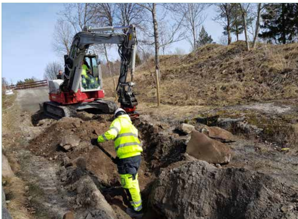
Figur 5. Schaktets norra del där schaktet breddades.
