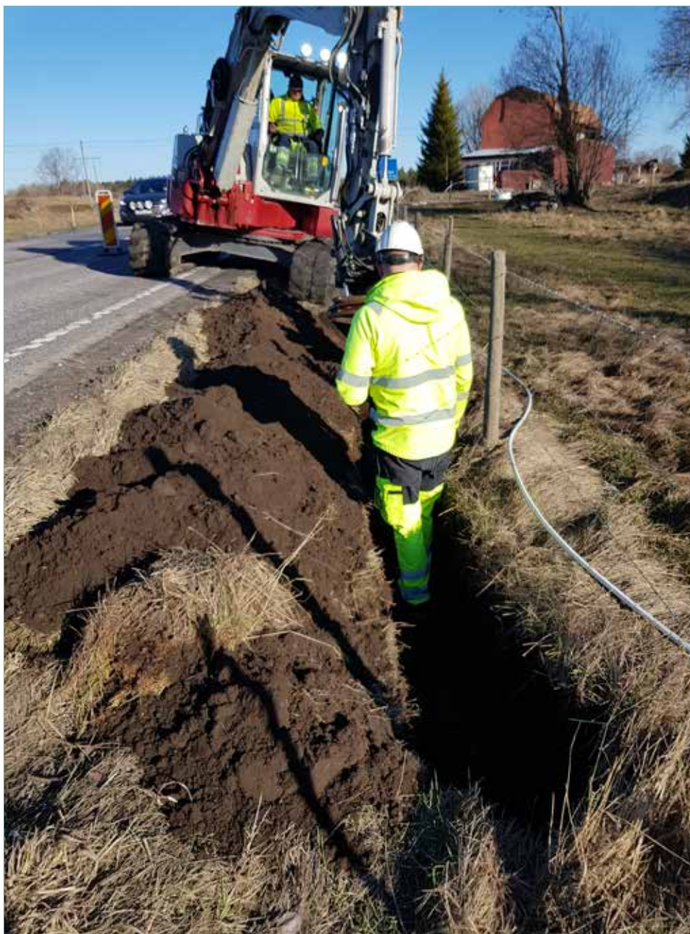
Figur 2. Schaktning. Foto från sydöst.
