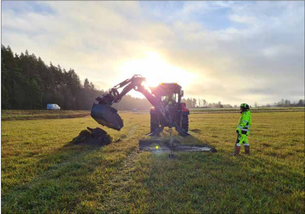
Figur 5. Schaktning i åker med vall nära Brunnby gård. Foto från nordväst.
