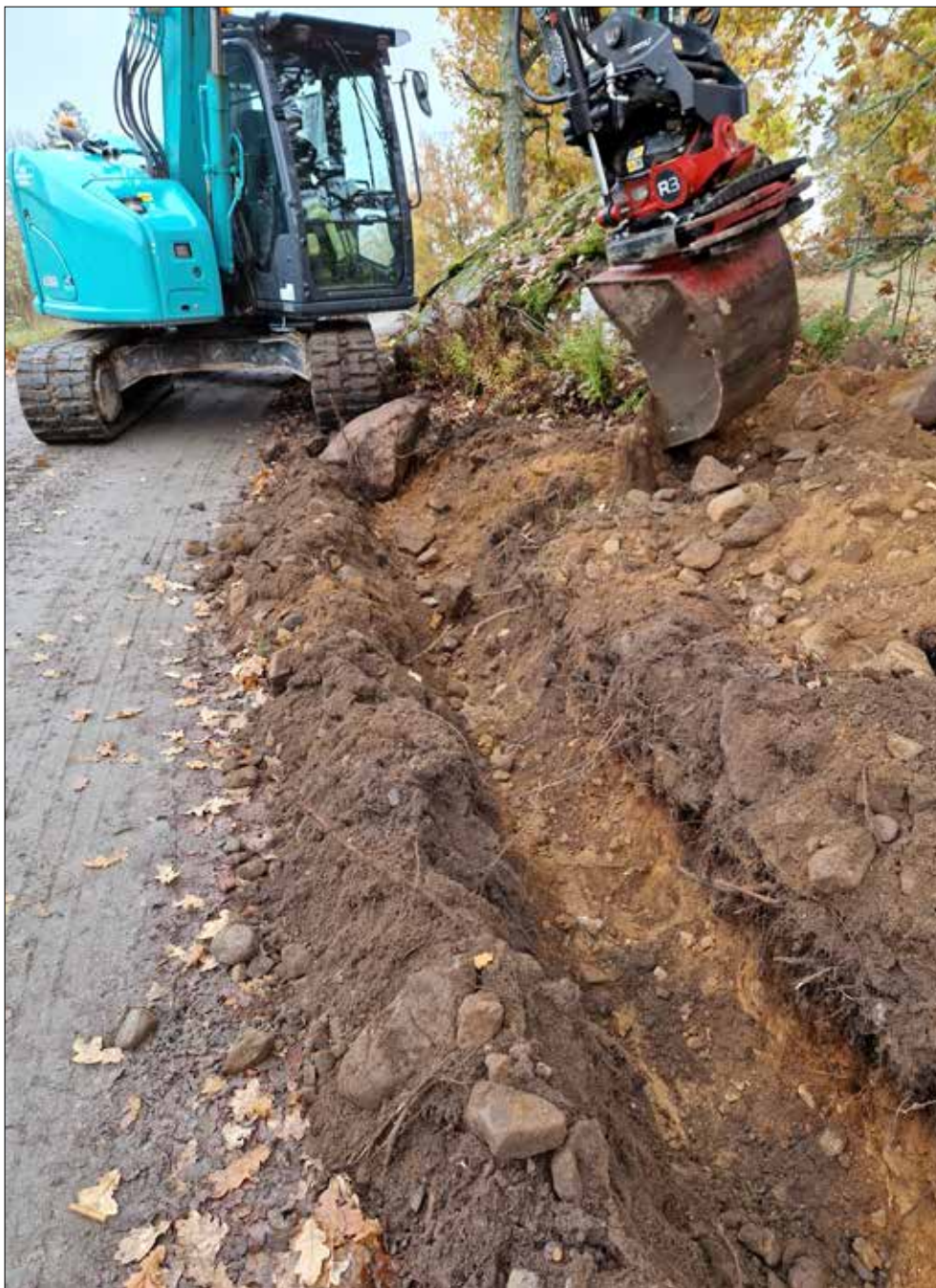
Figur 8. Översikt över schaktet. Undergrunden bestod av rödbrunt stenigt och sandigt grus med ställvis ljus beigebrun sand. SGU anger i jordartskartan över området att det består av sandig morän, vilket stämmer väl. Foto från nordväst.
