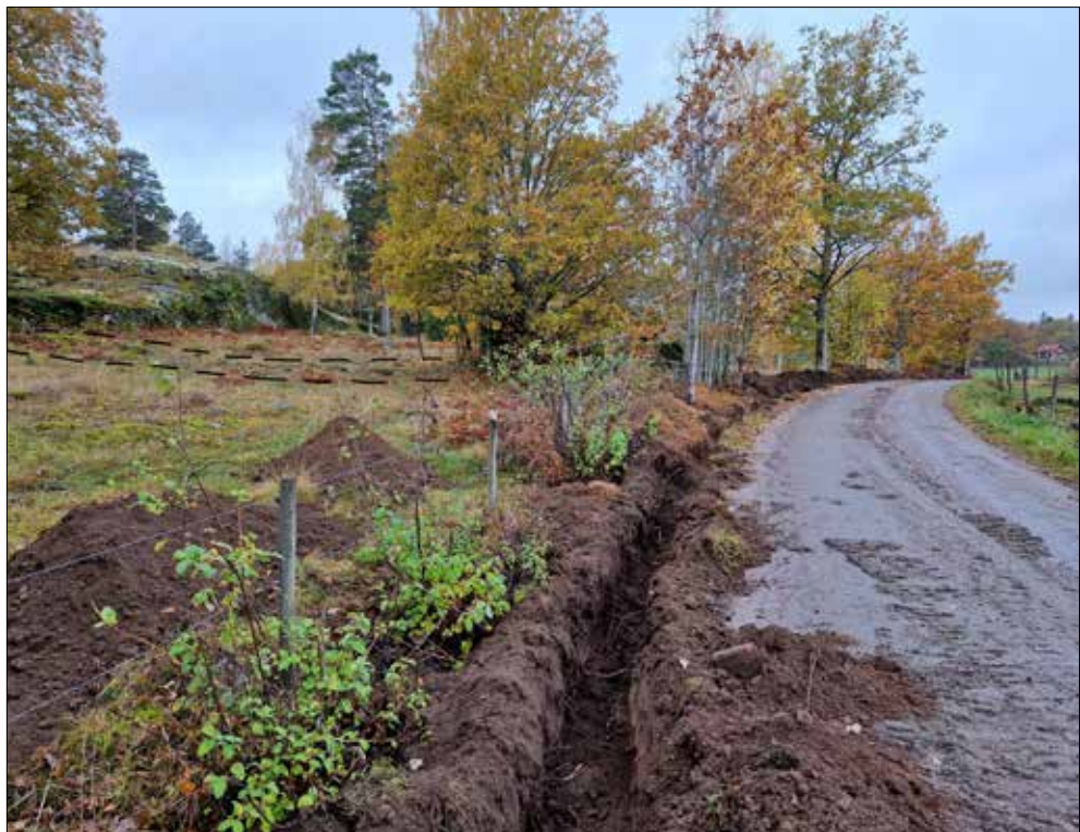
Figur 7. Översikt över schakt och grusväg. Stensträngen L2010:8362 är markerad med svarta streck. Foto från östsydost.
