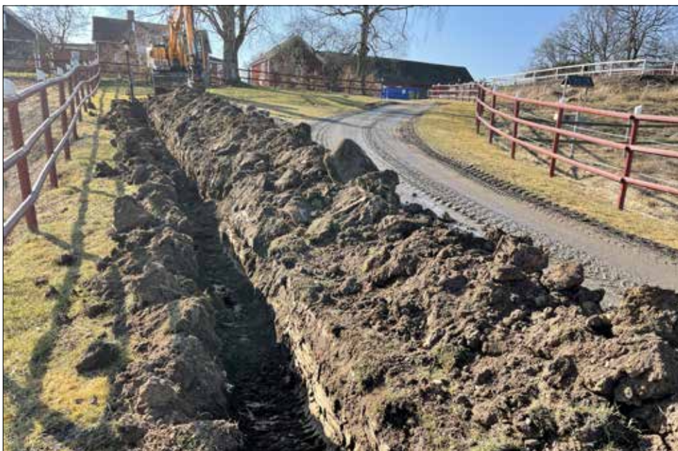
Figur 43. Översikt över schakt 700. I bakgrunden syns byggnader vid Västergården (fastigheten Särstad 9:2). Foto Fredric Wirbrand från norr.
