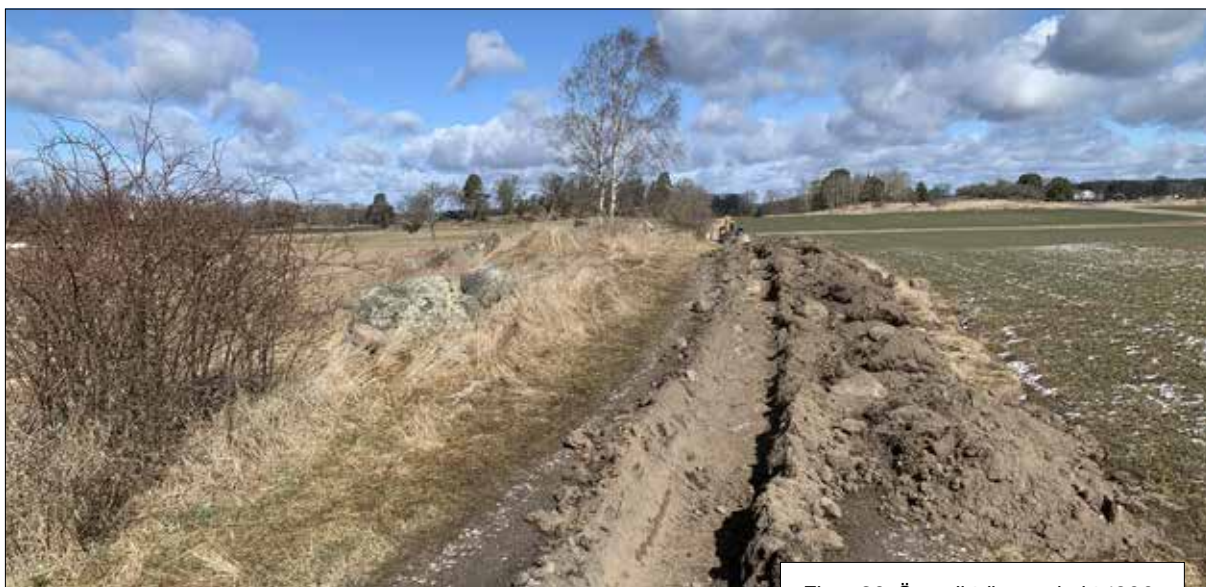
Figur 39. Översikt över schakt 1200. Foto från söder.
