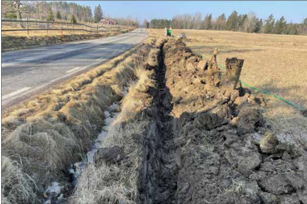
Figur 42. Översikt över schakt 600. Foto Fredric Wirbrand från öster.
