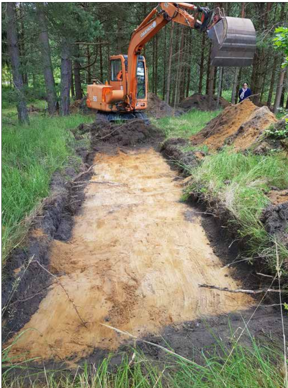
Figur 7. Schakt 289 från norr.
