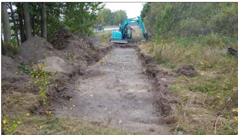
Figur 40. Schakt 12000 med kvarliggande kulturlager. Foto från öster.
