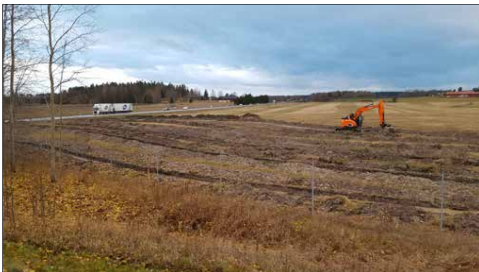
Figur 61. Schaktning pågår inom lokal 10. Foto från öster.
