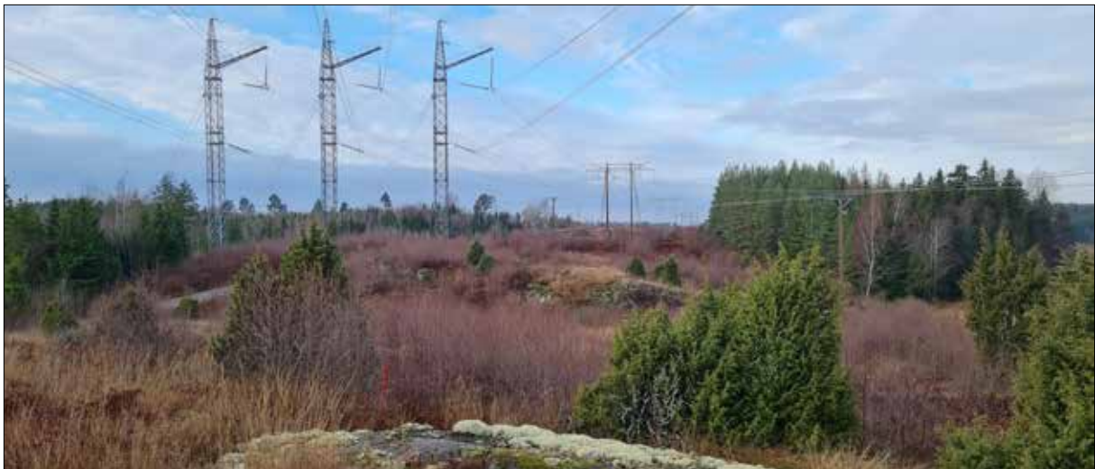
Figur 4. Exempel på den höglänta marken i västra delen. Foto från nordöst.
