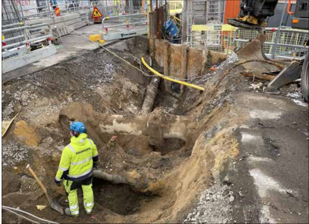
Figur 6. Schaktet, färdiggrävt, från söder.
