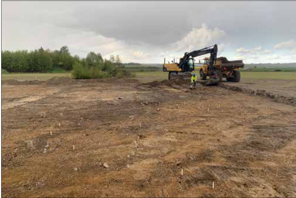
Figur 18. Schaktning pågår i den sydvästra delen av undersökningsområdet. Foto Marcus Asserstam från nordöst.
