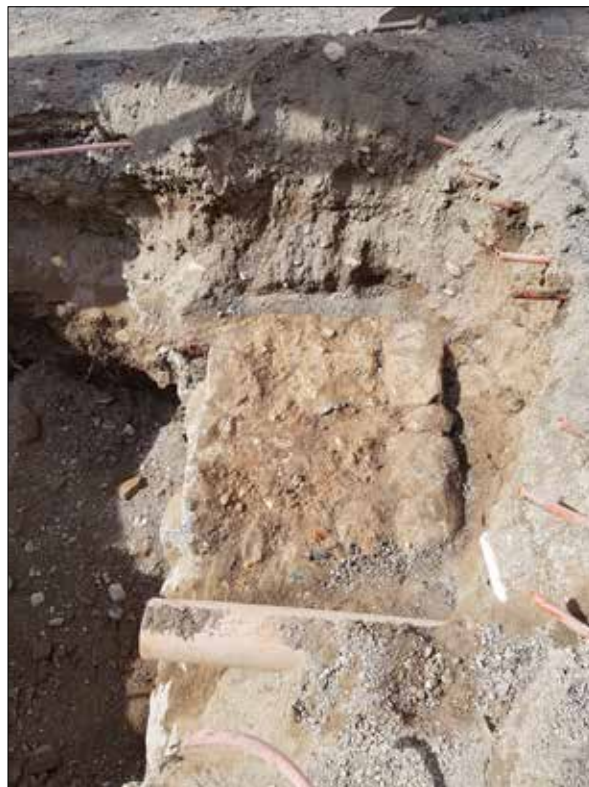
Figur 56. Delar av kyrkogårdsmurens övre del frilades och dokumenterades innan den delen grävdes igenom. Foto från sydöst av Jonas Ros.
