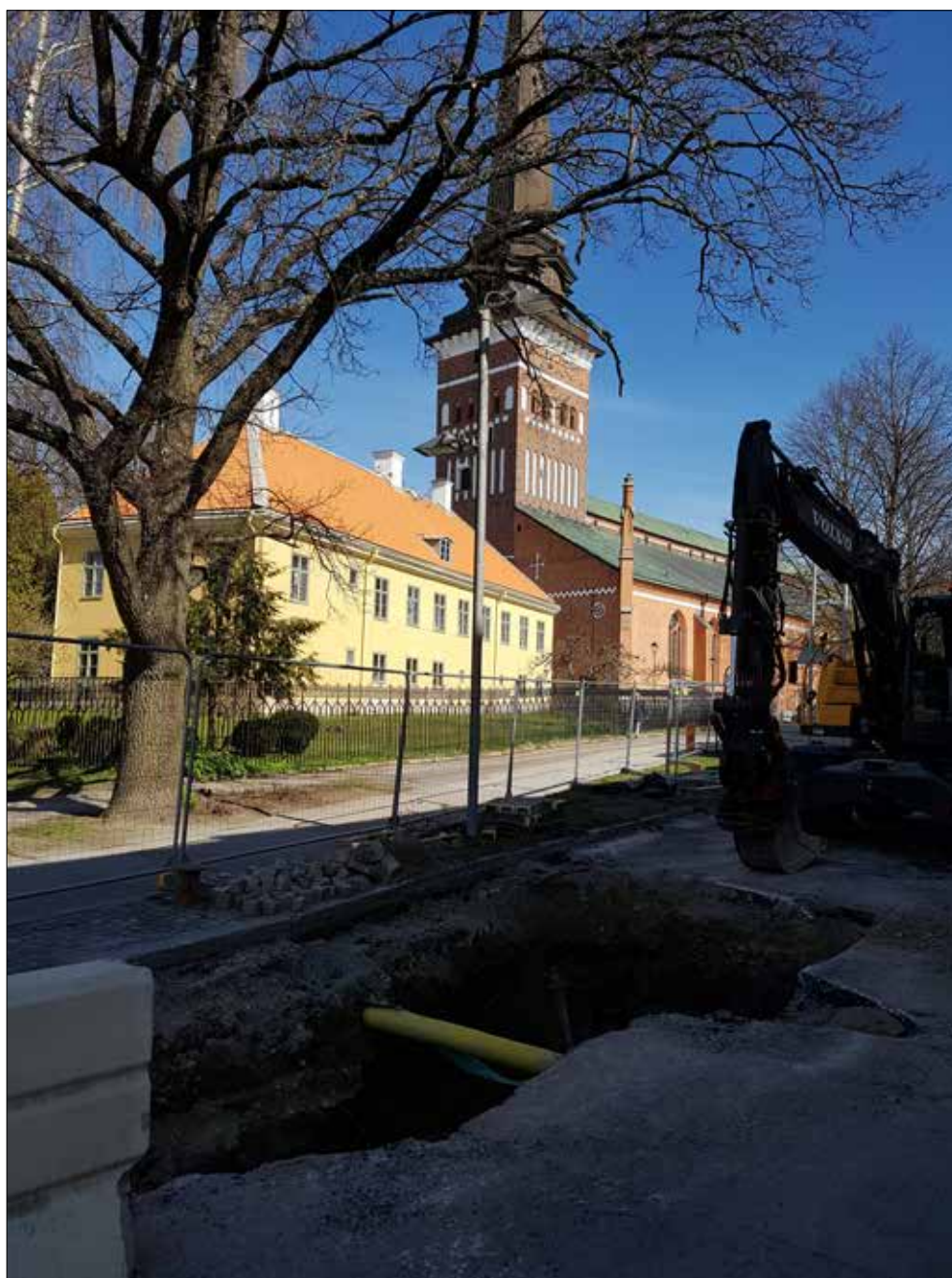
Figur 51. En del av Biskopsgatan med schakt 7 i förgrunden. Bakom schaktet syns den gula Biskopsgården och där bakom tornar domkyrkan i tegel upp sig. Foto av Jonas Ros från sydväst.
