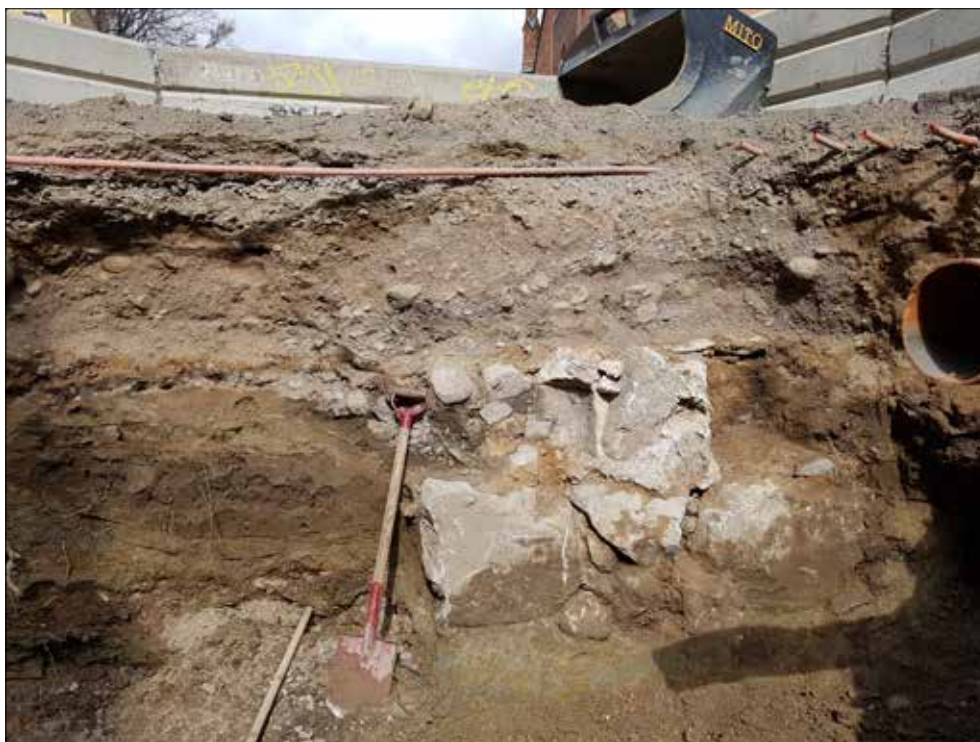
Figur 54. I norra schaktväggen i schakt 6 syns kyrkogårdsmuren A326 i sektion efter att denna grävts igenom. Väster om den (vänster i bild) låg flera skikt av kulturlager. I bakgrunden skymtar domkyrkan. Foto från söder av Jonas Ros.
