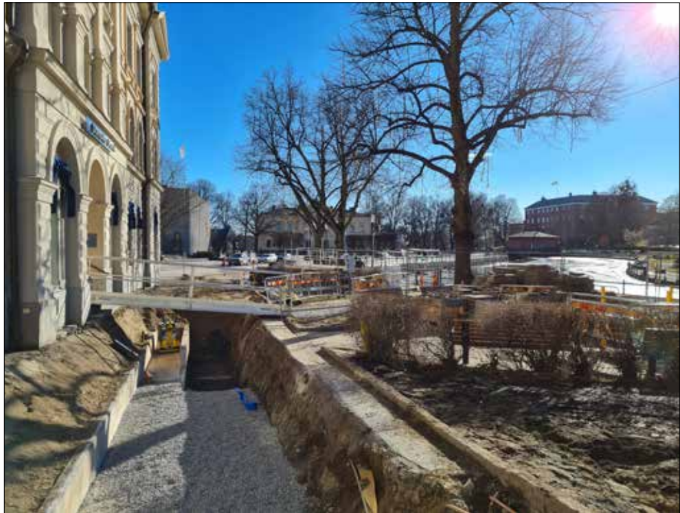
Figur 11. Södra delen av delområde A sedd från norr. Resterna av kulverten till vänster i schaktet var från en befintlig fjärrvärmeledning som breddades (schakt 2), medan ny vattenledning lades öster om den gamla kulverten (höger i bild) och grävdes avsevärt djupare (schakt 1). Jugendbyggnaden till vänster i bild kallas Stora Westmannina och uppfördes på platsen för det gamla hospitalet, tidigare helgeandshus. I bakgrunden skymtar Fiskartorget med Stadshuset och gamla rådhuset, och till höger bortanför ån syns slottet.
