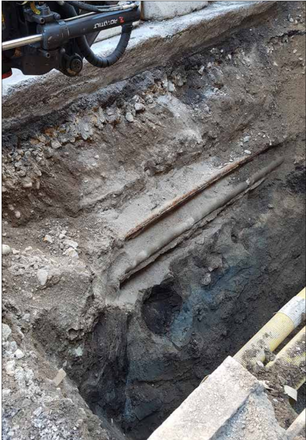
Figur 47. Kulturlager i östra schaktväggen i schakt 3. Foto från norr.
