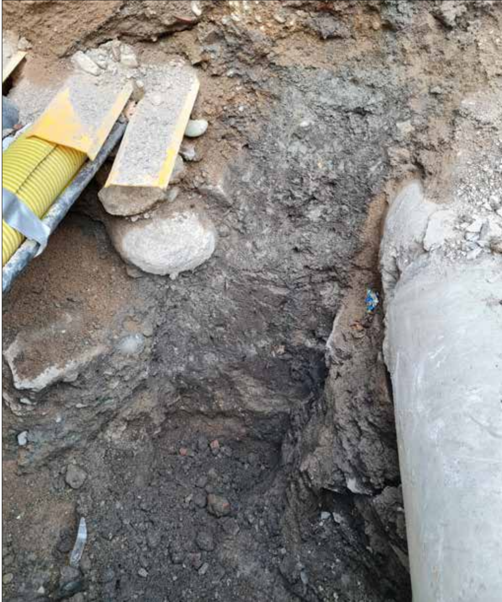
Figur 61. Foto taget från söder på kulturlagren i norra schaktväggen. På båda sidor av kulturlagren var det stort av ledningar.
