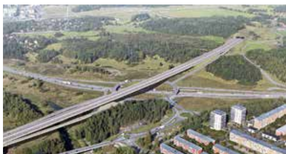
Flygfoto över Hjulstaområdet från sydöst, med E4 Förbifart Stockholm som den kommer se ut när det är färdigt.
