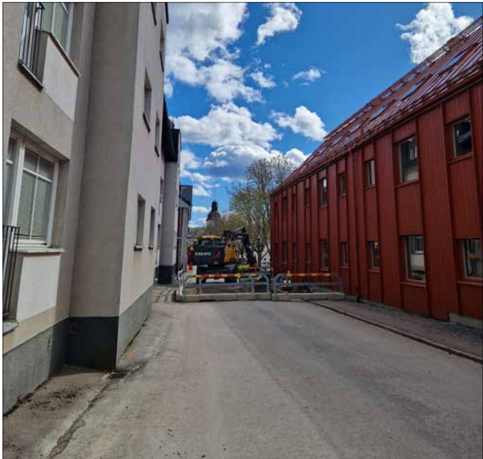
Figur 6. Översikt som visar schaktet i Hökenbergs gränd. Foto från norr.
