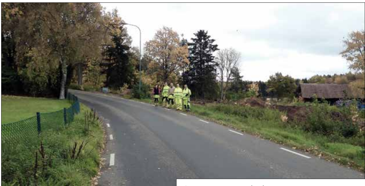
Grävteamet 2021. Vi står på exakt samma plats som T.J. Arnes "gräv gång" på bilden från 1915. Foto Lennart Eriksson.
