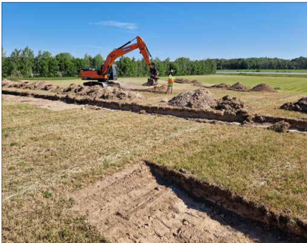
Figur 18. Schaktning i objekt 2. Foto från söder av Mattias Johansson.
