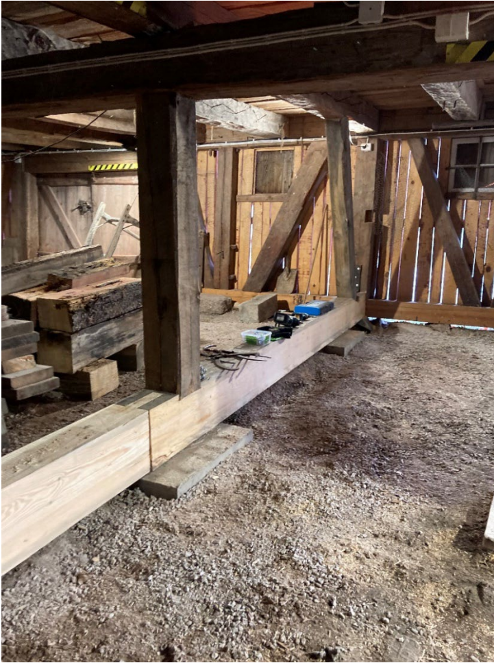
Figur 10 Ny stock med underliggande stenar mot märkfukt.
