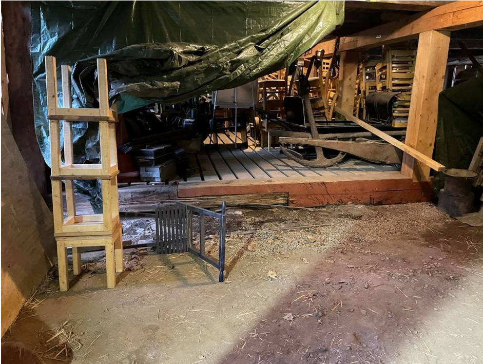
Figur 3 Det uppreglade golv innan rivning.
