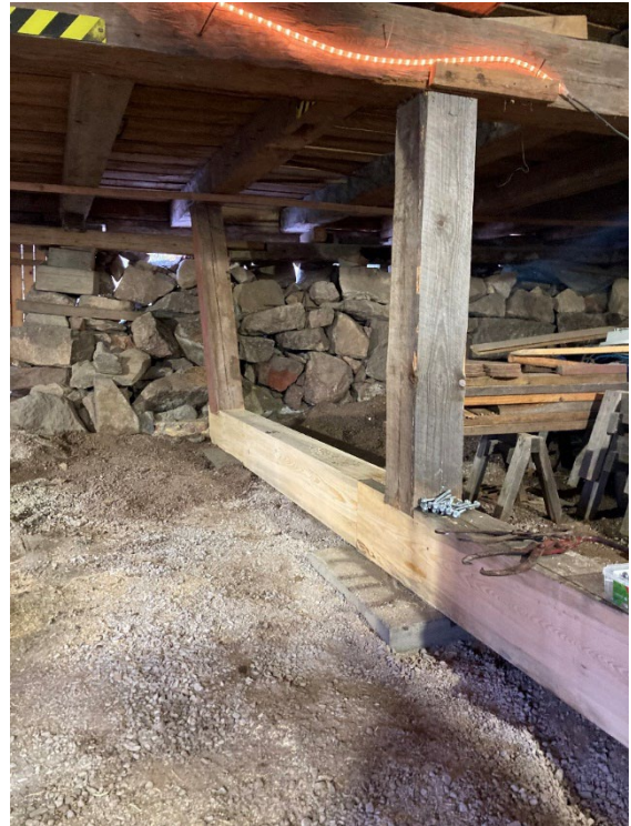
Figur 9 Byte av stock i norra delen vid kallmur.
