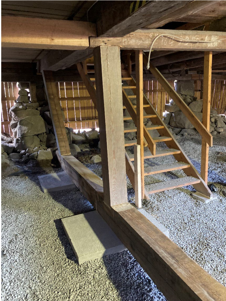
Figur 13 Ny stock och trapp med underliggande stenar och ny marksingel.
