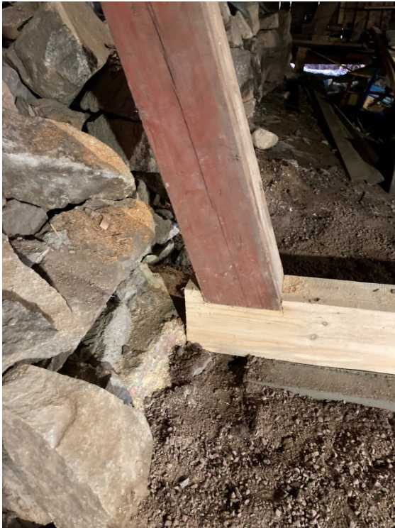
Figur 9 Byte av stock i norra delen vid kallmur.
