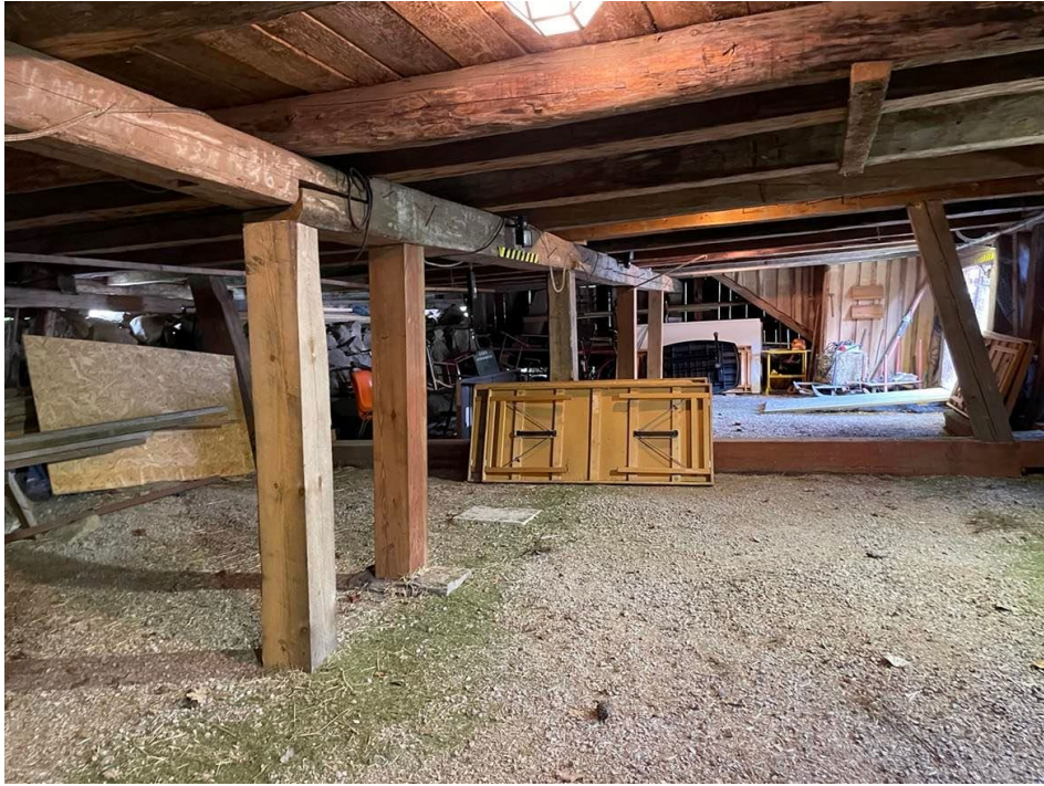
Figur 5. Bild innan åtgärder mot norr med kallmur till vänster i bild.
