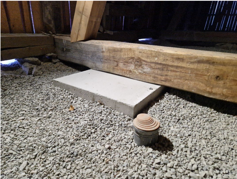
Figur 112 Singel återfördes som märkunderlag. Stenar placerades under timret som barriär mot märkfukt.
