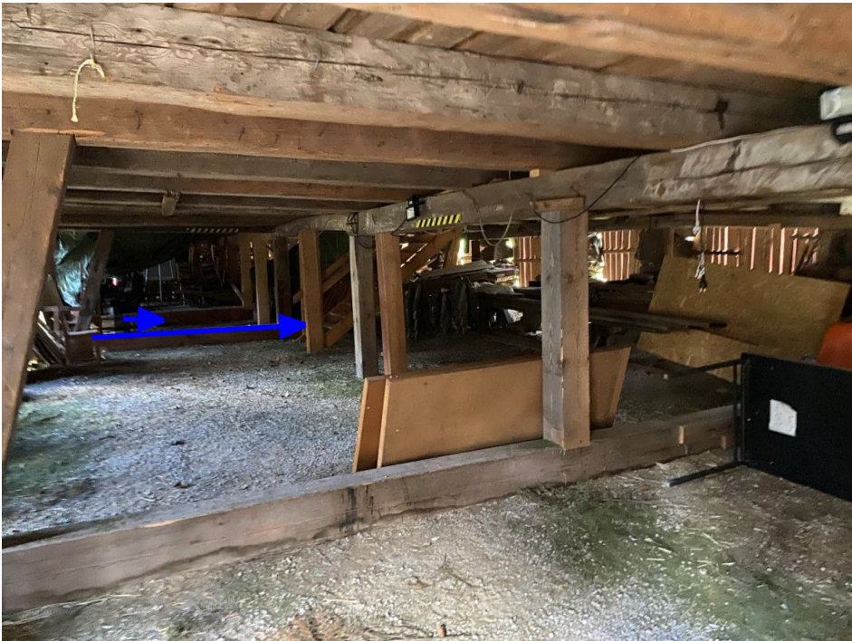
Figur 4. Pilar visar var svampen angripit. Bild från Recover.
