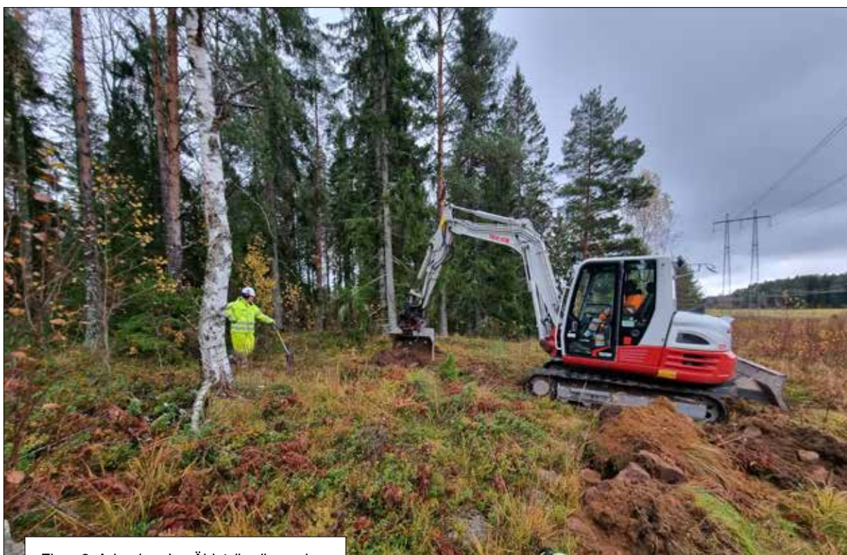
Figur 3. Arkeolog Jan Ählström övervakar schaktningsarbetet vid det södra undersökningsområdet intill L1950:7077. Foto från norr.
